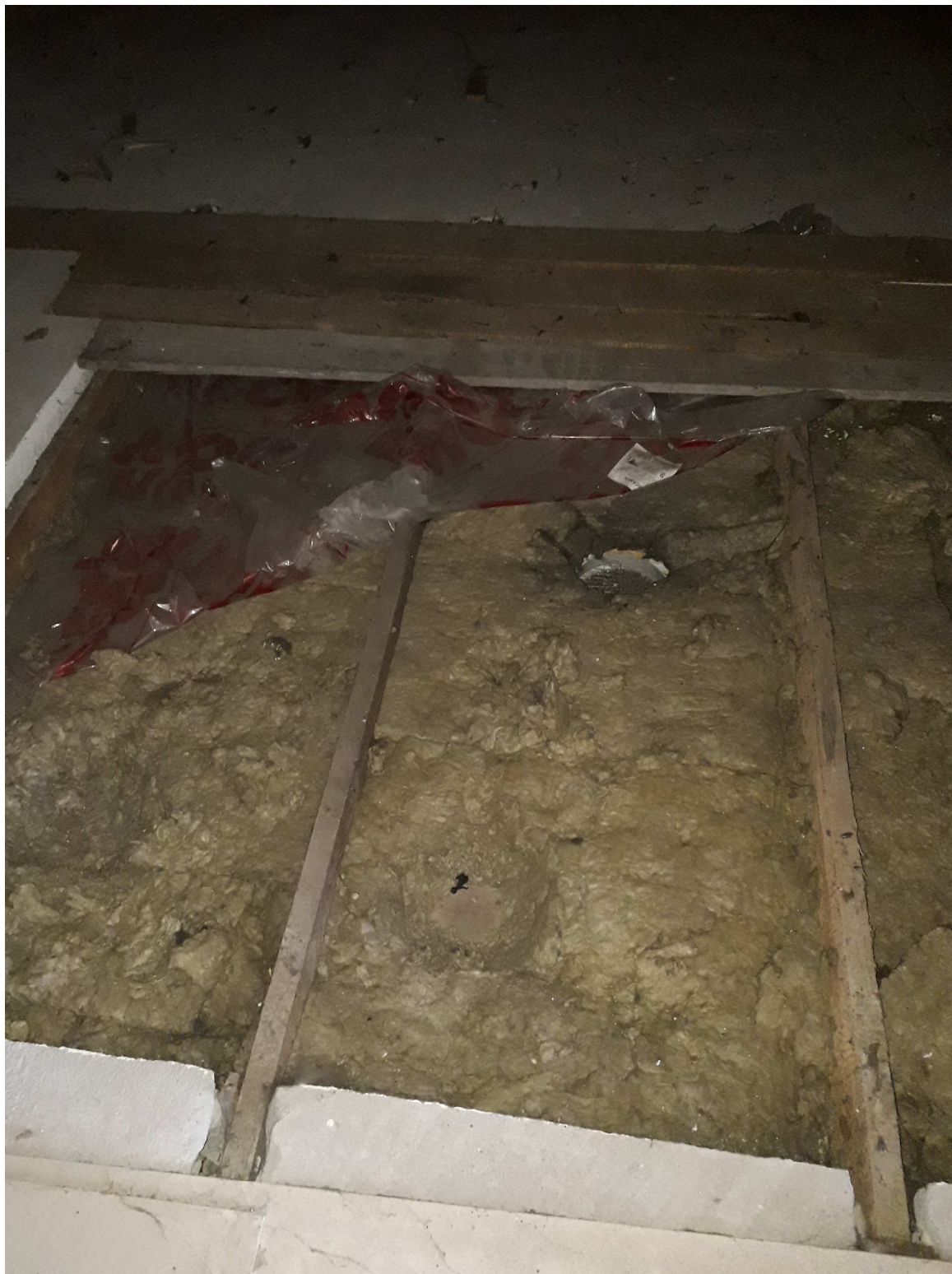
Fot. nr 1. Widok nadszybia windy – konstrukcja drewniana
