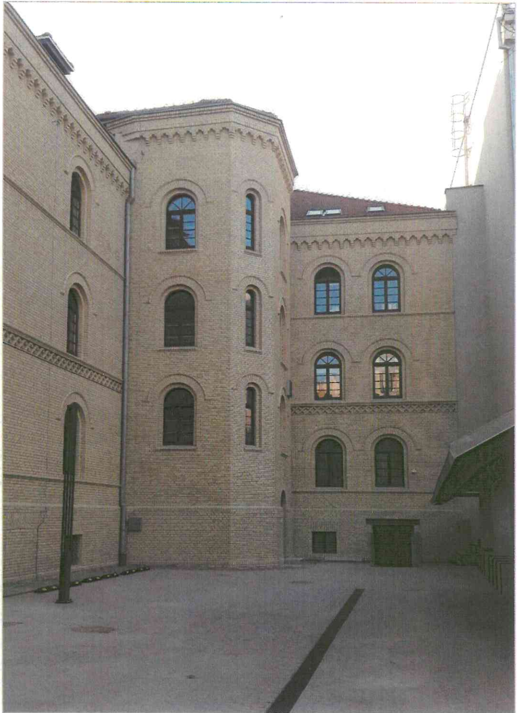
fol.16 Dziedziniec wewnętrzny, wieża klatki schodowej przy skrzydle wschodnim – elewacje po przeprowadzonych pracach konserwatorskich. Projekt nie przewidywał odtworzenia krenelaża wieńczącego , dlatego też zachowana została forma dachu z okresu powojennej odbudowy
