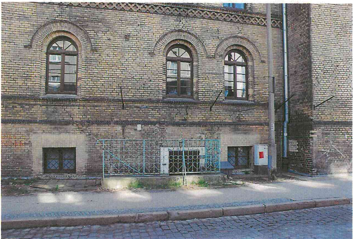
fot.57 Wtórne wejście przeznaczone do likwidacji
