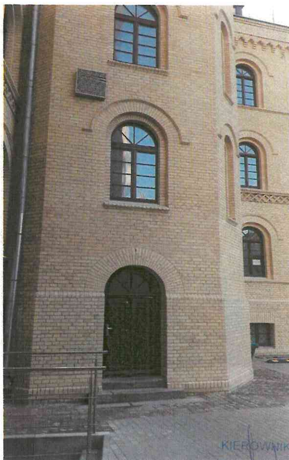
fot.13-14 Fragmenty elewacji wewnętrznych po przeprowadzonych pracach konserwatorskich.
