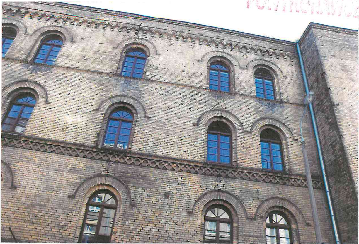
Fot.56-57 Stan zachowania elewacji zachodniej przed rozpoczęciem prac
