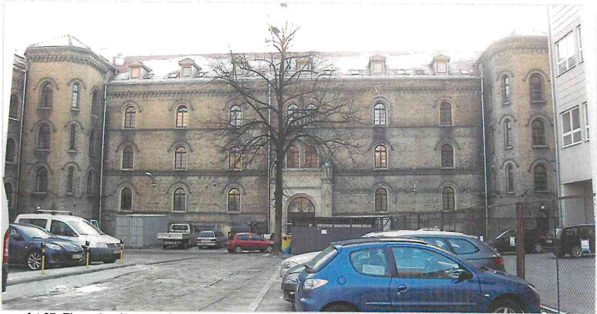
fot.27 Elewacja północna , frontowa - od strony wewnętrznego dziedzińca, stan przed rozpoczęciem prac
