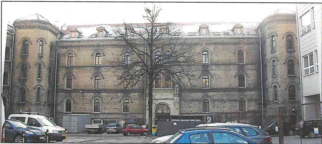
Fot.13 Widok na elewację północną - od strony dziedzińca - przed rozpoczęciem prac
