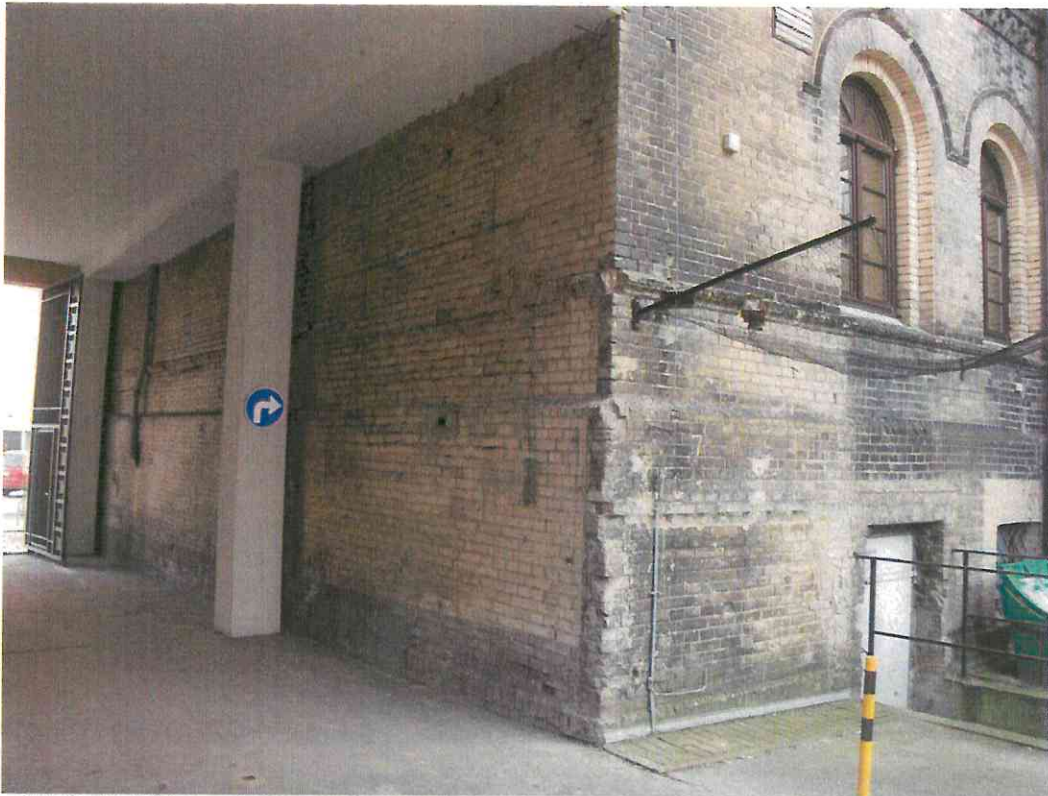
fot.39 -40 Widok na ścianę przejazdu bramnego, fragment dawnej elewacji ryzalitu wschodniego , na fotografii poniżej widoczny brak gzymsu cokołu, białą strzałką oznaczono zamurowane okno.
