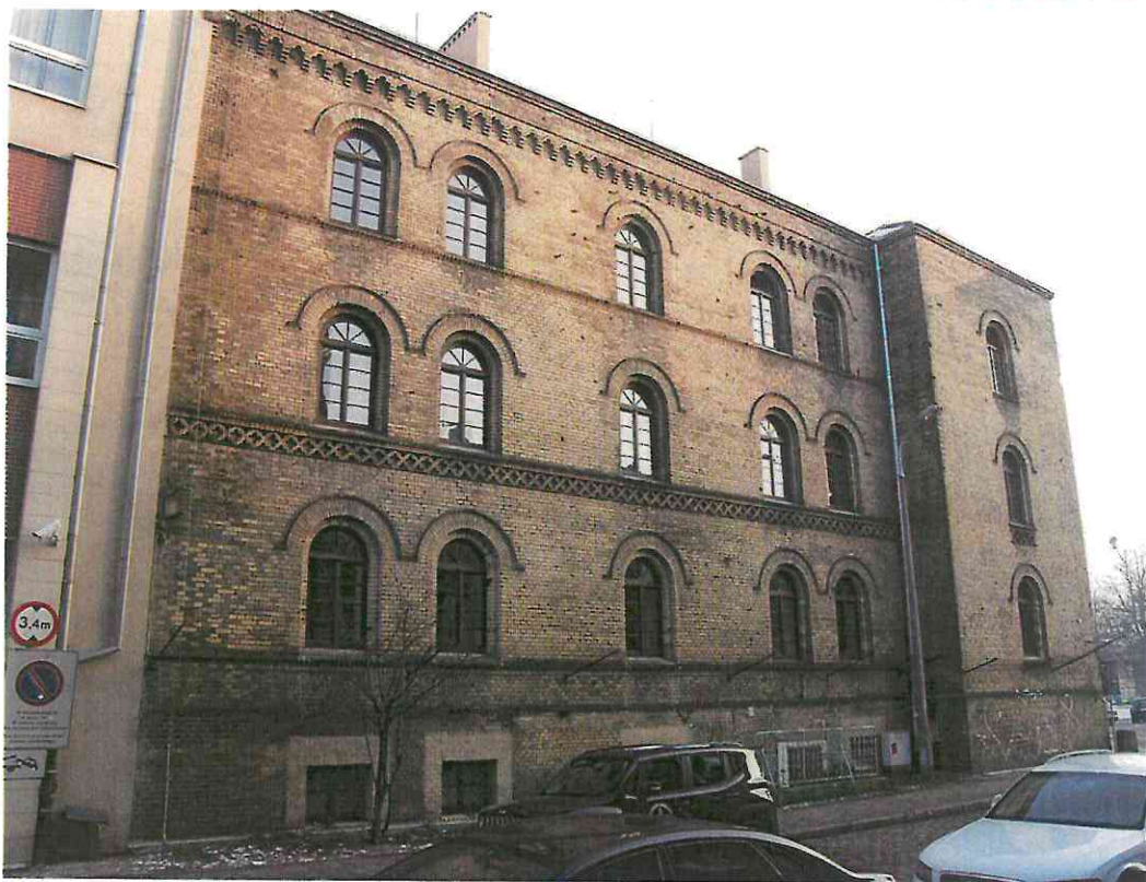
fot.53.-54 Widok ogólny na elewację od strony Ulicy Rzeźnickiej
