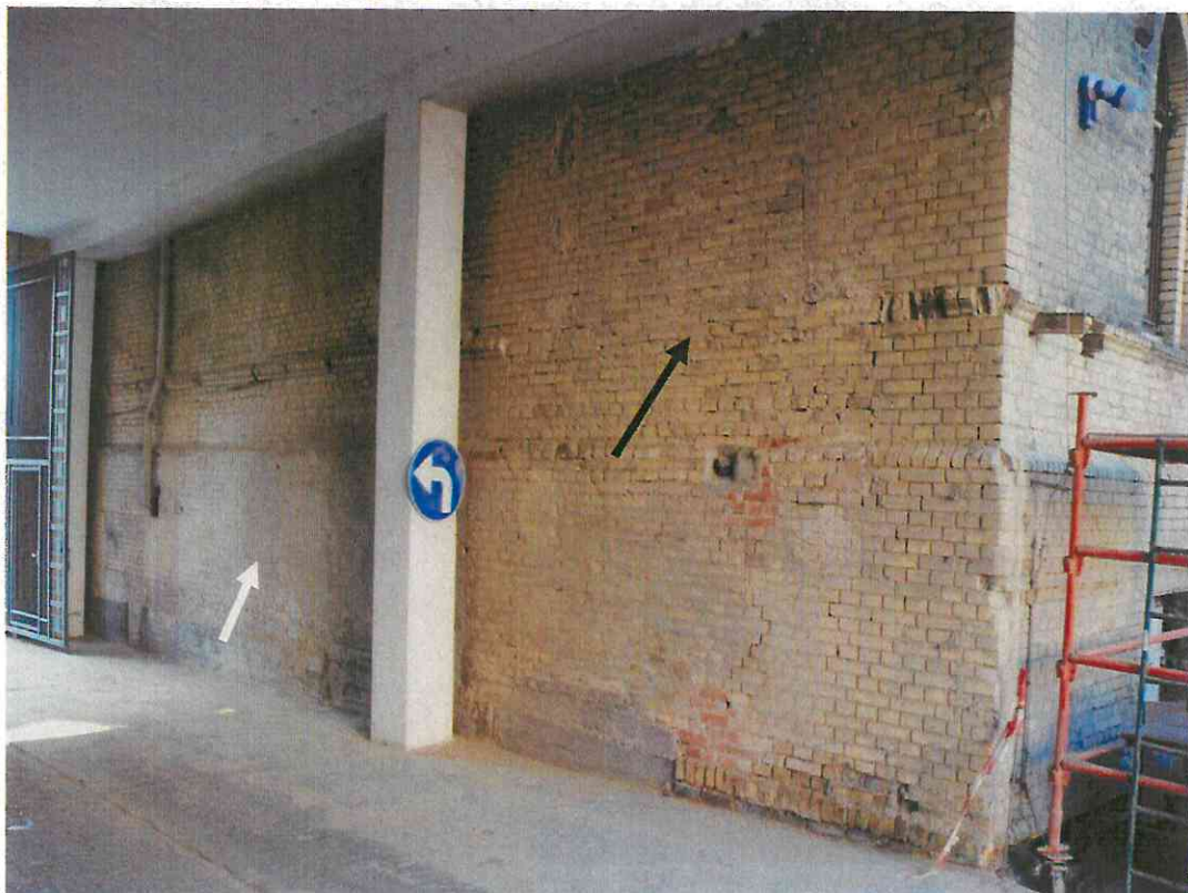
fot.39 -40 Widok na ścianę przejazdu bramnego, fragment dawnej elewacji ryzalitu wschodniego , na fotografii poniżej widoczny brak gzymsu cokołu, białą strzałką oznaczono zamurowane okno.
