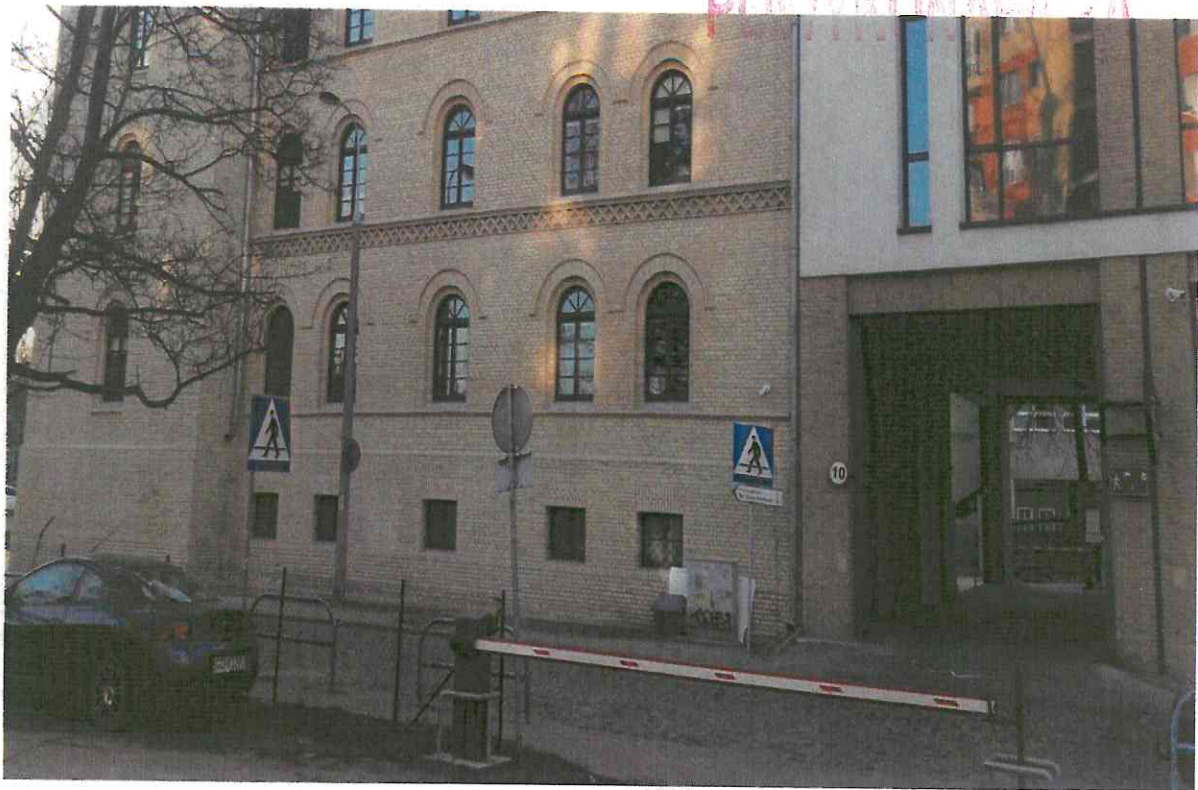
fot.9 Fragment elewacji od ulicy Rzeźnickiej po jej stronie prawej widoczny przejazd bramny prowadzący na wewnętrzny dziedziniec koszar
