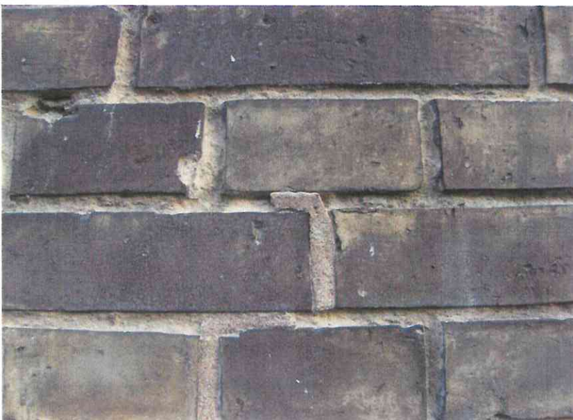
fot.63 Stan zachowania muru na styku z nawierzchnią chodnika, grube, szczelne nawarstwienia, brak spoin.
