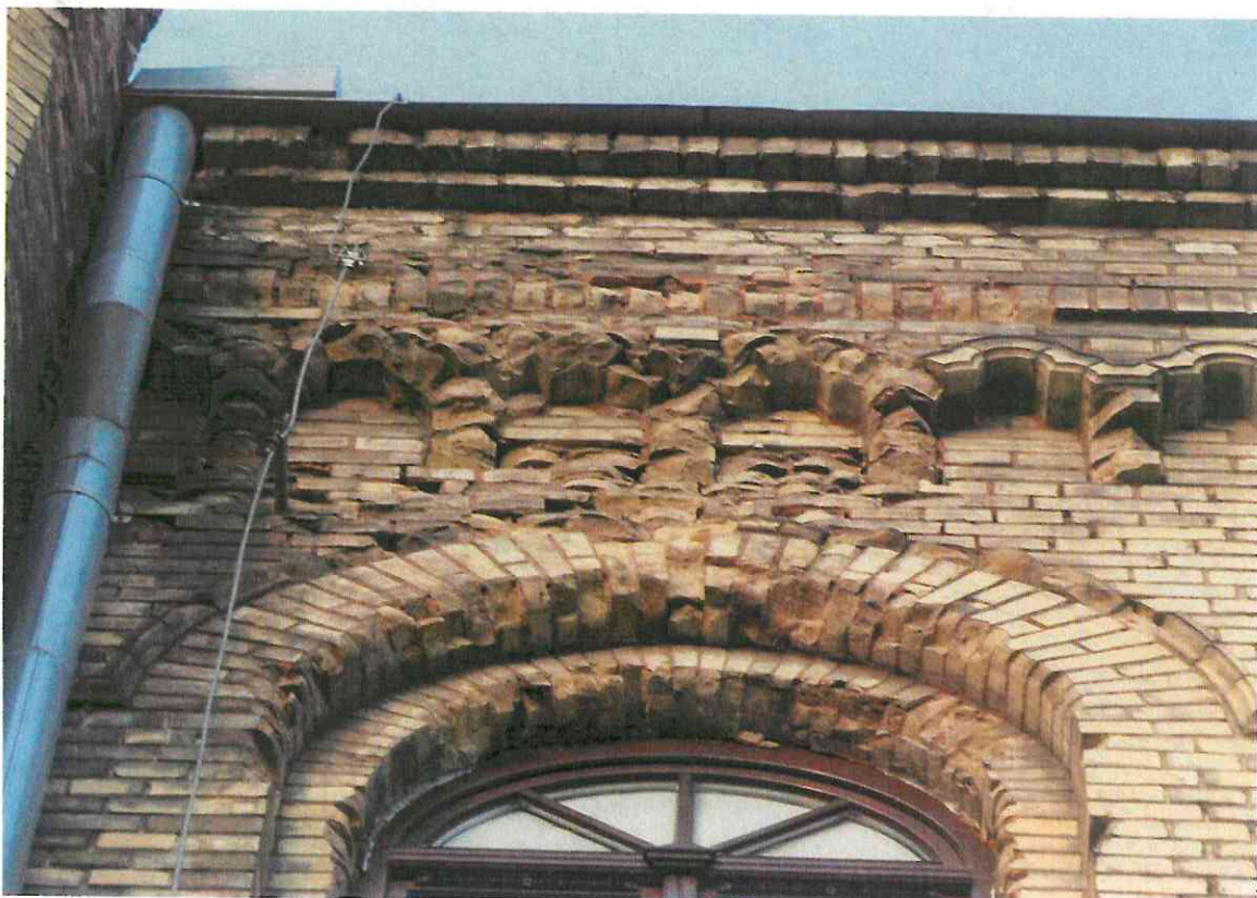
fot.18 -19 Stan zachowania gzymsu kordonowego i górnych partii elewacji frontowej , rozległe ubytki cegieł i kształtek spowodowane uszkodzeniami mrozowymi ( mansarda z nowym oknem ze złotymi szprosami)
