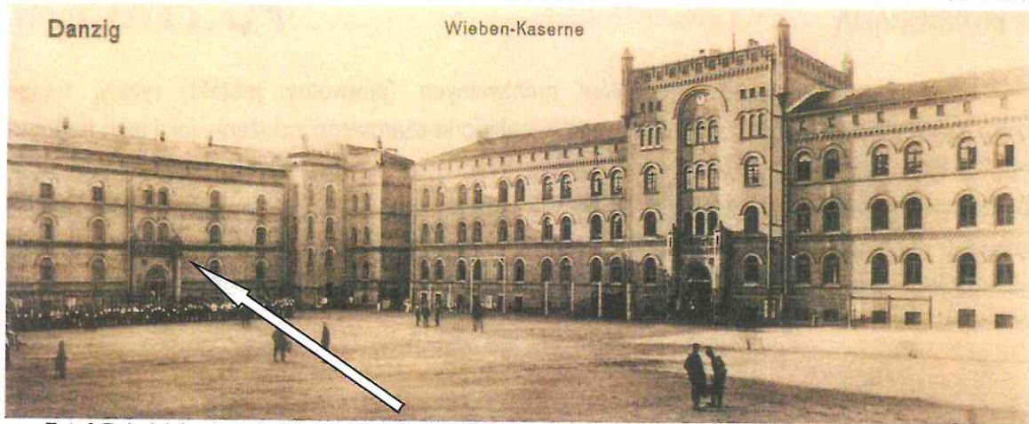
Fot. 3 Działanie koszar Wiebego, skrzydło południowe i zachodnie zespołu. Poczta - rok 1915 rok. Oznaczono elewację północną skrzydła południowego, która poddana została pracom konserwatorskim, skrzydło zachodnie zniszczone zostało przez wojska sowieckie, obecnie w tym miejscu jest nowy gmach Urzędu Skarbowego
