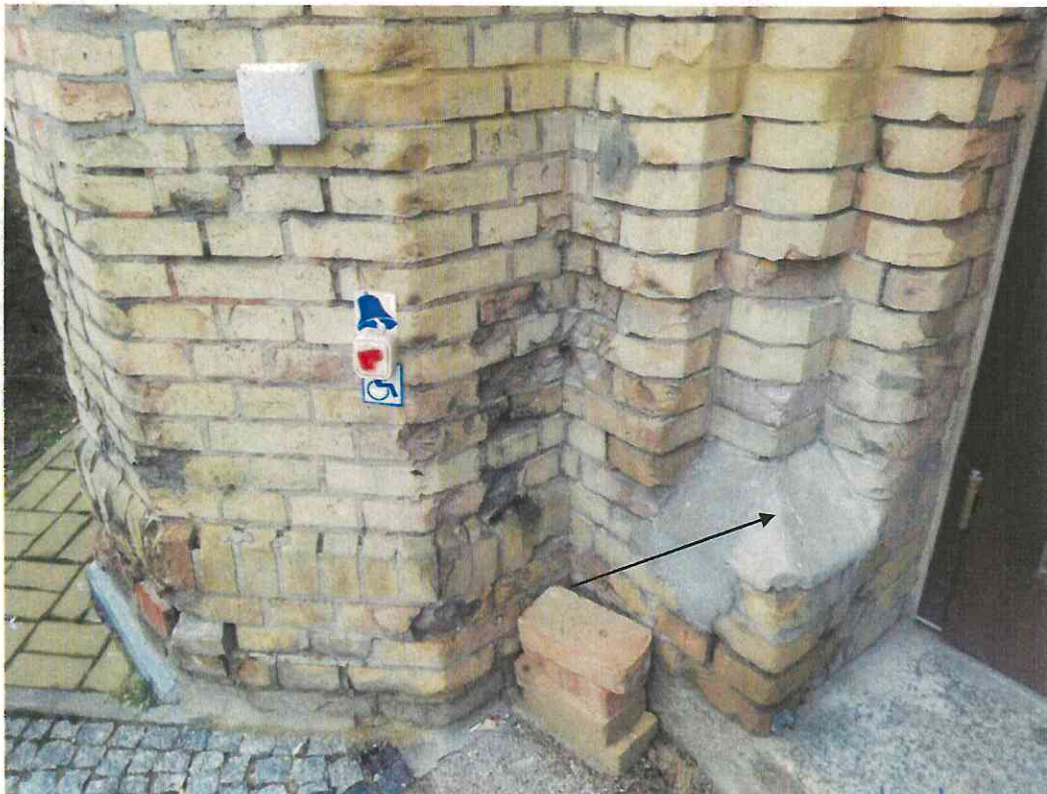
fot.15 Ubytki w ceglach i kamiennym detalu uzupełnione zaprawą cementową.
