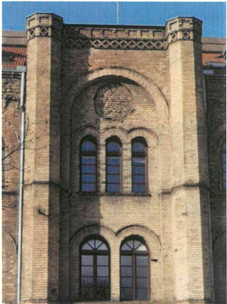
fot.8-9 Górna partia ryzalitu wejścia głównego
