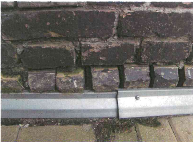
fot.63 Stan zachowania muru na styku z nawierzchnią chodnika, grube, szczelne nawarstwienia, brak spoin.
