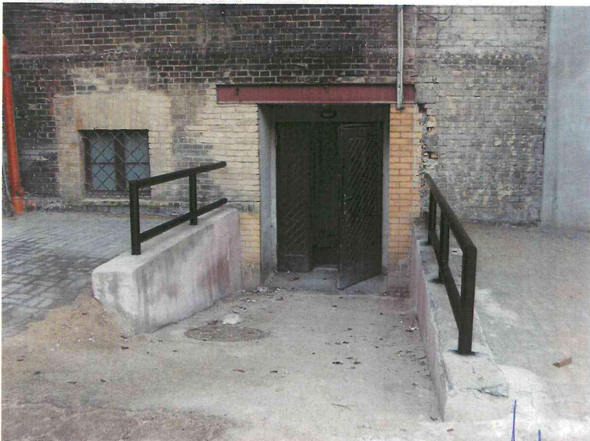
fot.38 Wtórne wejście w I kondygnacji skrzydła zachodniego . KIEROWNIK BUDOWY
