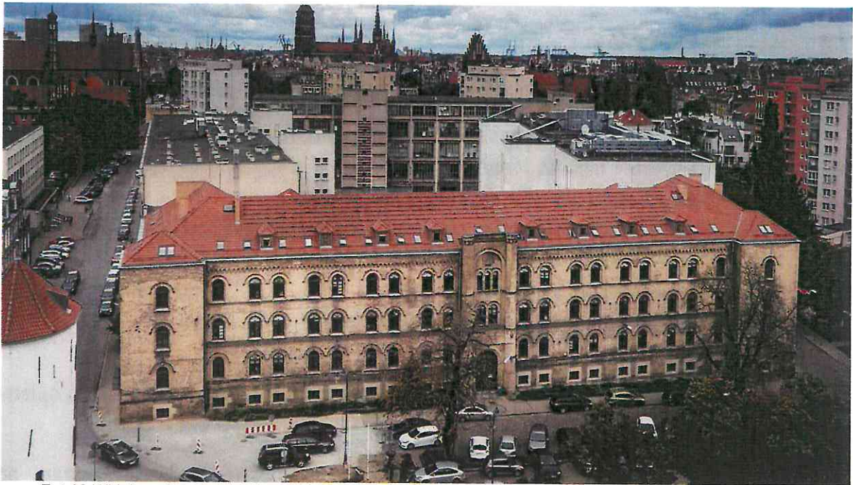
Fot.10 Widok na fasadę i bryłę południowej części koszar Wiebego w Gdańsku, przed rozpoczęciem prac. Fotografia ze strony https://www.ndi.pl/budynek-urzedu-marszalkowskiego-przy-ul-augustynskiego-zostanie-zrewitalizowany
