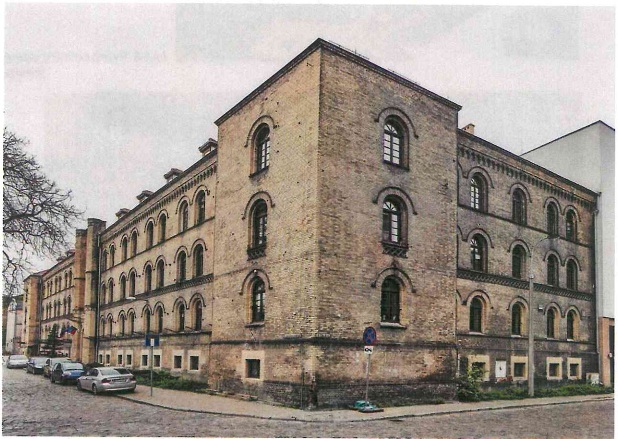
fot.4 Widok na elewację frontową od strony ulicy Zabikręka
