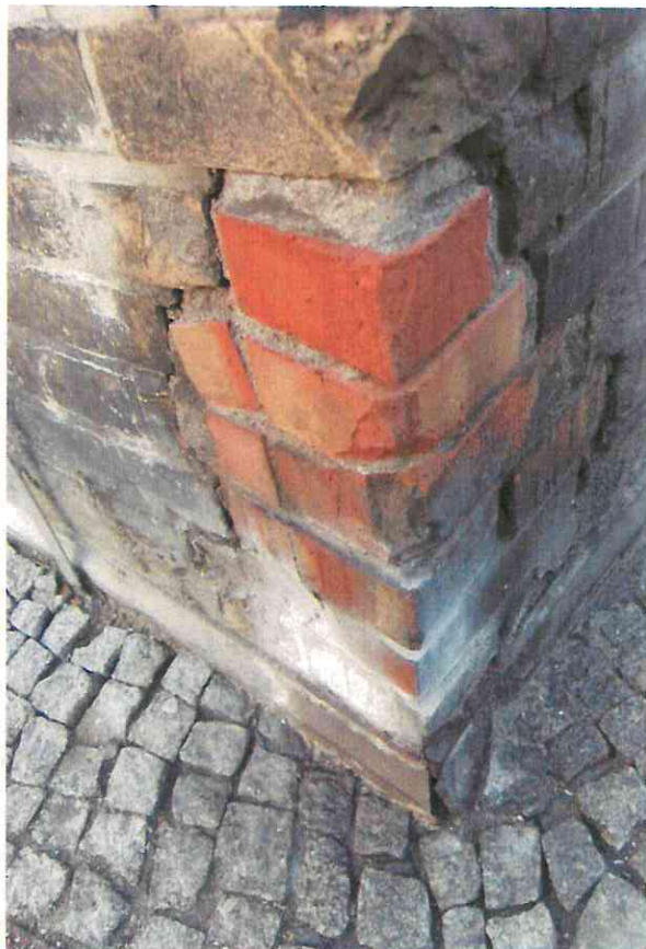
Fot.26. Ryzalit wschodni – zniszczenia w partii przyziemia i nieestetyczny, niefachowo uzupełniony narożnik cokołu.
