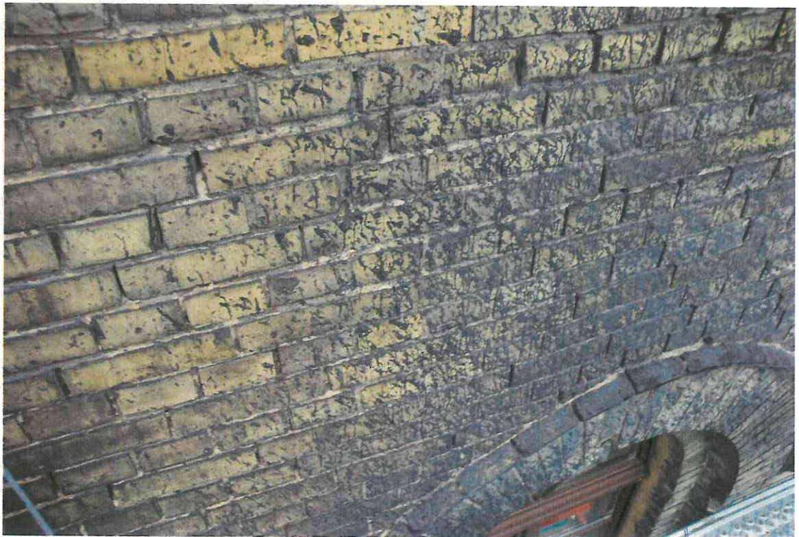
fot.32-33 Zabrudzenia elewacji substancją bitumiczną – smołą lub lepikiem.
