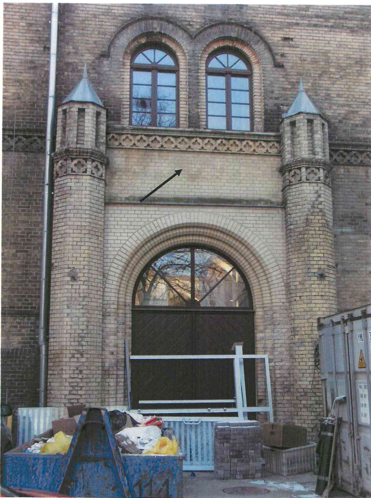
fot.28 Dawny przejazd bramny. Drewniane wrota bramne zasłaniają nową ścianę obecnej klatki schodowej, oznaczona partia ścian wykończona zaprawą betonową malowana w kolorze ceglanych kształtek ifug.
