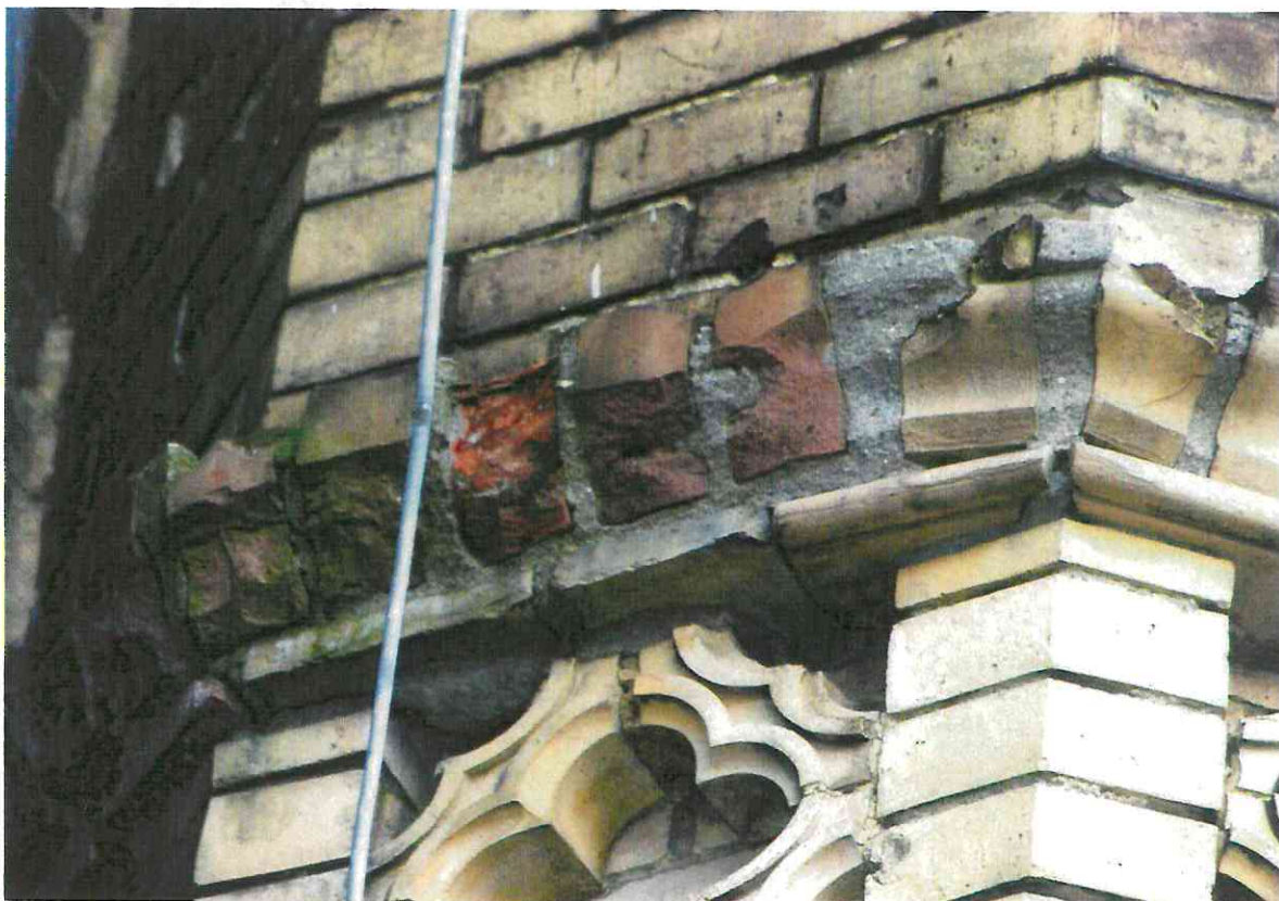
fot.17 Nieprawidłowe uzupełnienia ubytków kształtek we fryzie ; cegłą czerwoną na zaprawie cementowej.
