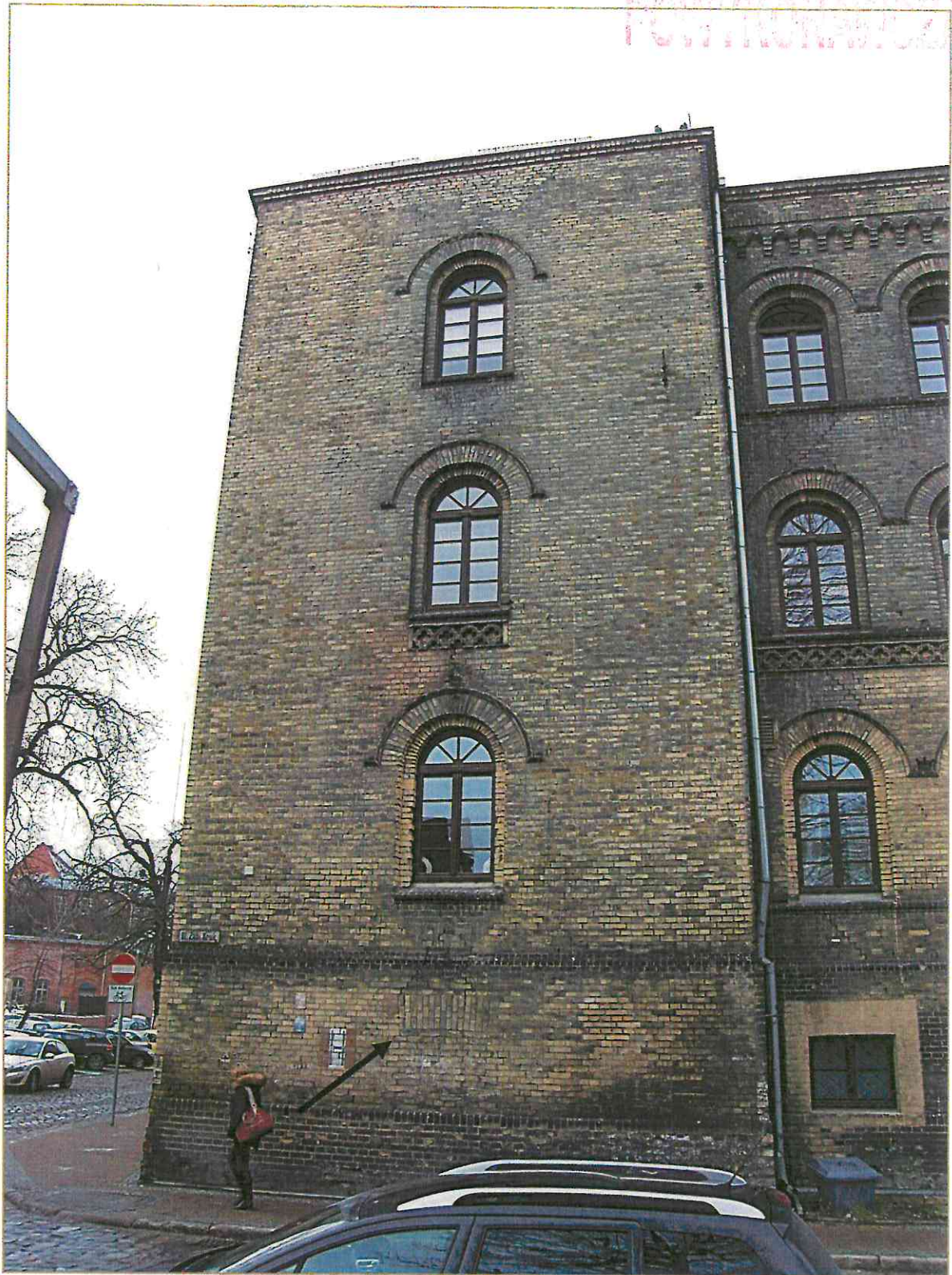
fot.41 Ryzalit narożny. W strefie cokołowej widoczne zamurowane okno.
