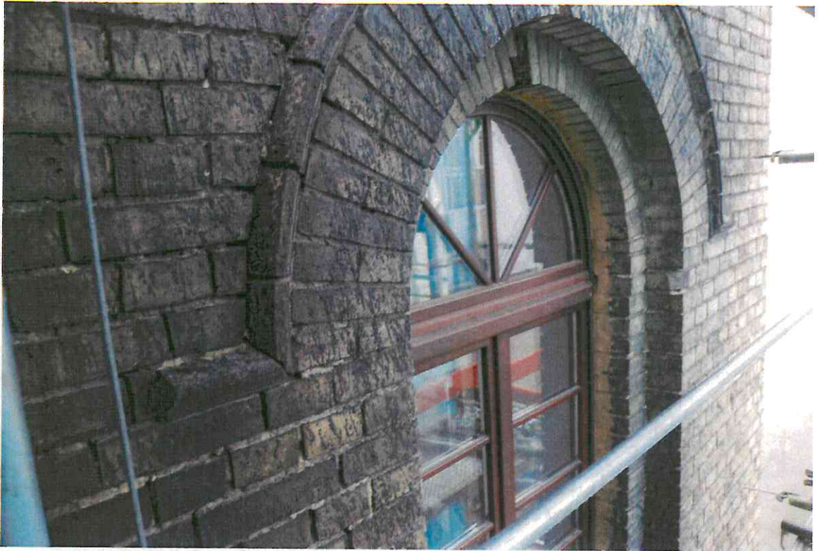
fot.32-33 Zabrudzenia elewacji substancją bitumiczną – smołą lub lepikiem.
