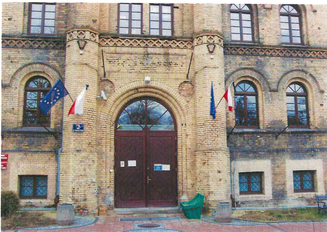
fot.5-6 Ryzalit centralny elewacji frontowej
