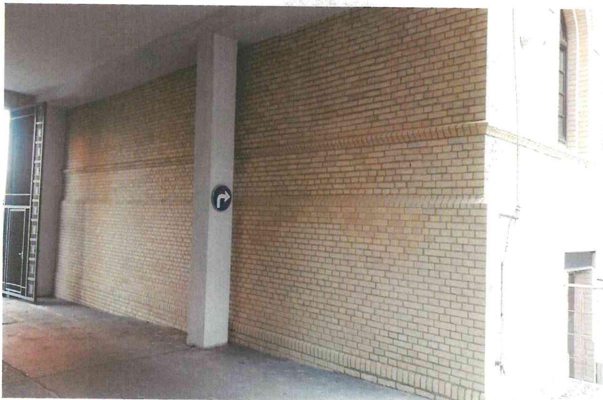
fot.10 Przejazd bramny prowadzący na wewnętrzny dziedziniec koszar z widoczną ścianą budynku po przeprowadzonych pracach konserwatorskich
