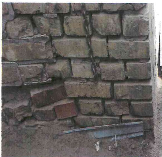
Fot.26. Ryzalit wschodni – zniszczenia w partii przyziemia i nieestetyczny, niefachowo uzupełniony narożnik cokołu.
