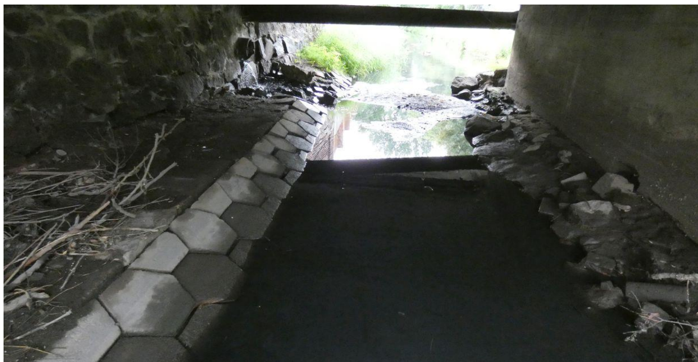
Fot. 6 Widok przestrzeni podmostowej
