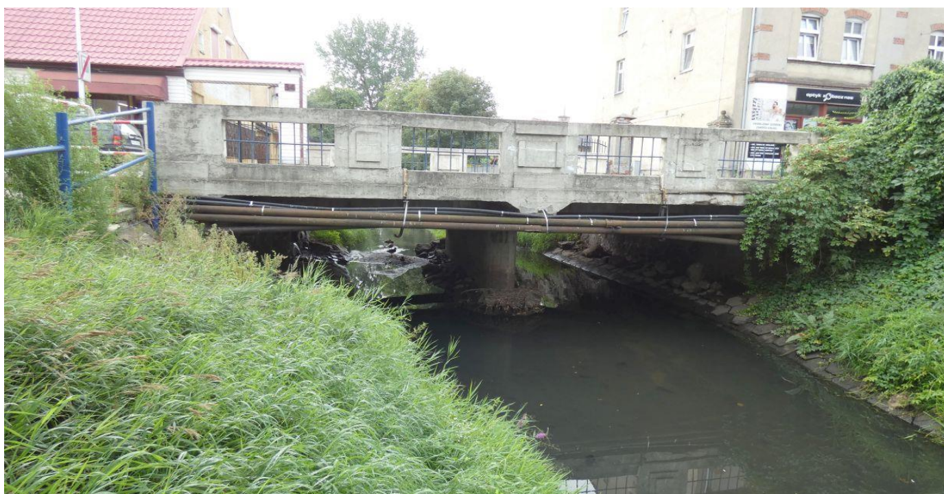
Fot. 3 Widok mostu z boku
