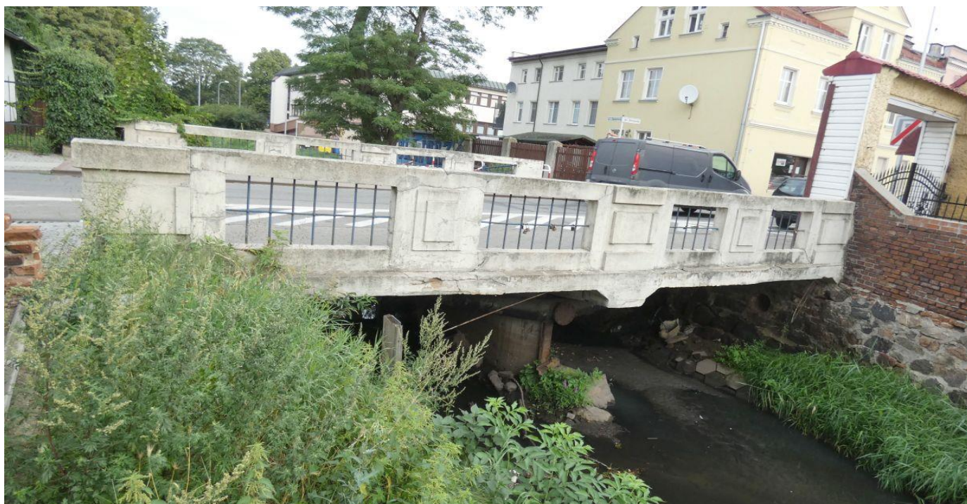
Fot. 4 Widok mostu z boku
