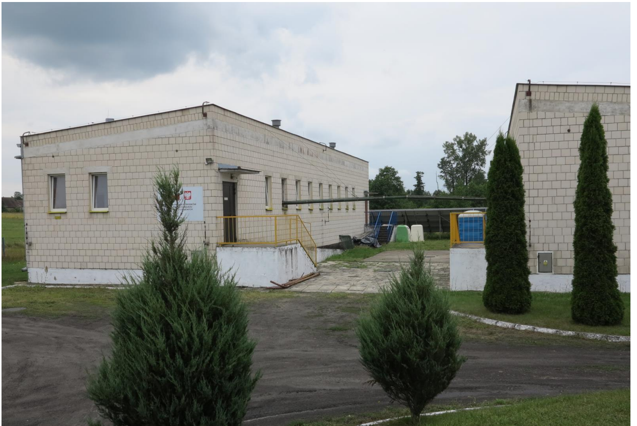
Zdj. 4. Budynki reaktorów BOS-200
