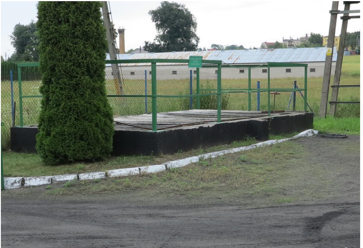
Zdj. 2. Zbiornik retencyjno-uśredniający ścieków
