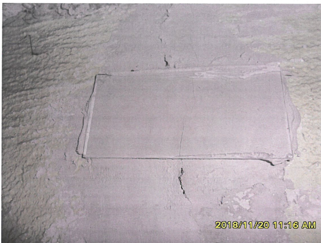
Fot. 7 Rysy ściany w miejscu szpachlowania po 14 dniach
