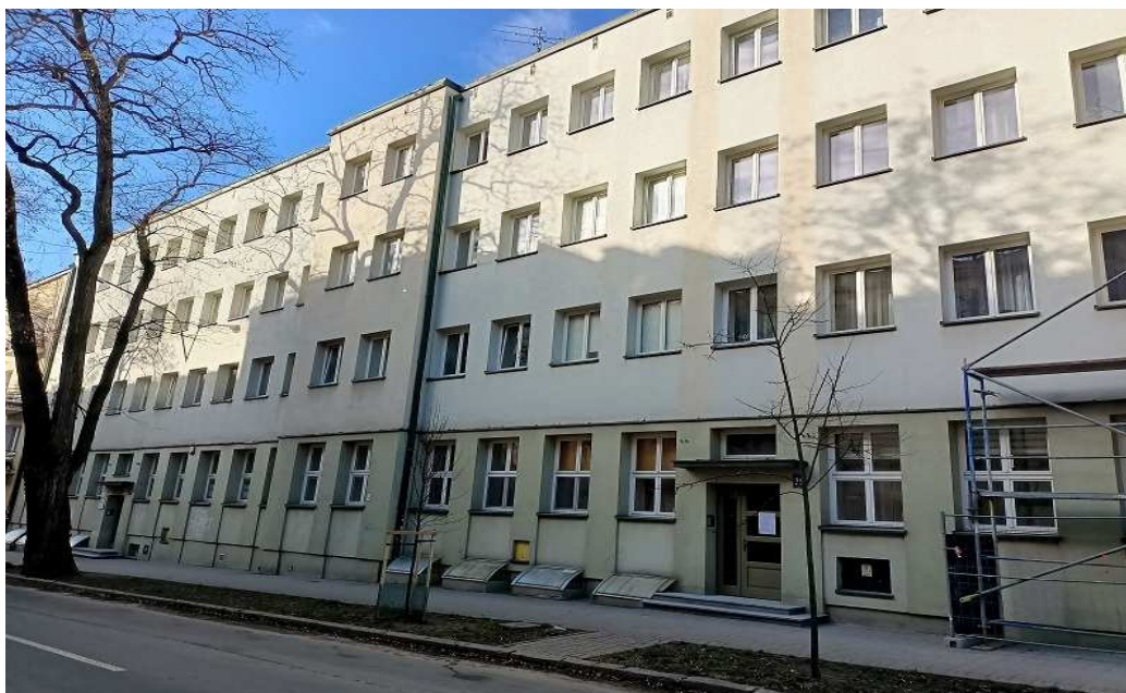
Widok nr 2. Elewacja frontowa Budynku Mieszkalnego KUL ul. F. Chopina 29 Lublin
