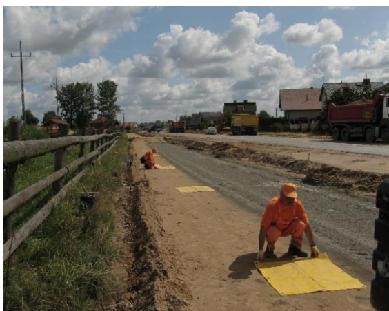
Rozmieszczenie tacek pomiarowych
