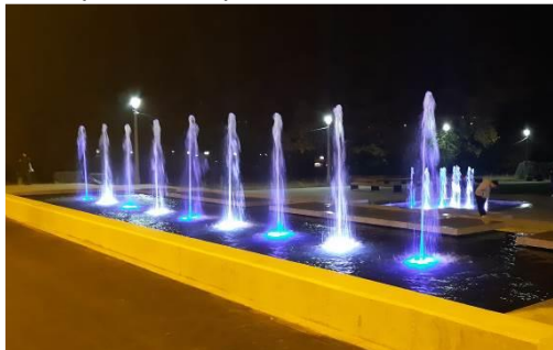
Obraz wodny o wysokości do 3m – pionowy, spiralny – koszykowy obraz wodny, składający się z 24 szt. pełnych strumieni o średnicy 6 mm każdego z nich:
