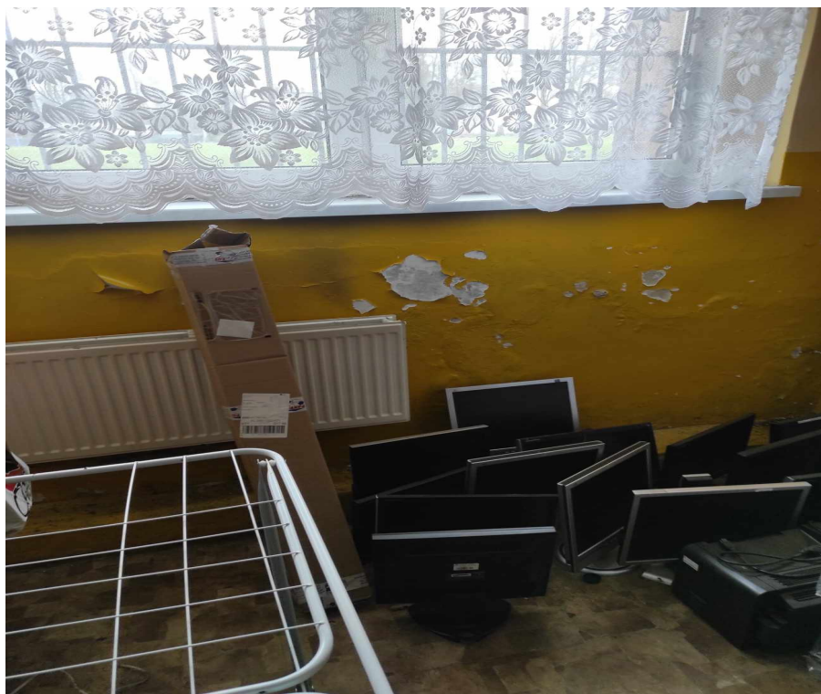
Zawilgocenia wewnątrz budynku
