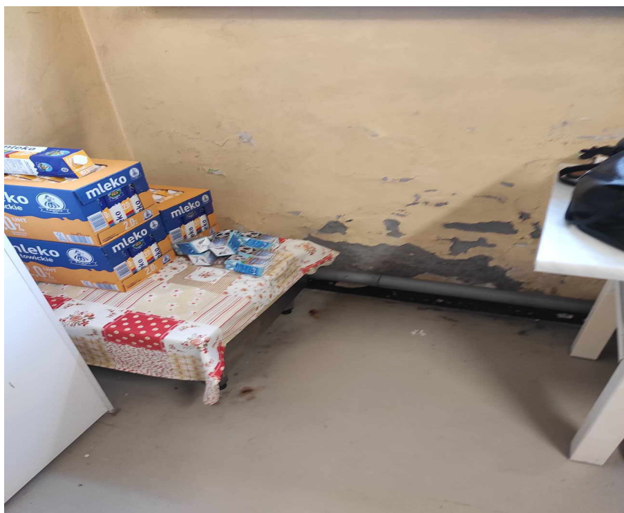
Zawilgocenia wewnątrz budynku
