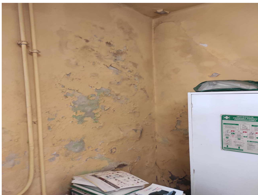
Zawilgocenia wewnątrz budynku
