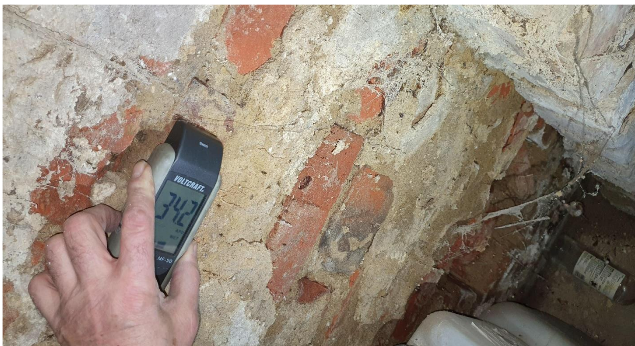
EKSPERTYZA OCENY STANU TECHNICZNEGO BUDYNKU MIESZKALNEGO PRZY UL. NEHRINGA 65 W SZCZECINIE
