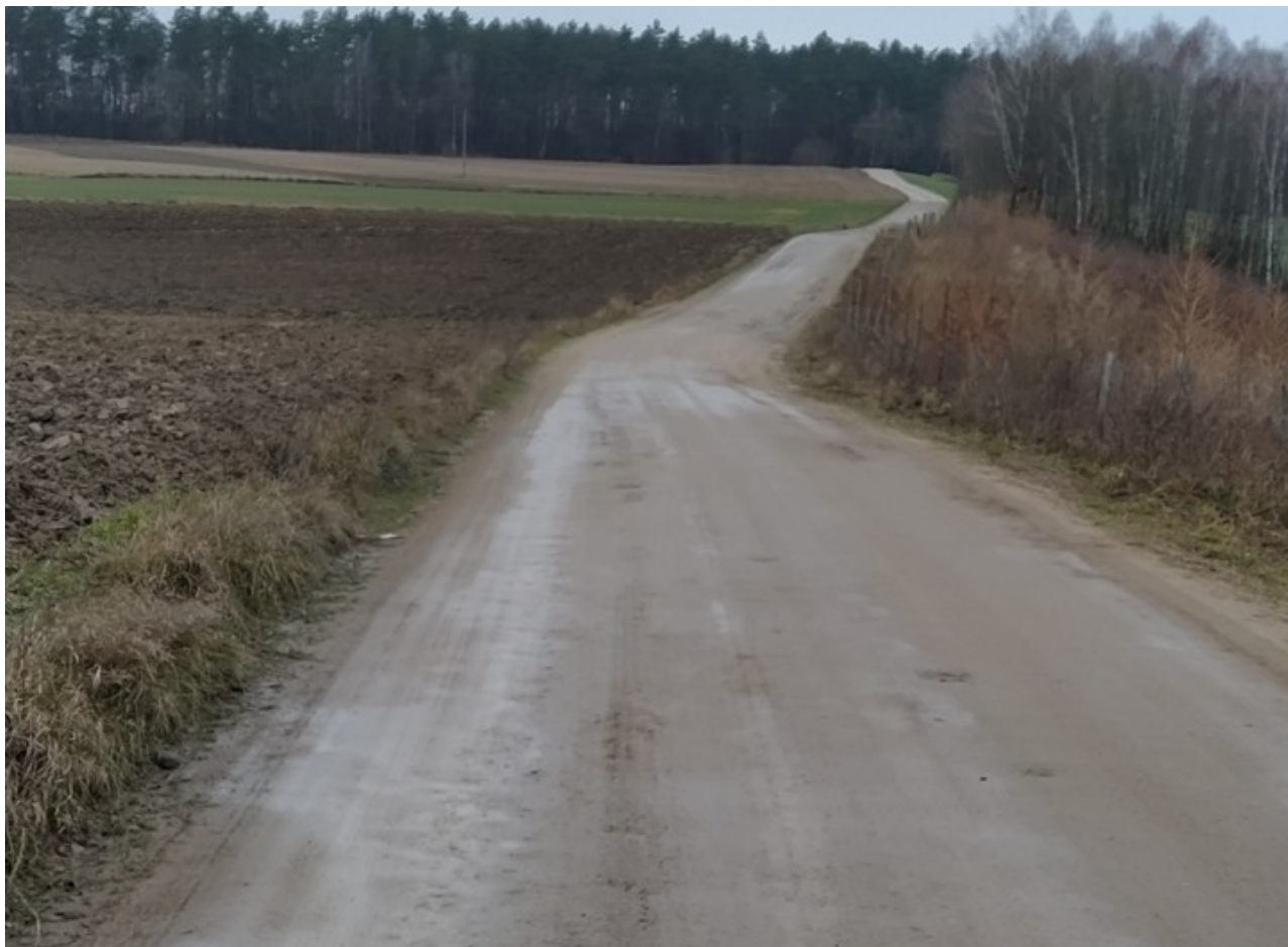
Fot. 3 Droga gminna - odcinek planowany do budowy
