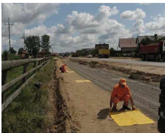
Rozmieszczenie tacek pomiarowych
