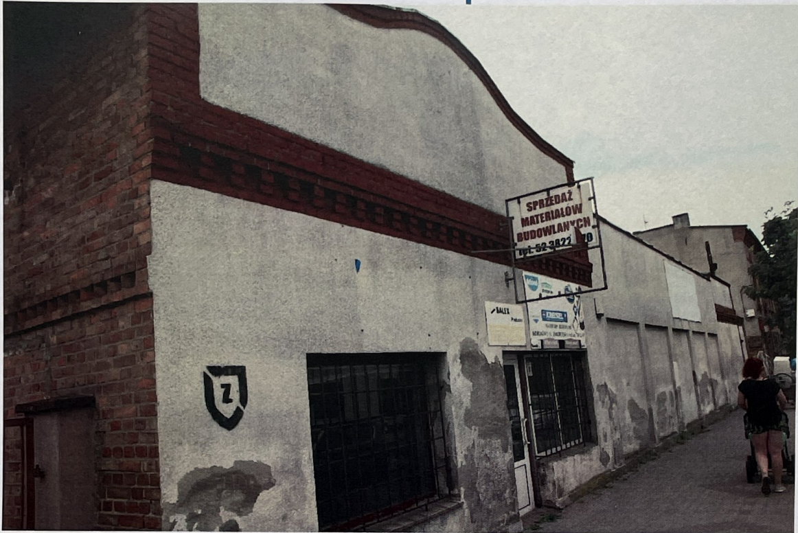
Fot. 7. Widok na elewację budynku przewidzianego do rozbiórki a znajdującego się na wschodniej granicy obszaru opracowania.
