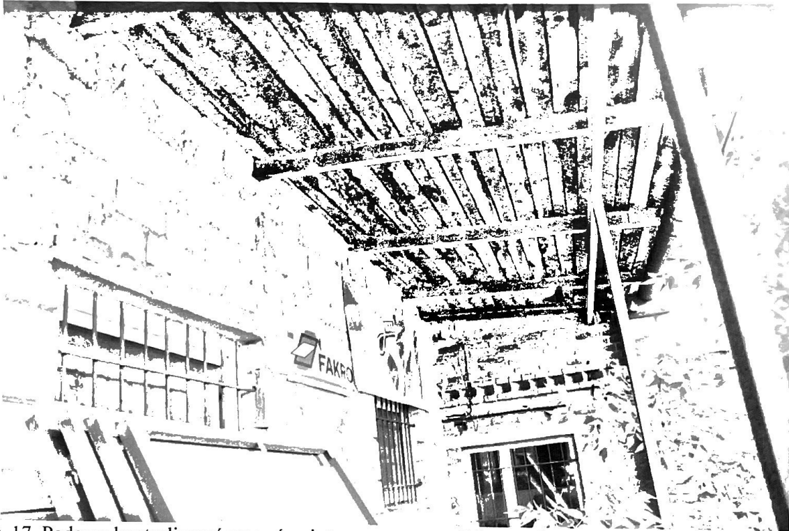
Fot. 17. Podczas kontroli zwrócono również uwagę na wszelkiego rodzaju otwory technologiczne stanowiące potencjalne przestrzenie gniazdowania ptaków. Kontrola nie wykazała obecności ptaków.
