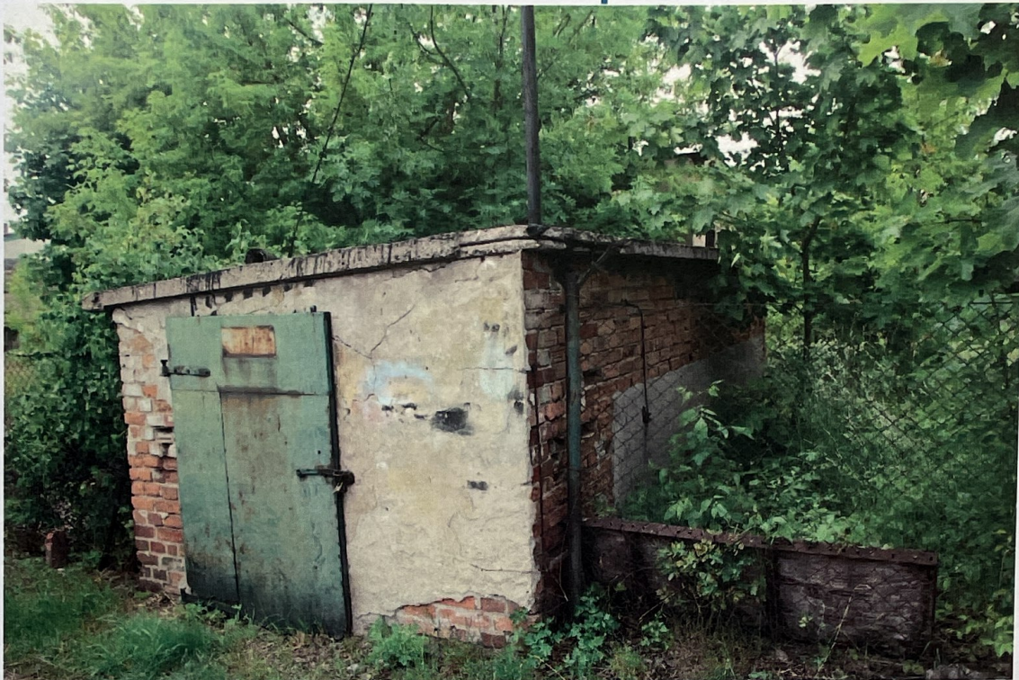
Fot. 9. Widok na elewację budynku przewidzianego do rozbiórki.
