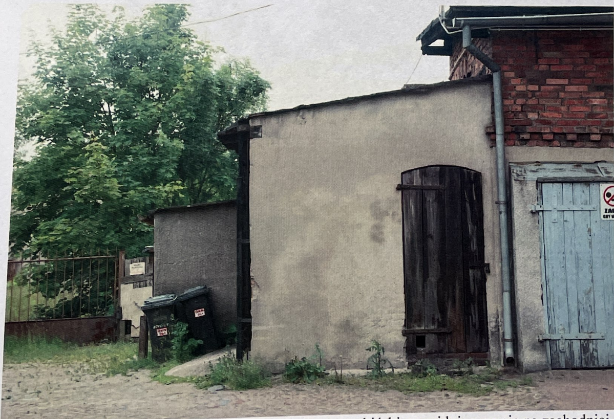
Fot. 8. Widok na elewację budynku przewidzianego do rozbiórki a znajdującego się na zachodniej granicy obszaru opracowania.
