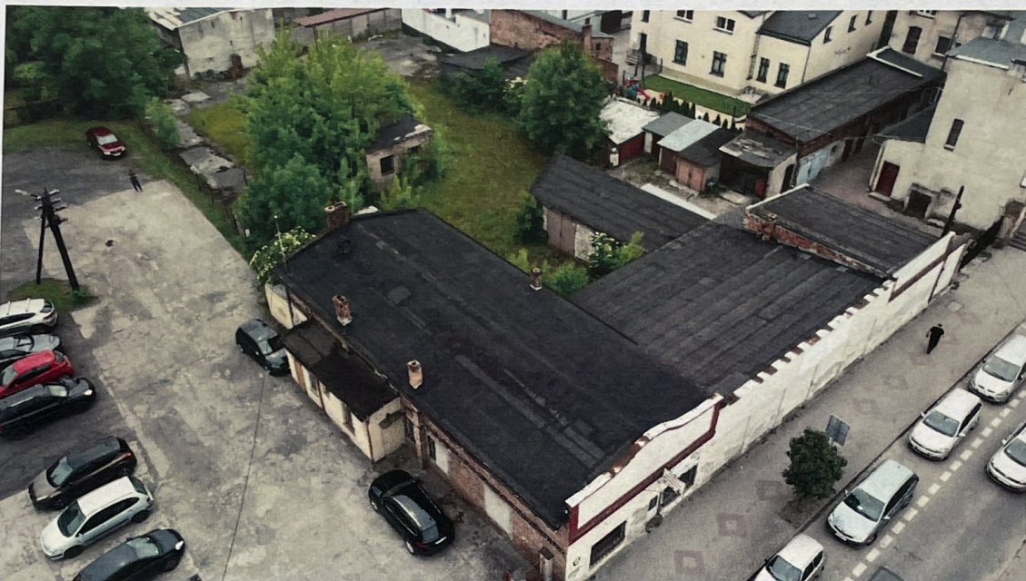
Fot. 1. Widok na budynki i obszar objęty opracowaniem. Zdjęcie wykonane z kierunku północno – wschodniego w kierunku południowo zachodnim.
