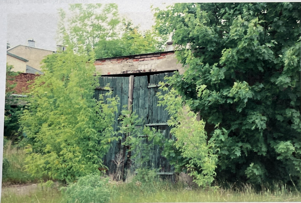
Fot. 10. Widok na elewację budynku przewidzianego do rozbiórki a znajdującego się w centralnej części działki.
