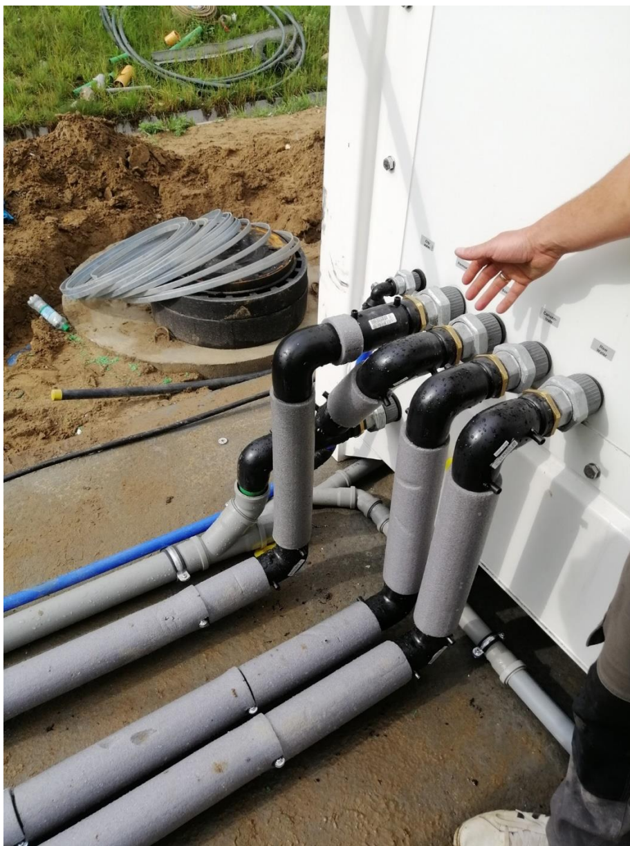
Zdj. Podłączenia instalacji wody, koncentratu, permeatu, ścieków surowych i inst. elektrycznych do kontenera One-Stage System.
