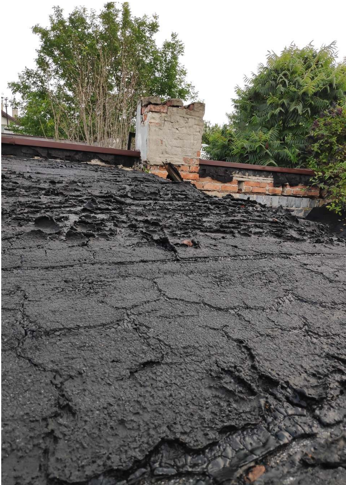
Budynek gospodarczy – stan pokrycia dachu i komina.
