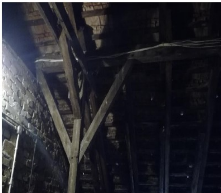
Fot. Nr 20. Układ Stolcowy pełny z dwukierunkowym usztywnieniem węzłowym przy ścianie szczytowej.
