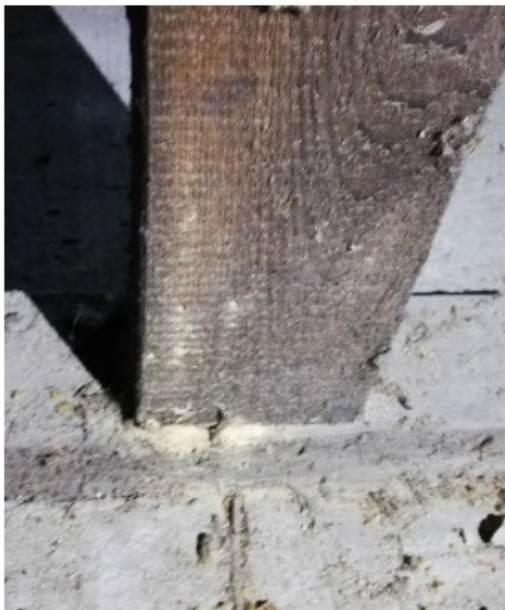
Fot.Nr 7. Zwierciny u podstawy słupa – widoczne ślady żywej formy owada.
