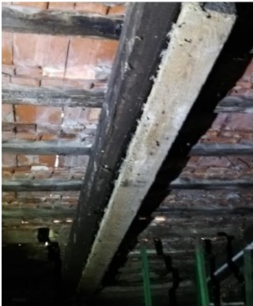
Fot. Nr 12. Wzmocnienie uszkodzonych krokwi
