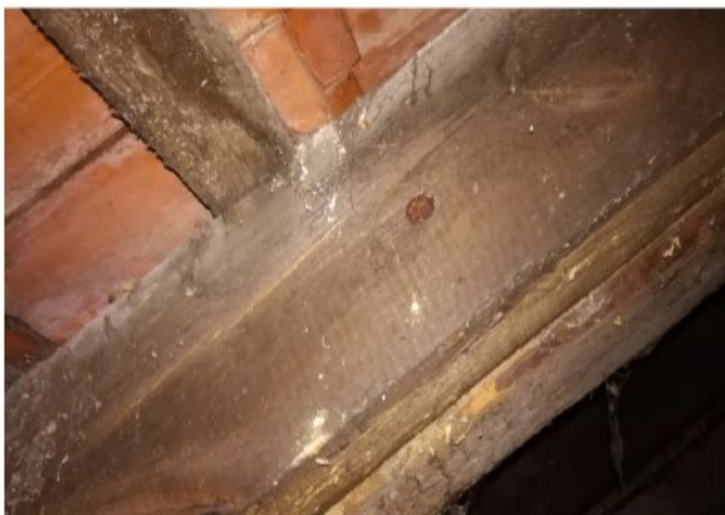
Fot. Nr 29. Wzmocnienie krokwi równoległą boczną nadbitką
