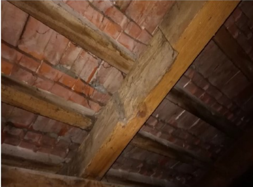
Fot. Nr 26. Ubytek w krokwi świadczy o jej pierwotnym innym położeniu (pochodzenie wtórne- spasowanie do innego węzła)
