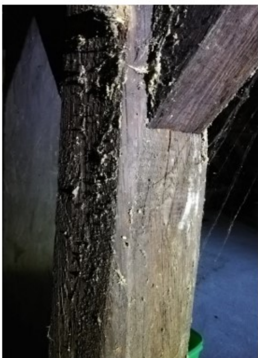
Fot. Nr 8. Zwierciny na połączeniu słupa i mieczy – widoczne ślady żywej formy owada
