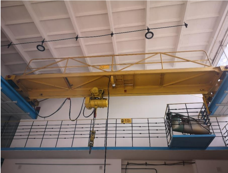
1. Zdjęcie przedstawiające doczasową suwnicę
