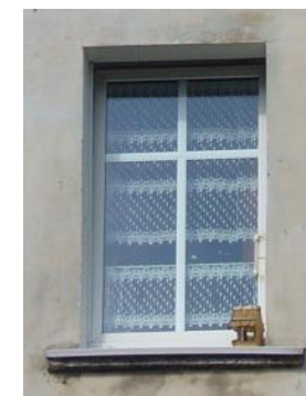
Zbliżenie – okno stare i PCV w elewacji zaplecza
