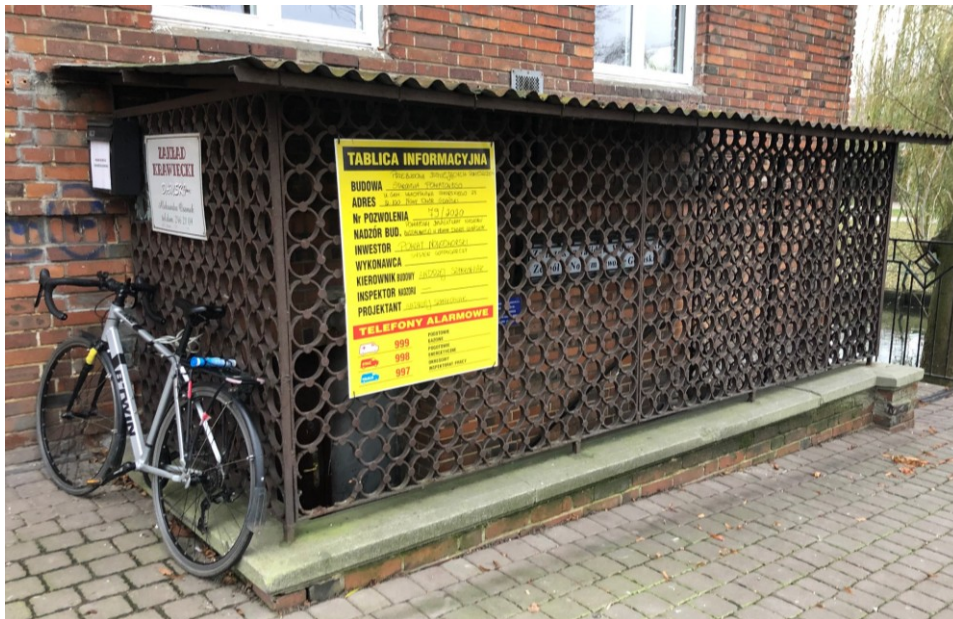
Zadaszenie z konstrukcją do demontażu
