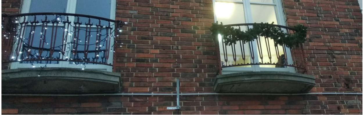
Widok na istniejące balkony – do remontu 11 szt.
