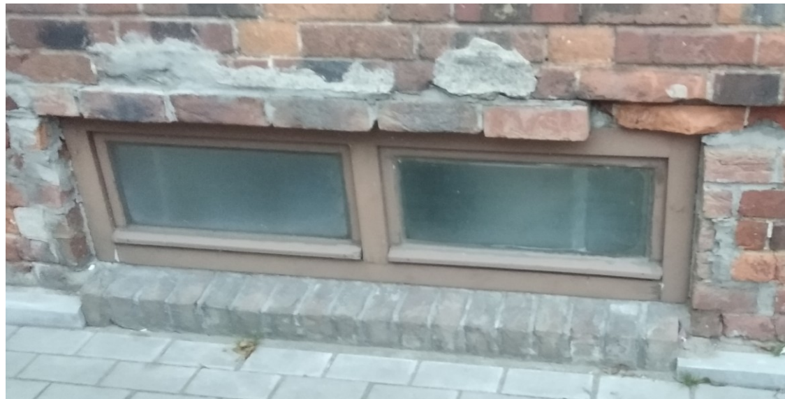
Widok na okno do piwnicy.
