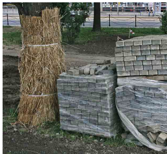
nieprawidłowy sposób składowania materiałów Budowlanych
