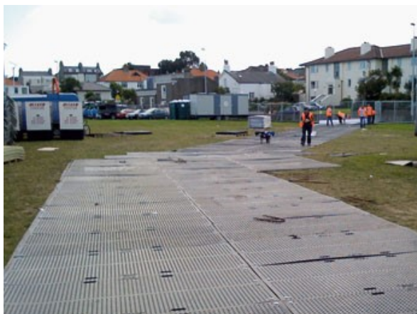
przykładowe tymczasowe drogi technologiczne na terenie budowy
