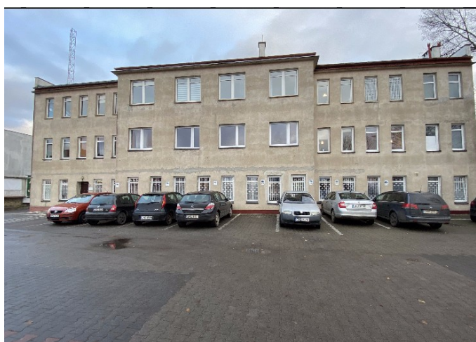
Widok elewacji od strony zachodniej
