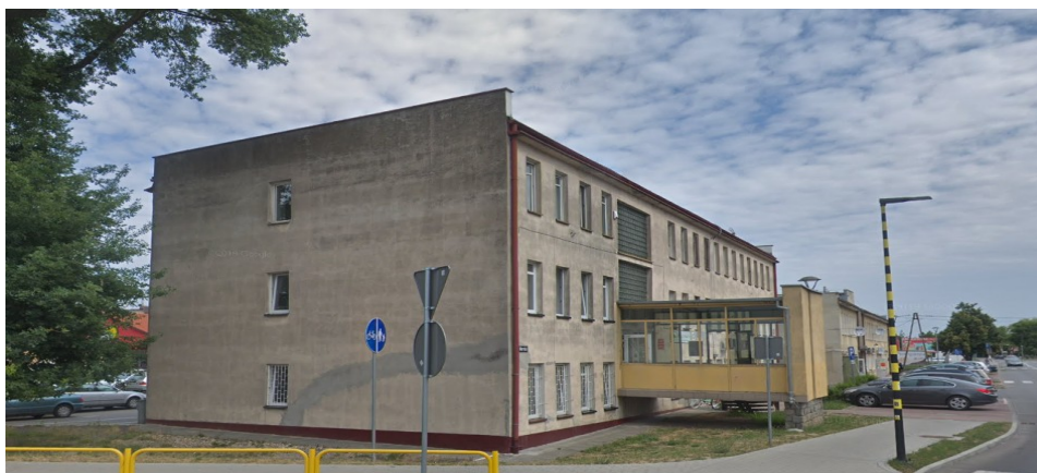
Widok elewacji od strony południowo wschodniej
