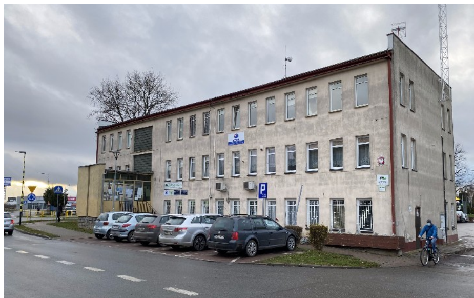
Widok elewacji od strony wschodniej
