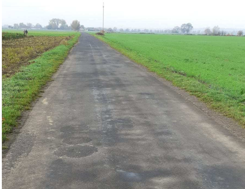
Fot. 1 Droga gminna w stanie istniejącym
