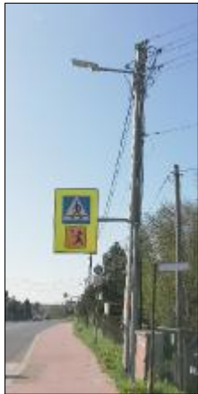
Istn. słup strunobetonowy E
