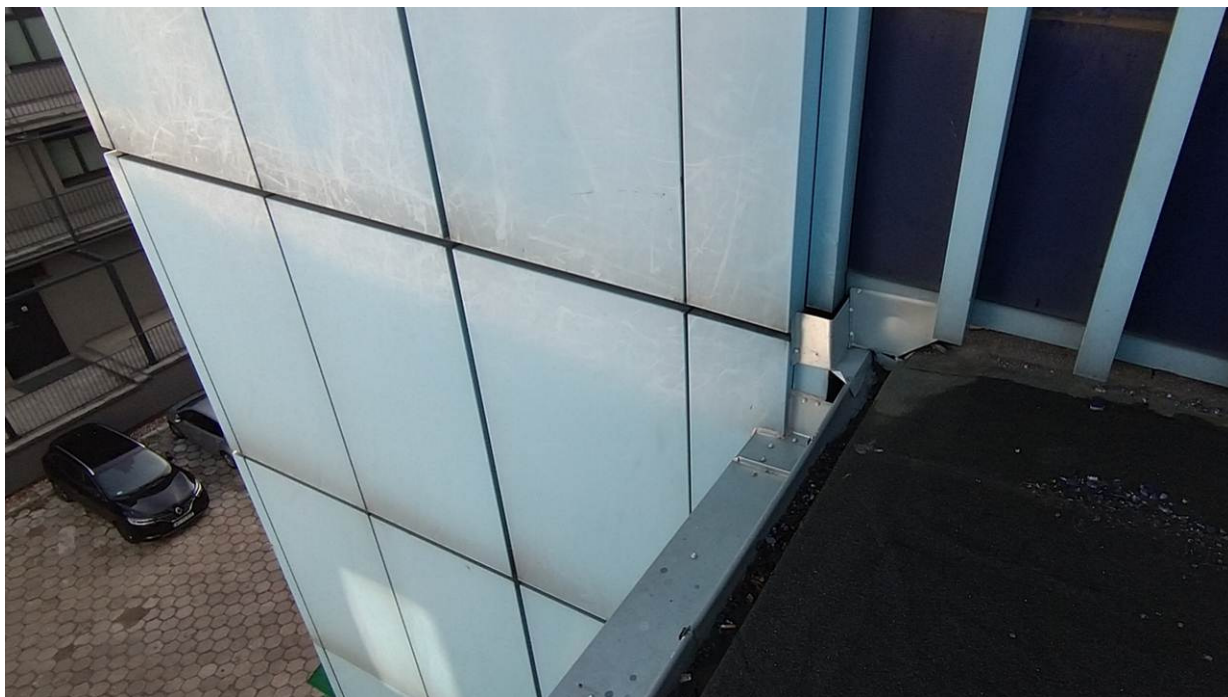
Krawędź dachu łącznika od strony wschodniej. Styk z elewacją wyższej części budynku „A”.
