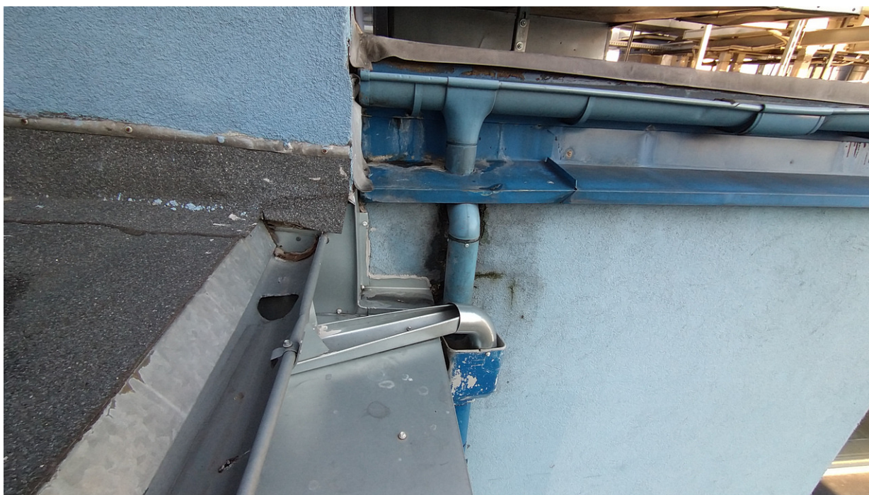
Rynny w narożniku na styku dachu łącznika i części głównej.
