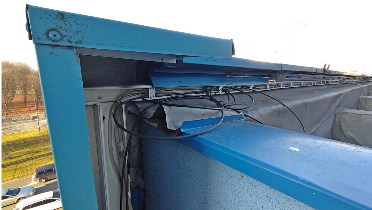
Zwieńczenie ścianki attykowej, okablowanie prowadzone pod elementami okładziny elewacji.
