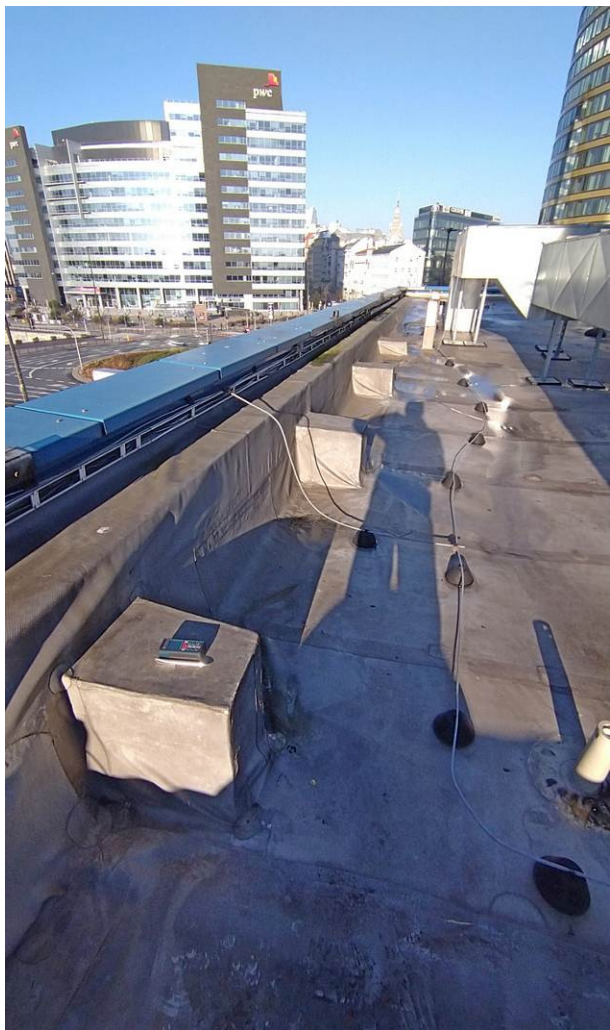
Elementy wystające z połaci wzdłuż attyki elewacji zachodniej, przelew w pld.-zach. narożniku.
