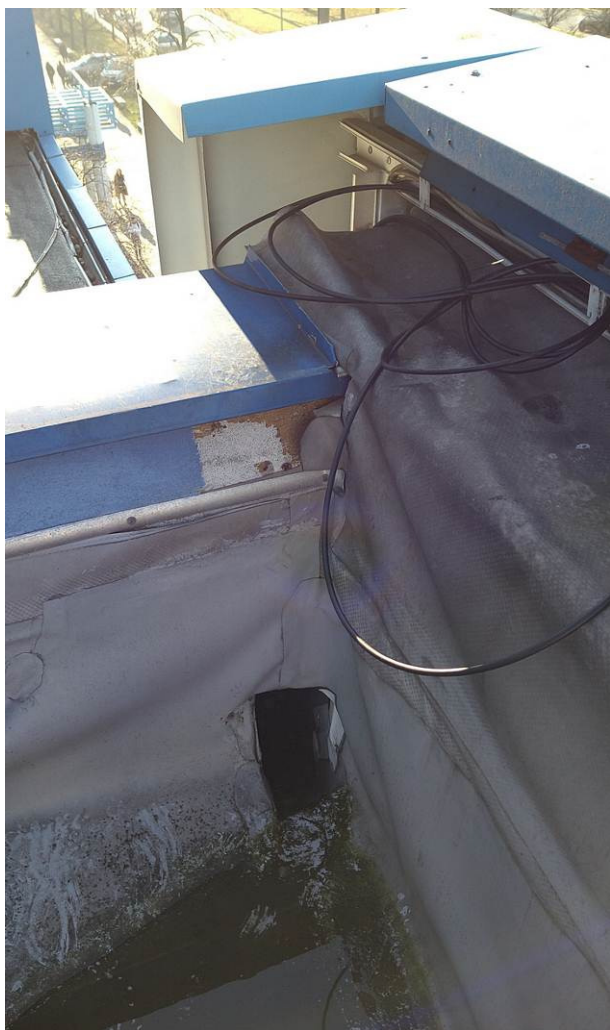
Elementy wystające z połaci wzdłuż attyki elewacji zachodniej, przelew w pld.-zach. narożniku.
