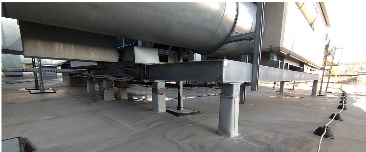
Stopki podkonstrukcji centrali.
