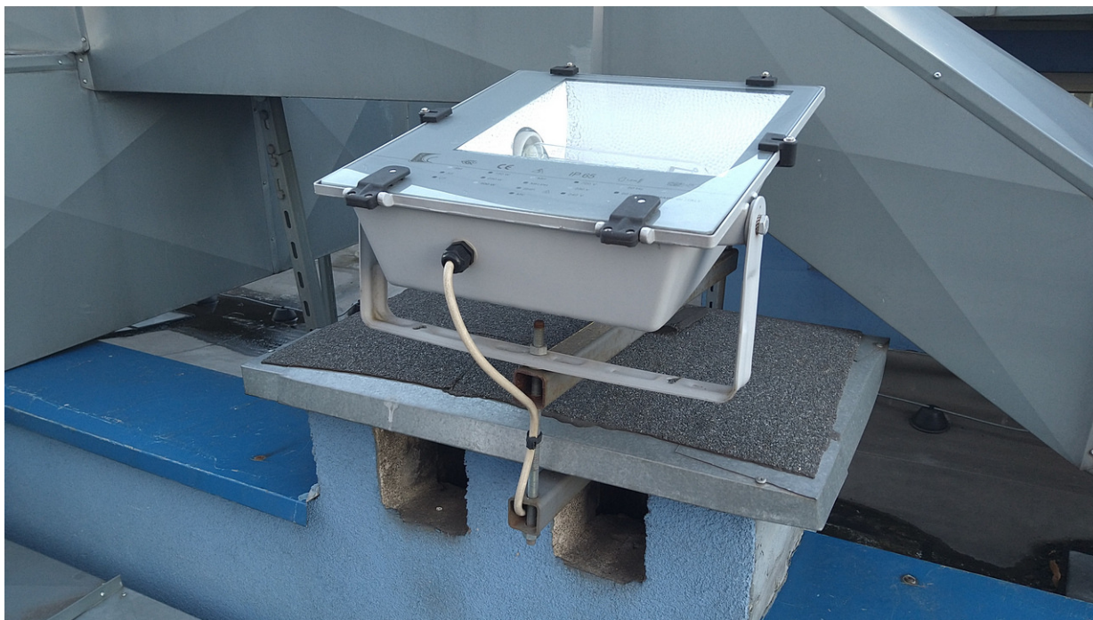
Oprawa oświetlenia elewacji na czapce komina.
