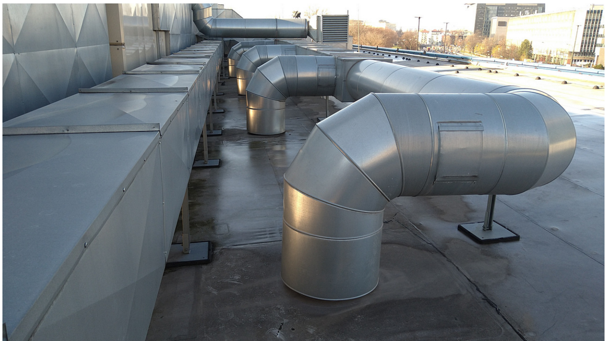
Przejścia przez dach inst. wentylacji w środkowej części dachu.
