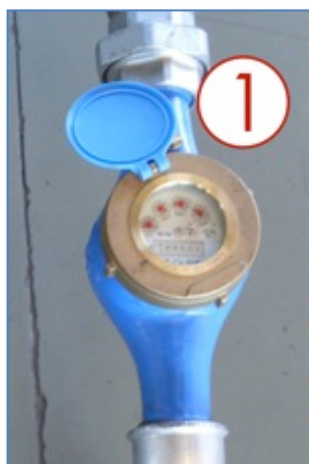
rys. 5-13: przepływomierz
