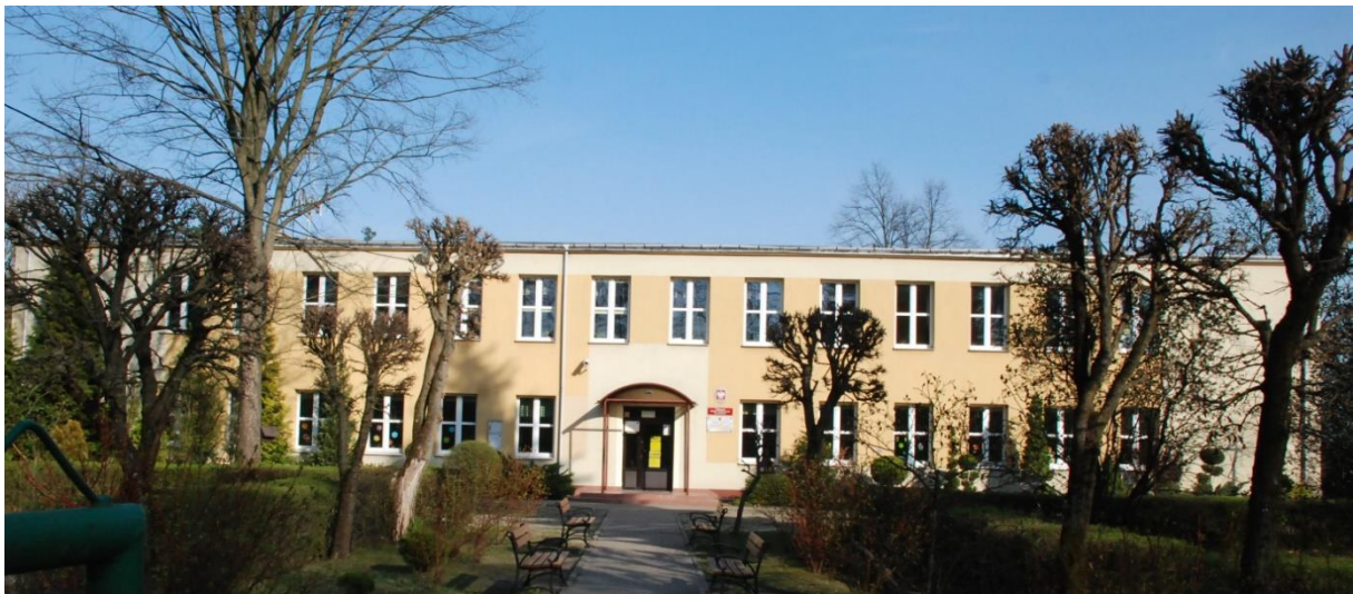
Widok na budynek publicznej szkoły podstawowej w Lutkówce od strony zachodniej.
