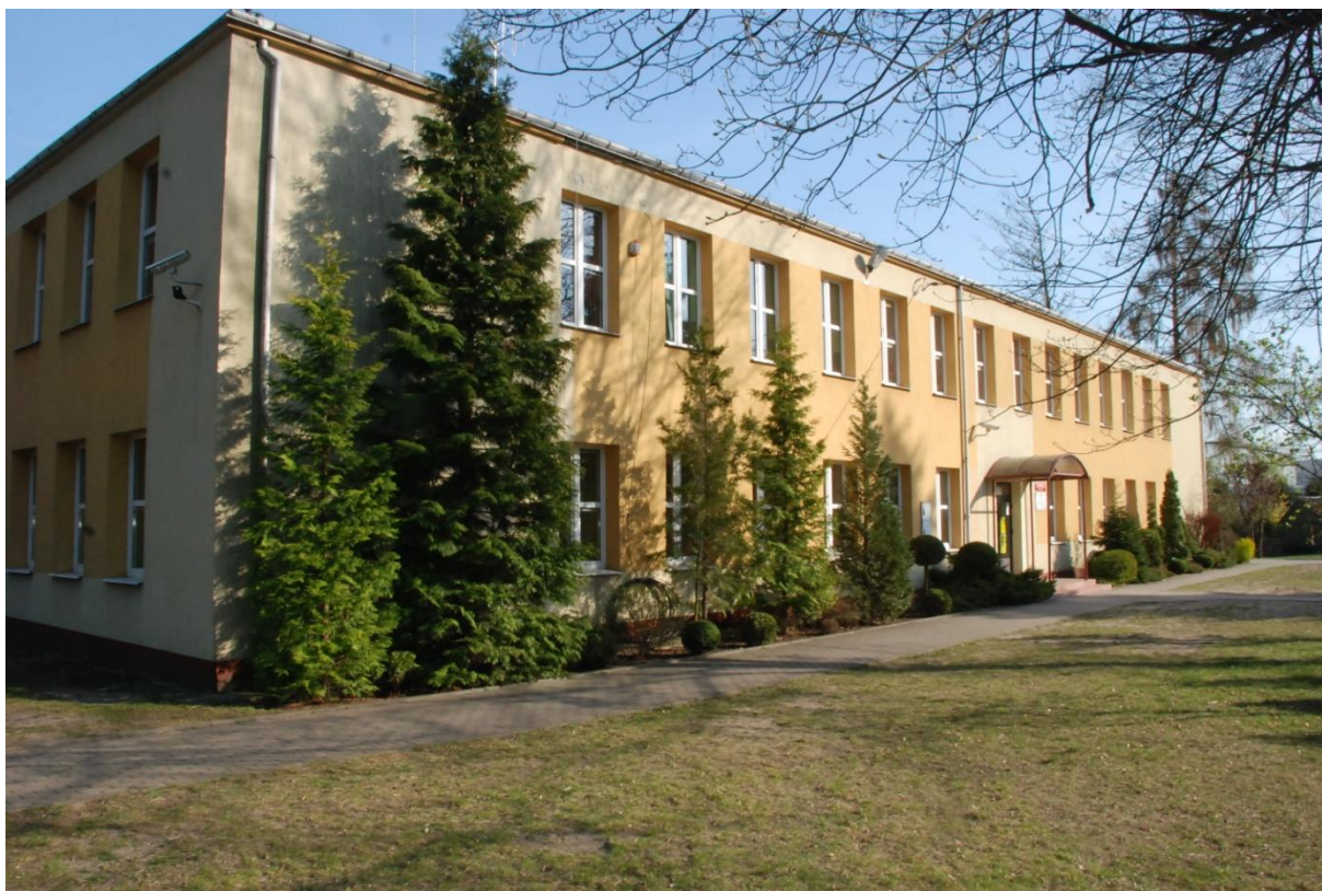
Budynek szkoły podstawowej, widok od strony północno zachodniej.
