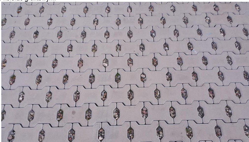
Rys. 5. Przykładowa nawierzchnia z kostki dwuteowej z wypustkami, typu „EKO”
