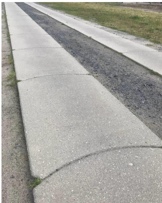
Rys. 4. Nawierzchnia z płyt drogowych na piór-wpust PDTP
