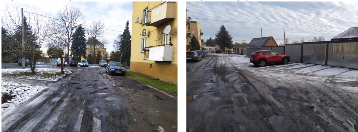
Zdj. nr 19-20. Zadanie nr 10. Utwardzenie placu na dz. ewid. nr 220/15 o. Trzcіńsko-Zdrój 4
