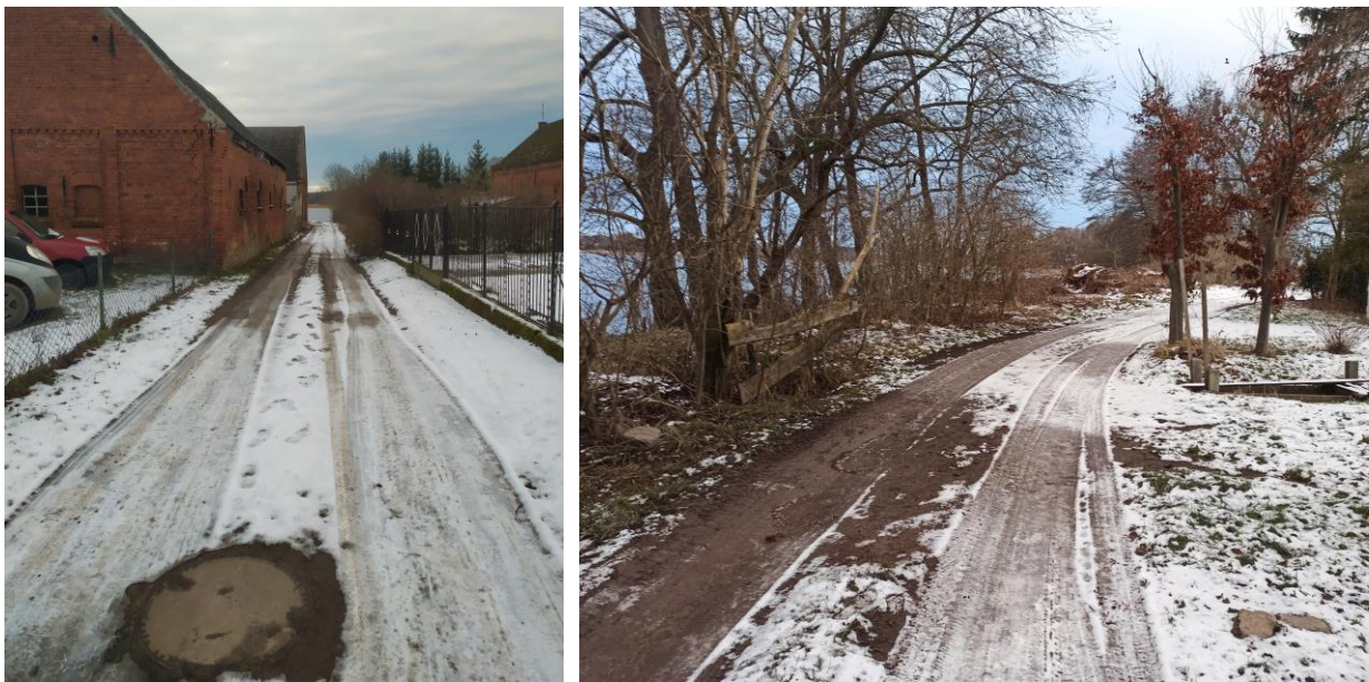
Zdj. nr 3-4. Zadanie nr 2 – droga dojazdowa na dz. ewid. nr 344.
