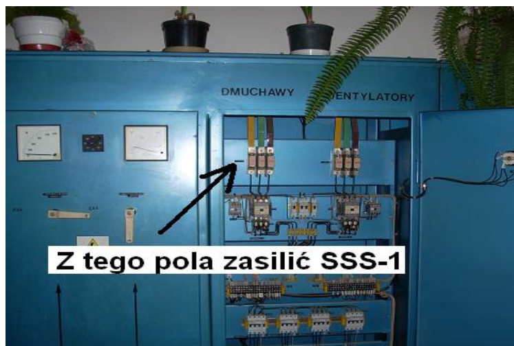
Rys. 1. Pole zasilania szafy SSS-1 z szafy dmuchaw i sprężarek
