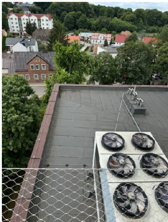
Dach górny pod łądowiskiem
