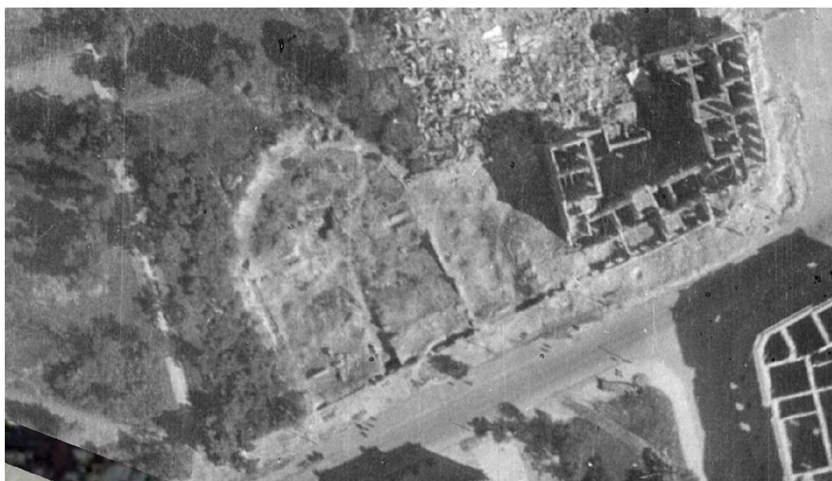
Fig. 6. Kamienice od strony Królewskiej na zdjęciu lotniczym 1945. Widoczny obrys wyburzonych murów
