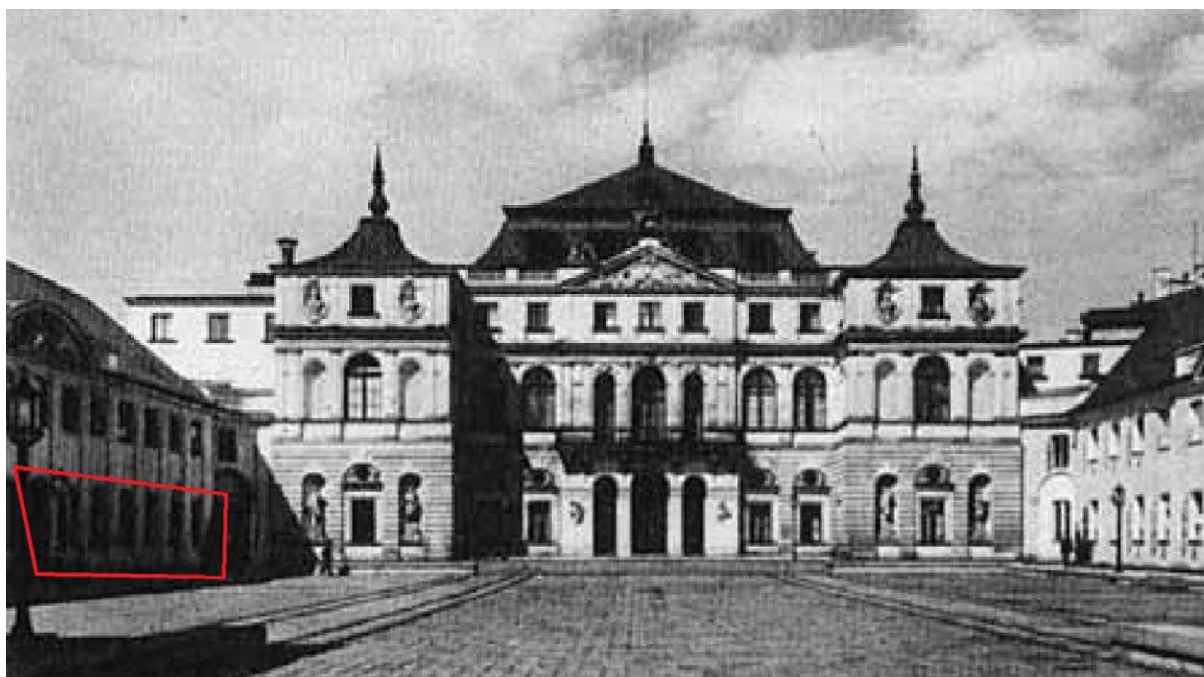
Fig.18. Zdjęcie fasady pałacu z widocznym fragmentem fasady oficyny. Fasada oficyny południowej różni się od fasady oficyny północnej. Na czerwono zaznaczono możliwy podcień, z widocznymi filarami, których podstawy mogą odpowiadać zarejestrowanym anomaliom.
