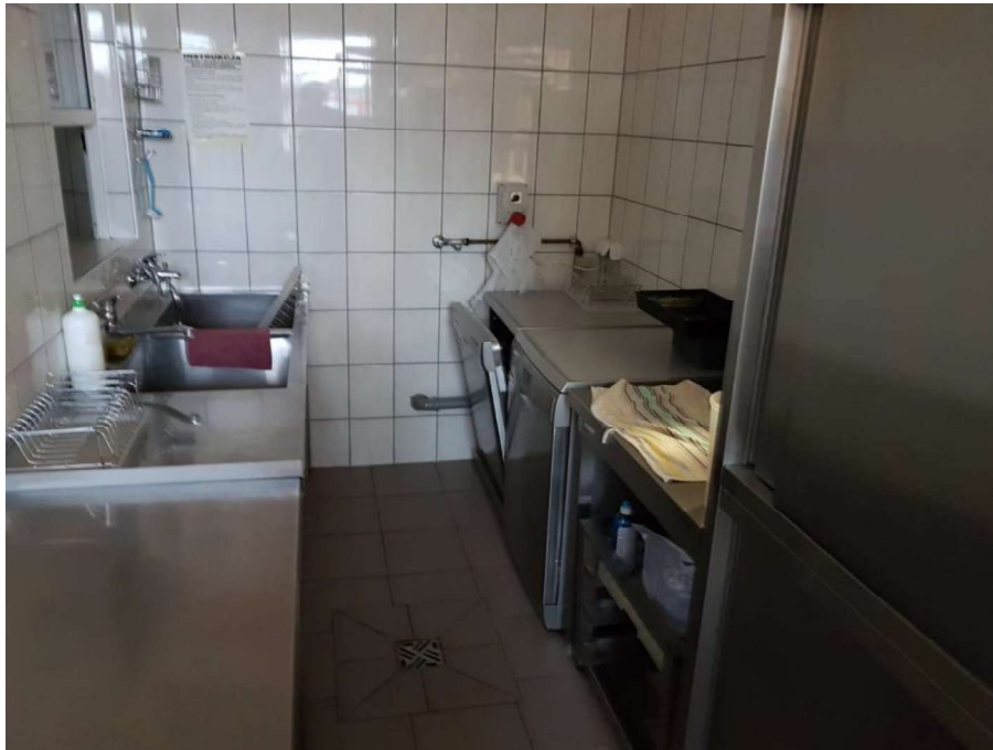
Fot. 13. Wpust podłogowy w kuchni
