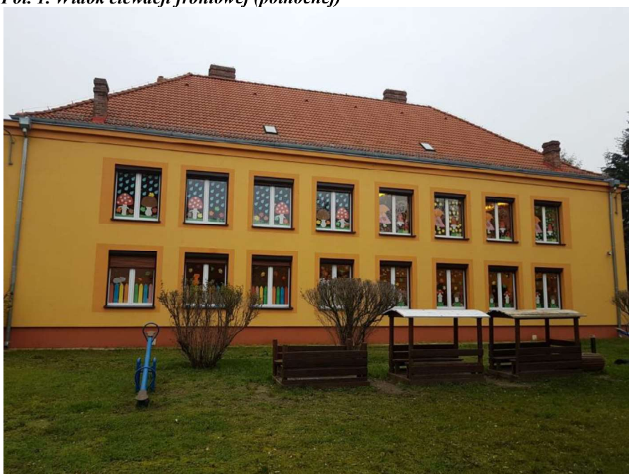
Fot. 2. Widok elewacji południowej
