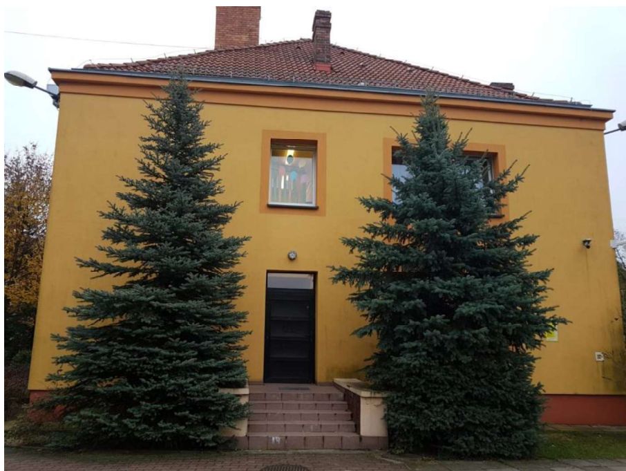
Fot. 3. Widok elewacji zachodniej
