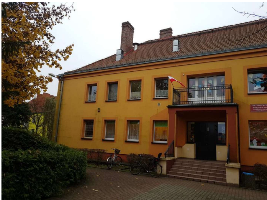
Fot. 1. Widok elewacji frontowej (północnej)
