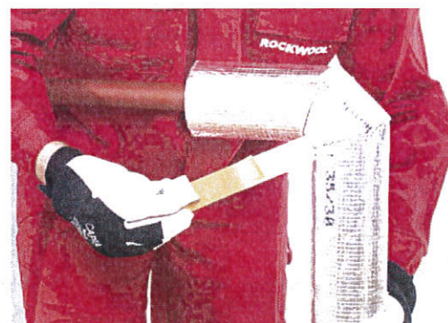
Sklejenie połączeń poprzecznych taśmą aluminiową.
