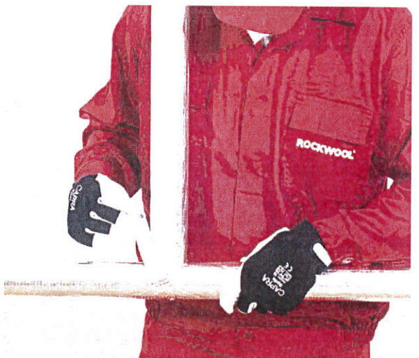
Sklejenie styków izolacji taśmą aluminiową.
