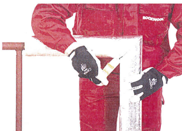
Zabezpieczenie połączenia poprzecznego otuliny samoprzylepną taśmą aluminiową.
