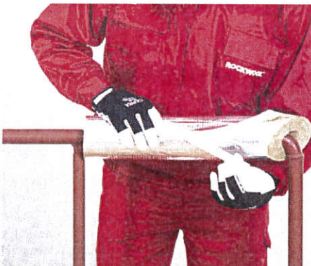
Sklejenie połączenia wzdłużnego zakładką samoprzylepną.
