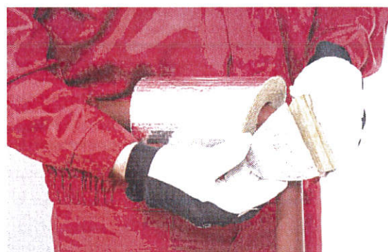
Montaż jednego segmentu kolanowego.
