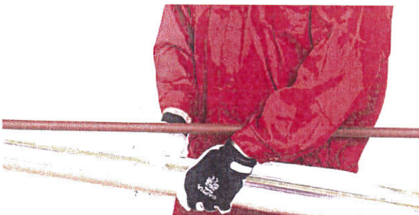
Nałożenie otuliny na odcinek prosty rurociągu.
