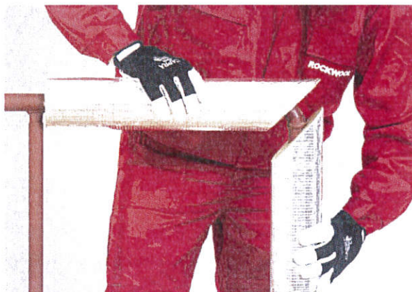
Dopasowanie obu elementów izolacji kolana.
