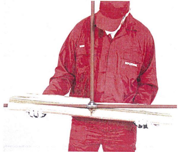
Nałożenie dociętych elementów na odcinek poziomy i pionowy rury.
