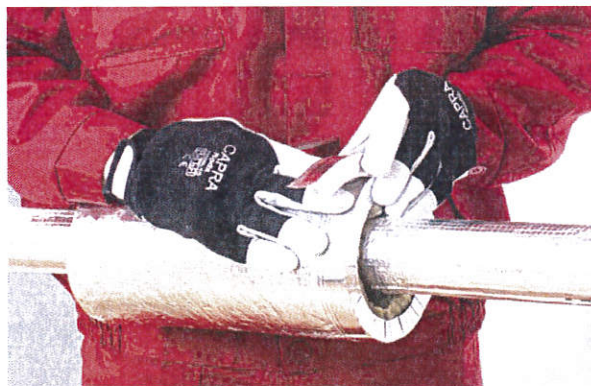
Zabezpieczenie zakończenia izolacji mankietem aluminiowym.
