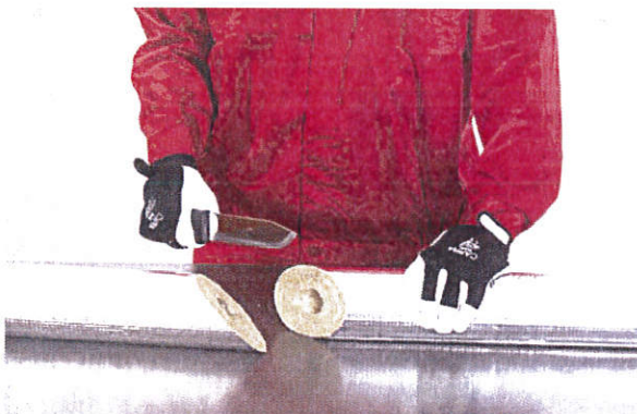
Rozcięcie otuliny pod kątem 45° na dwa elementy.
