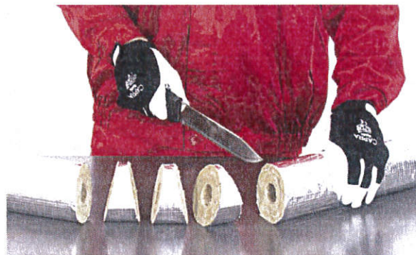
Wycinanie segmentów kolanowych.
