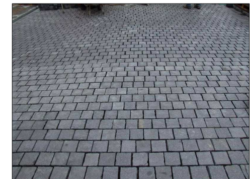
WYKONANIE NAWERZCHNI Z KOSTKI GRANITOWEJ CIĘTEJ, CZARNEJ, PŁOMIENIOWANEJ
