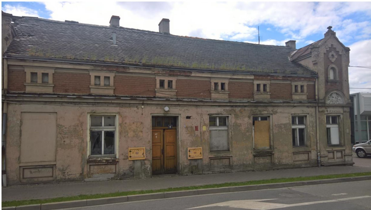
Zdjęcie 13 Opuszczony budynek przy jednej z głównych ulic Kępna
