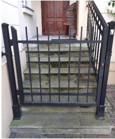
Fot. 16. Schody zewnętrzne od strony północnej budynku
