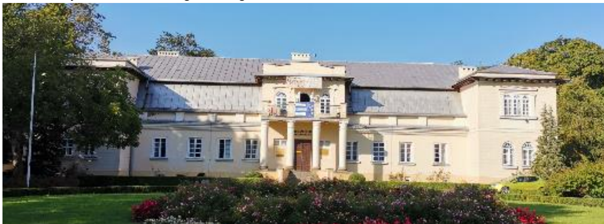
Fot. 1. Przedmiotowy budynek Muzeum Regionalnego w Bełchatowie (elewacja frontowa)
