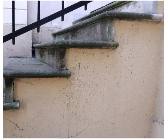
Fot. 17. Stopnie zewnętrznych schodów północnych – widok z boku
