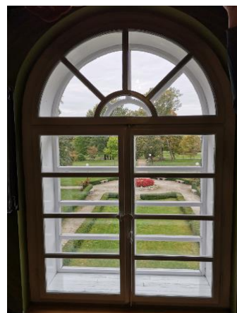
Fot. 25. Widok okna przeznaczonego do wymiany od wewnątrz
