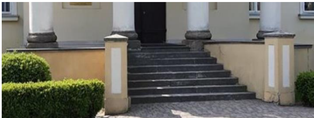
Fot. 11. Widok całości głównych schodów wejściowych (wschodnich)
