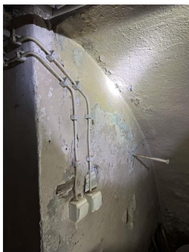
Widoczne zawilgocenia sklepień i ścian piwnic oraz odparzenia tynków.
