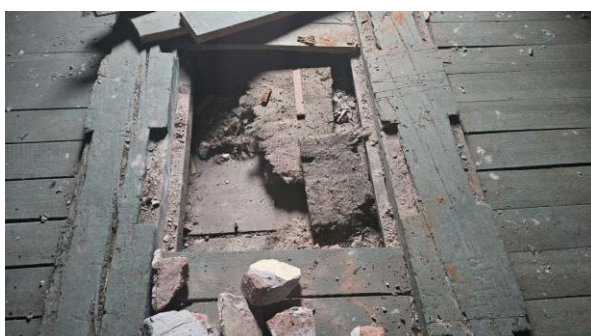
Odkrywka stropu z widokiem ślepego pułapu
