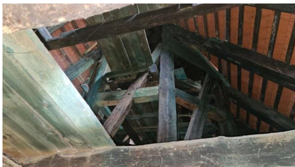
Widok konstrukcji wsporczej sygnaturki
