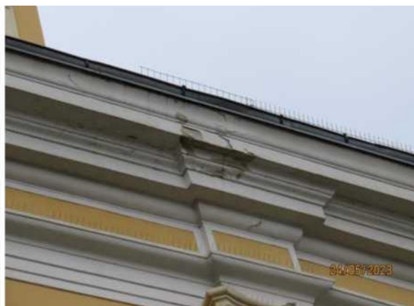
Widok uszkodzonych tynków elewacyjnych w strefach podgzymsowych
