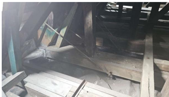
Widok klasycznego nakładkowego wzmocnienia belki ściągu oraz widok stalowych wieszaków
