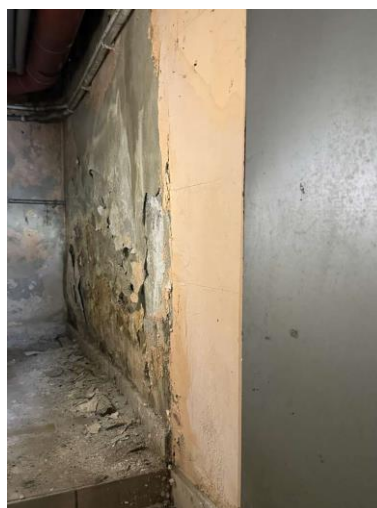
Widoczne zawilgocenia sklepień i ścian piwnic oraz odparzenia tynków.
