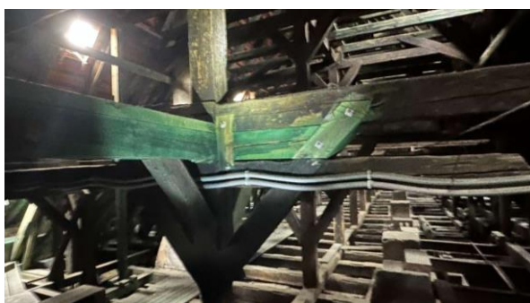
Przykład wzmocnienia miecza za pomocą nakładek skręcanych
