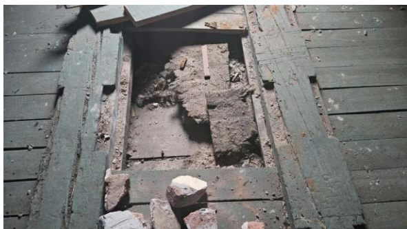
Odkrywka stropu z widokiem ślepego pułapu
