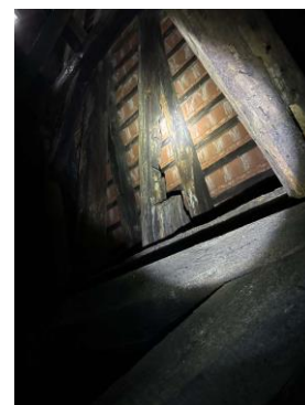
zdj.3. Wzmocnienie krokwi wg schematu 1
