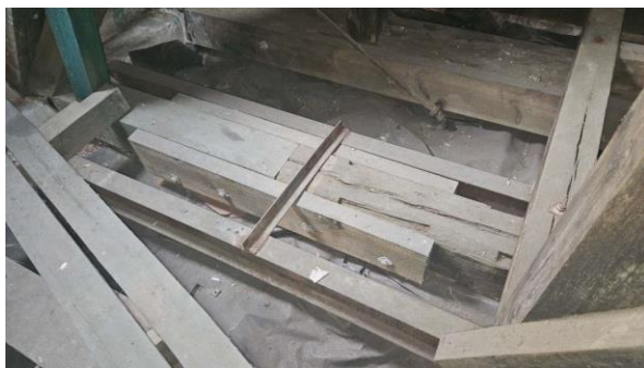
Widok klasycznego nakładkowego wzmocnienia belki ściągu oraz widok stalowych wieszaków
