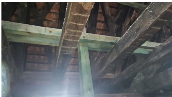
Dodatkowe płatwie i słupy wzmacniające
