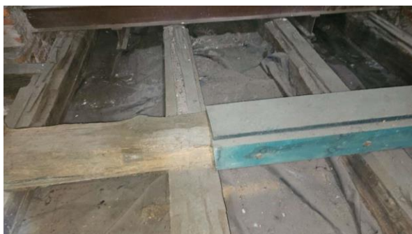
Powierzchniowe porażenie biotyczne owadami – technicznymi szkodnikami drewna
