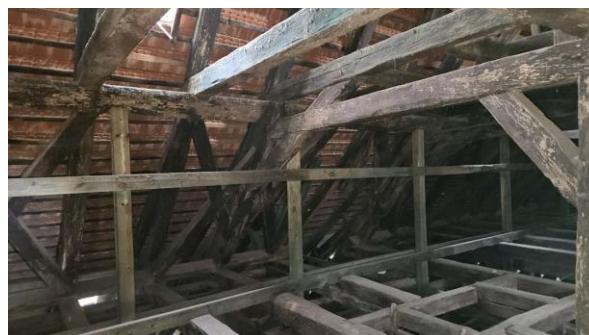
Rząd słupów wtórnych wzmocniających płatew
