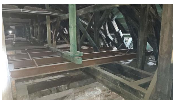
Widok belek stalowych podpierających dodatkowe słupy wzmocniające więźbę
