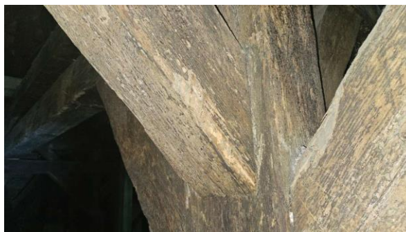
Powierzchniowe porażenie biotyczne owadami – technicznymi szkodnikami drewna
