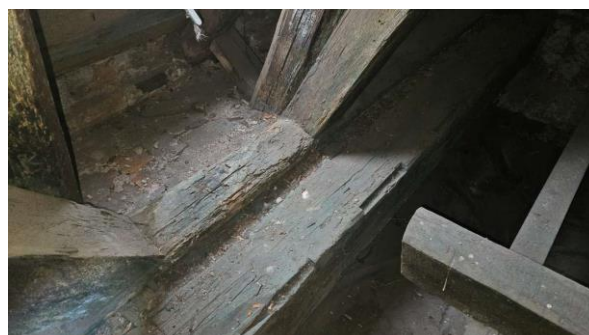
Porażenie biotyczne grzybem domowym
