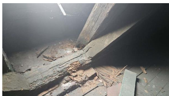
Porażenie biotyczne grzybem domowym
