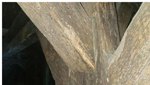
Powierzchniowe porażenie biotyczne owadami – technicznymi szkodnikami drewna
