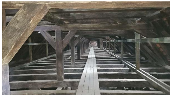
Widok ogólny więzby dachowej dolnej części o górnej z pomostami komunikacyjnymi
