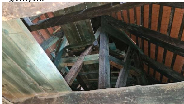
Widok konstrukcji wsporczej sygnaturki
