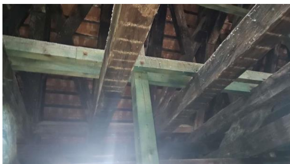
Dodatkowe płatwie i słupy wzmocniające
