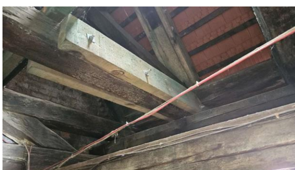
Widok nakładek wzmocniających kleszcze
