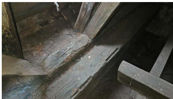
Porażenie biotyczne grzybem domowym
