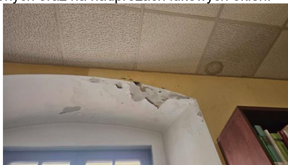
Widok zacieków z nieszczelnego dachu w obrębie biblioteki
