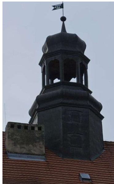
Widok sygnaturki na połaci dachu
