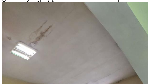
Widok zacieków z nieszczelnego dachu w obrębie biblioteki
