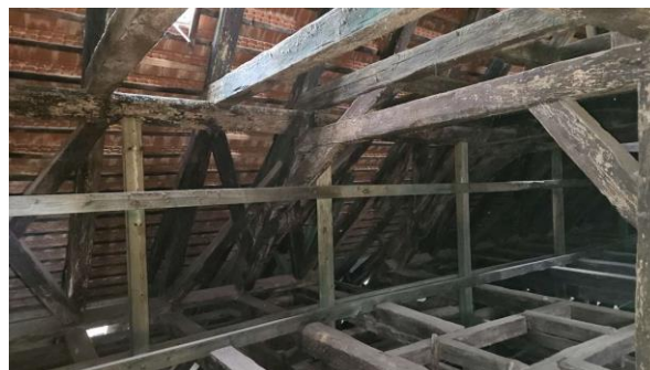
Rząd słupów wtórnych wzmacniających płatw
