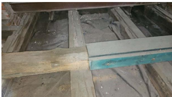
Powierzchniowe porażenie biotyczne owadami – technicznymi szkodnikami drewna
