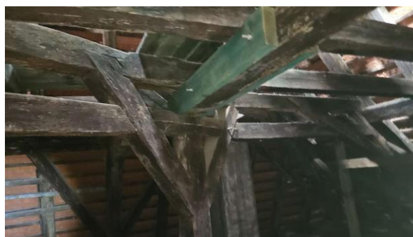
Przykład prawidłowego skręcanych wzmocnienia nakładkowego kleszczy
