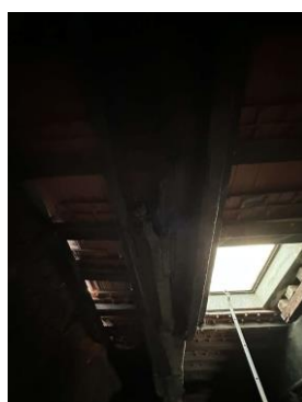
zdj.5. Konieczność uszczelnienia dachu
