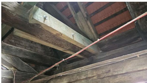
Widok nakładek wzmacniających kleszcze
