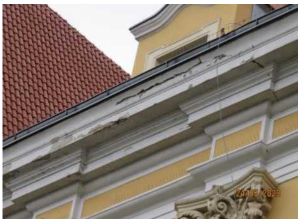
Widok uszkodzonych tynków elewacyjnych w strefach podgzymsowych
