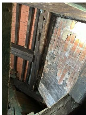
zdj.2. Wzmocnienie płatwi wg schematu 1
