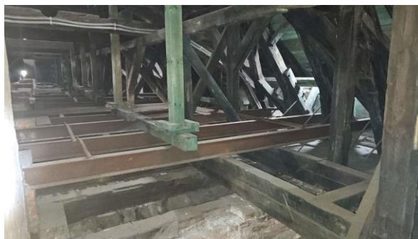
Widok belek stalowych podpierających dodatkowe słupy wzmacniające więźbę
