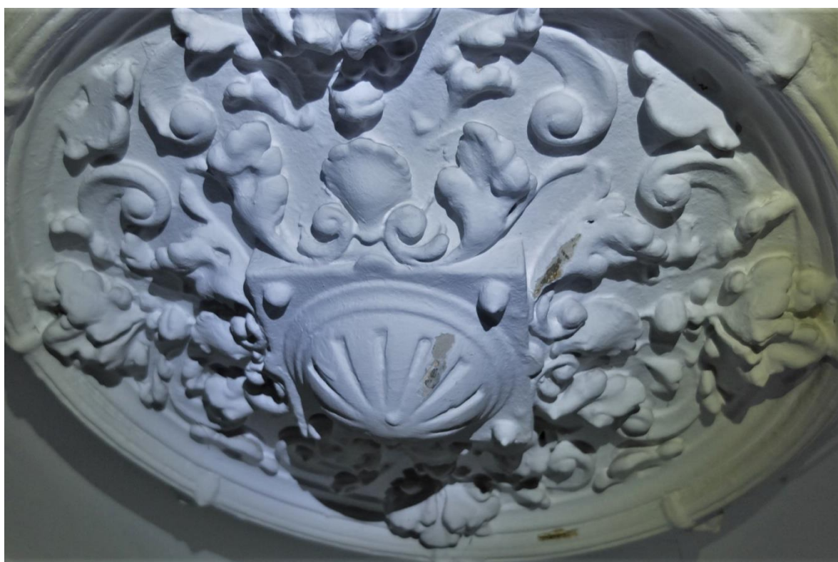
FOT. 30 - detal fot. 26, rozeta w przęśle południowym stropu.
