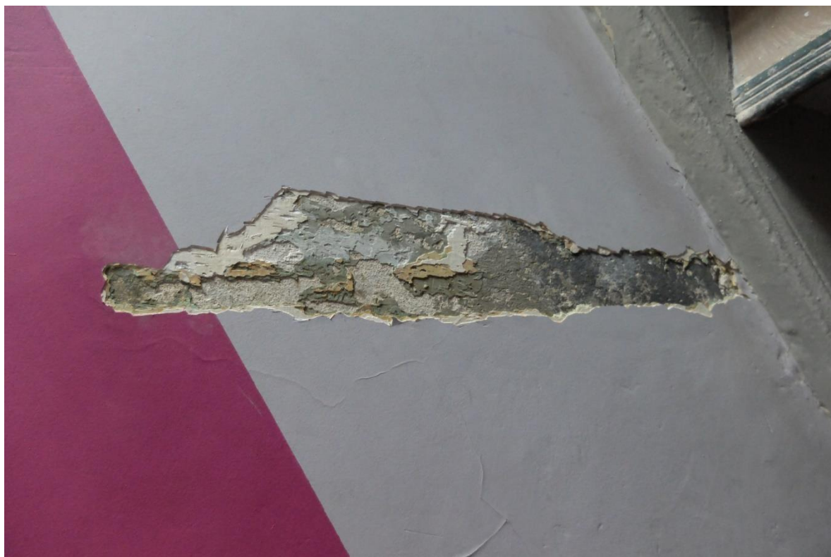
FOT. 56 - Klatka schodowa pomocnicza - II bieg w kierunku kondygnacji piętra, ściana północna. Odkrywka, widok ogólny. ←
