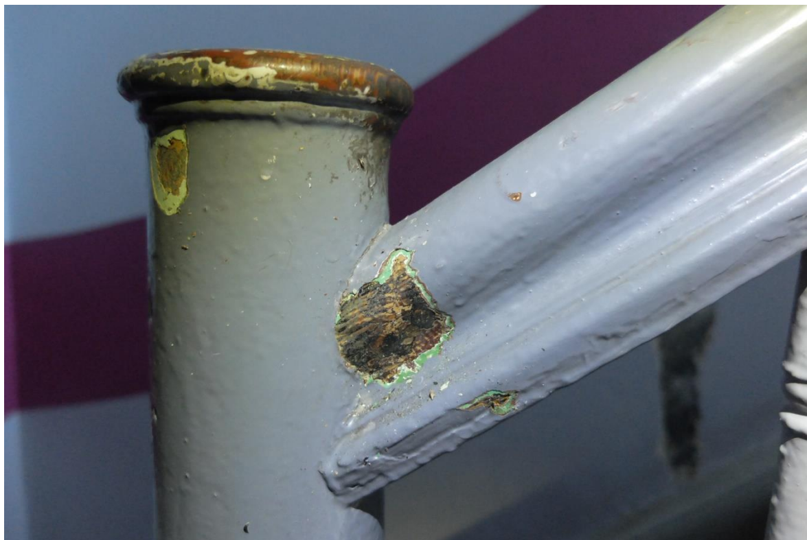
FOT. 67 - Klatka schodowa pomocnicza - słupek i pochwyt, fragment.
