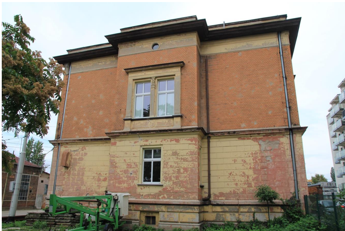
FOT. 13 - Elewacja zachodnia, widok ogólny.
