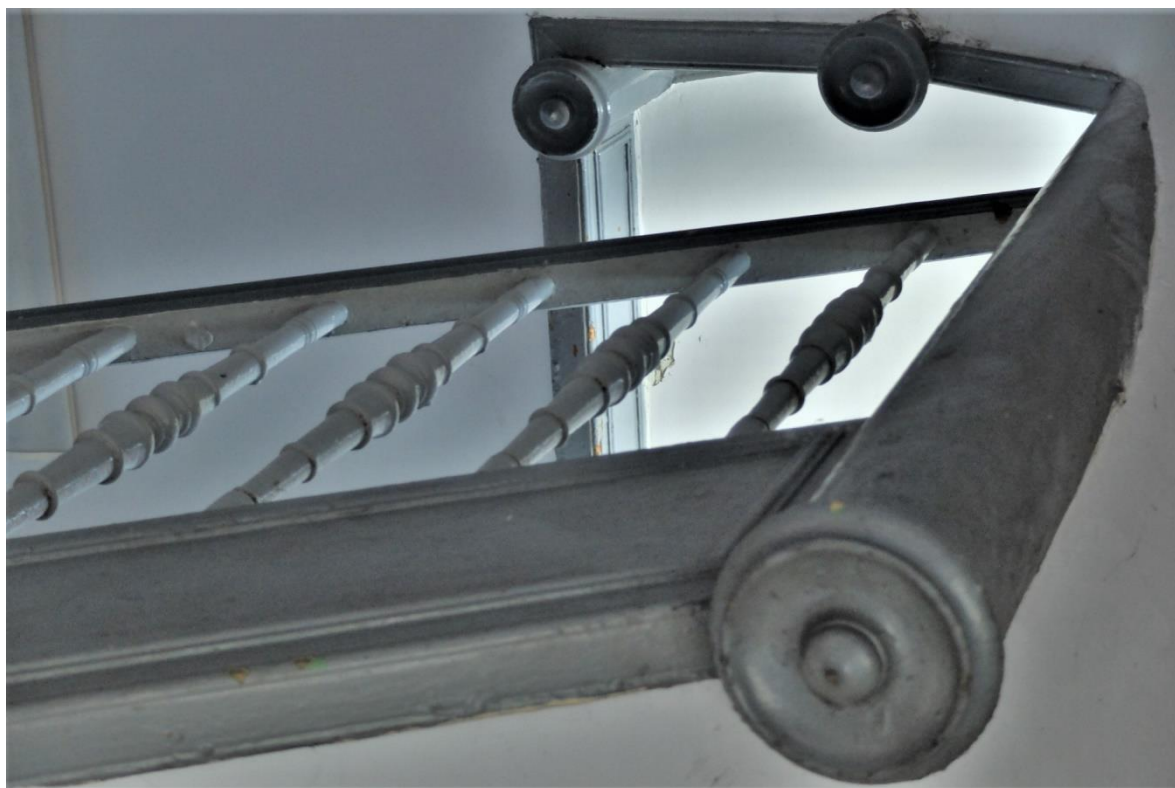
FOT. 66 - Klatka schodowa pomocnicza - zakończenie dolnej powierzchni słupków balustrady.
