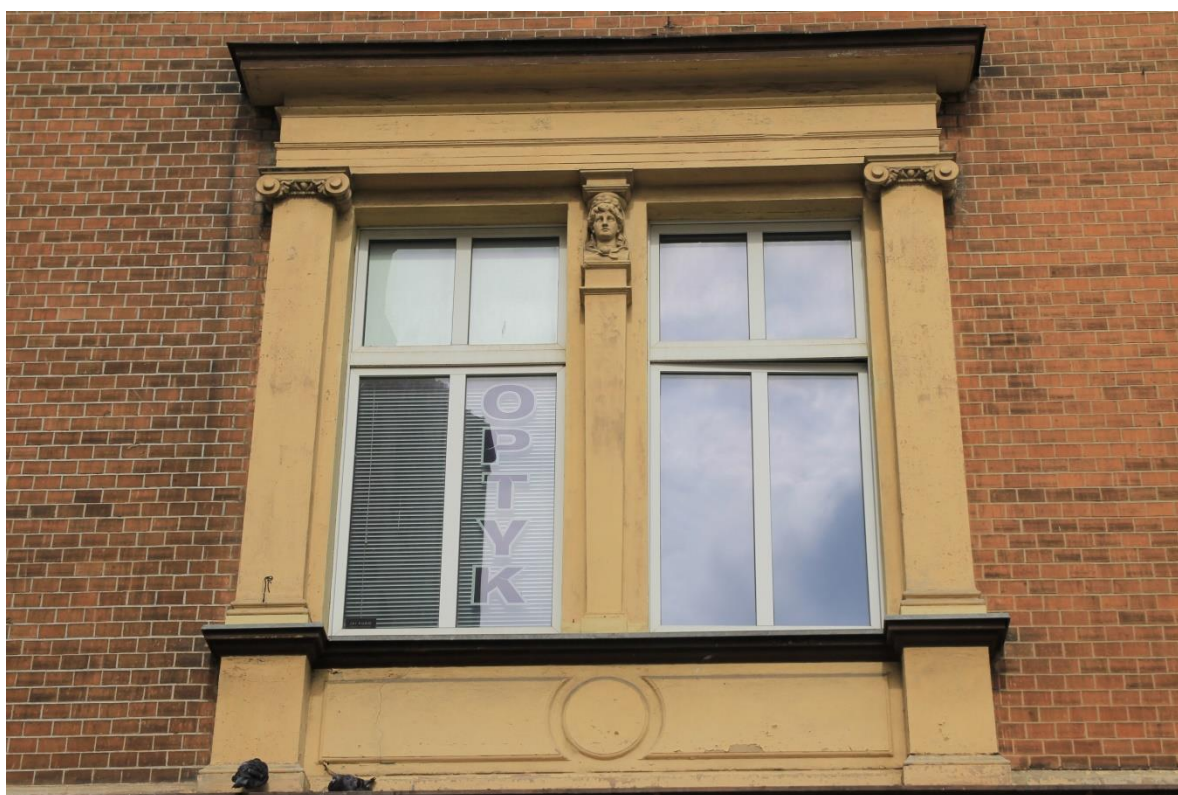
FOT. 2 - Elewacja południowa, obramienie okna piętra, widok ogólny.
