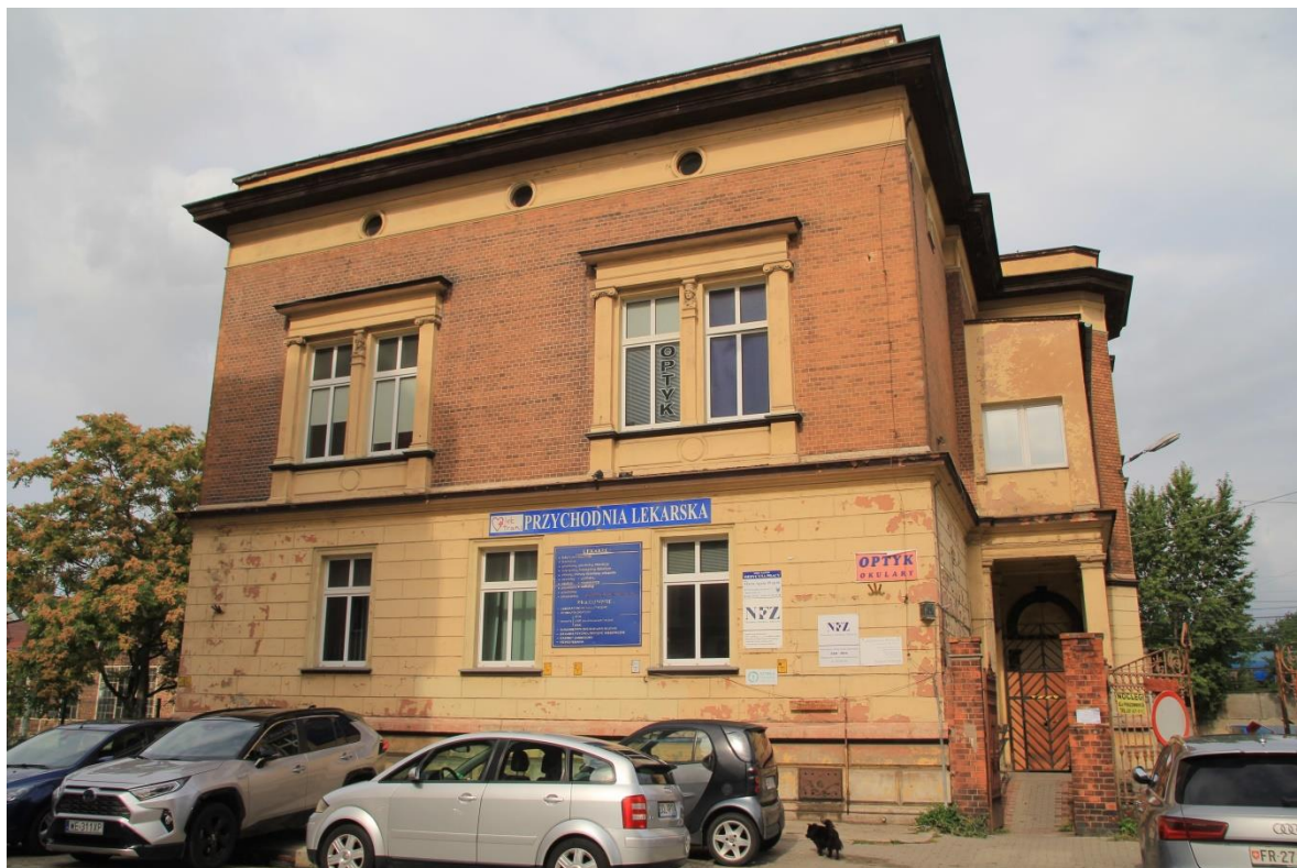
FOT. 1 - Elewacja południowa, widok ogólny
