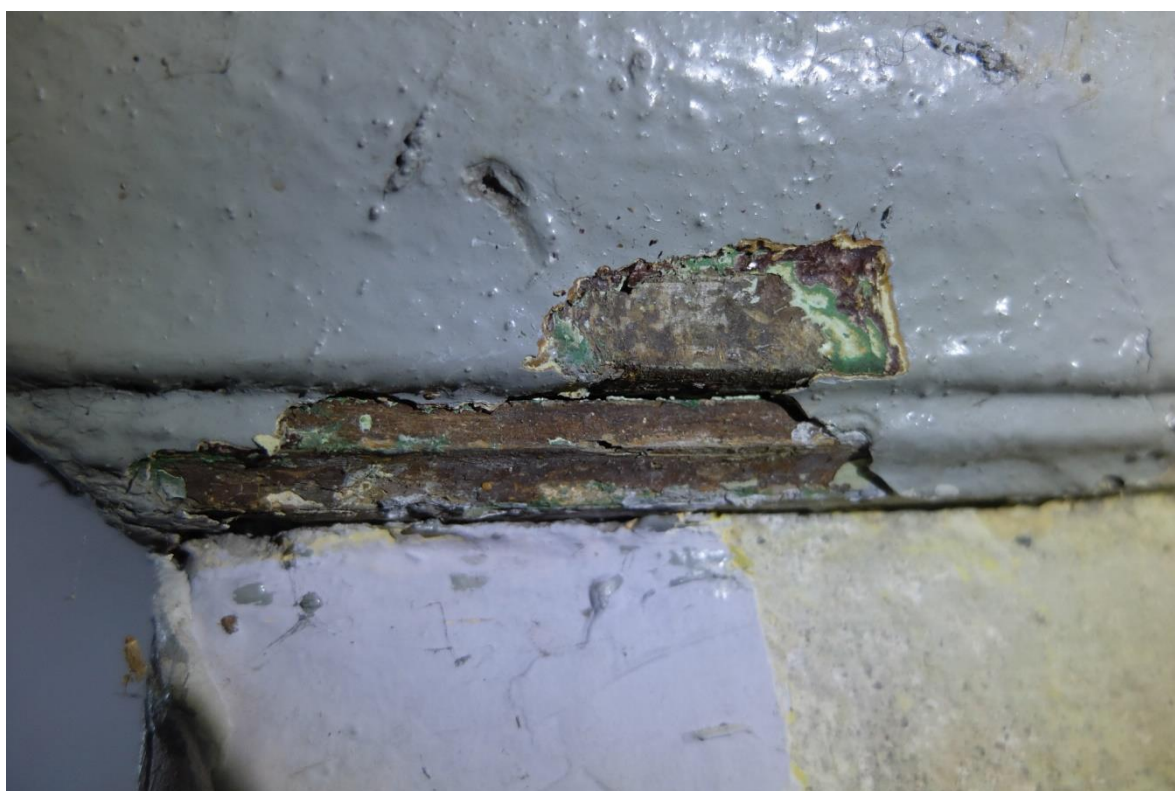
FOT. 62 - Klatka schodowa pomocnicza - powierzchni a boczna stopnicy, odkrywka
