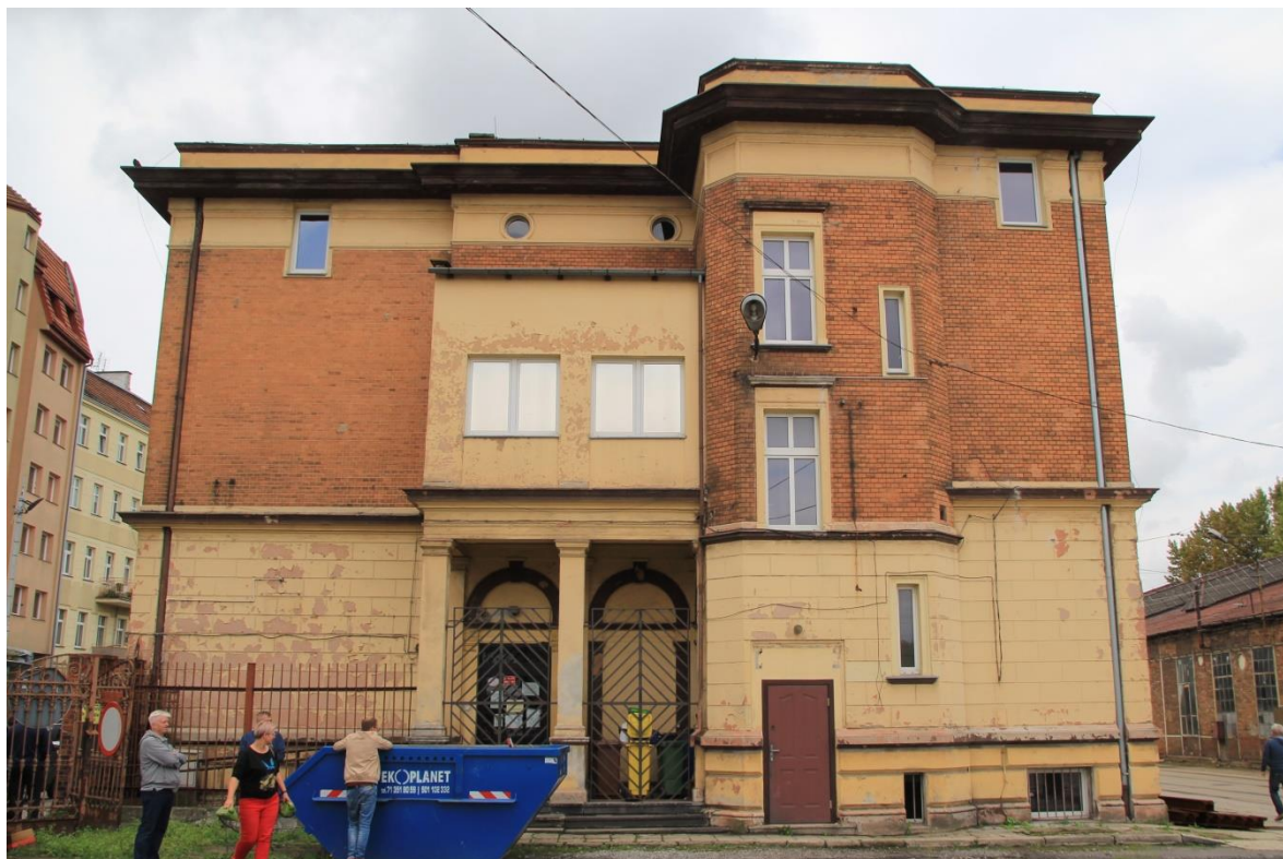
FOT. 3 - Elewacja wschodnia, widok ogólny.
