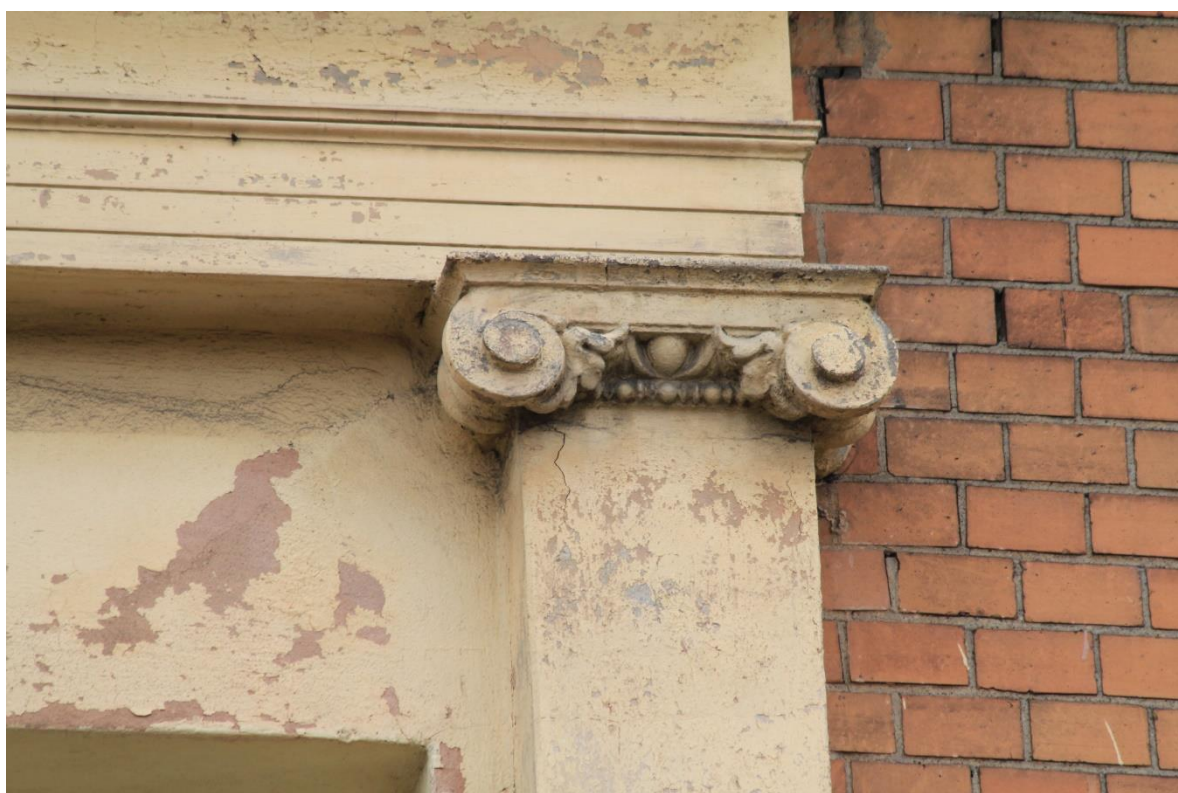
FOT. 12 - detal fot. 11 - obramienie okna osi zachodniej, fragment.
