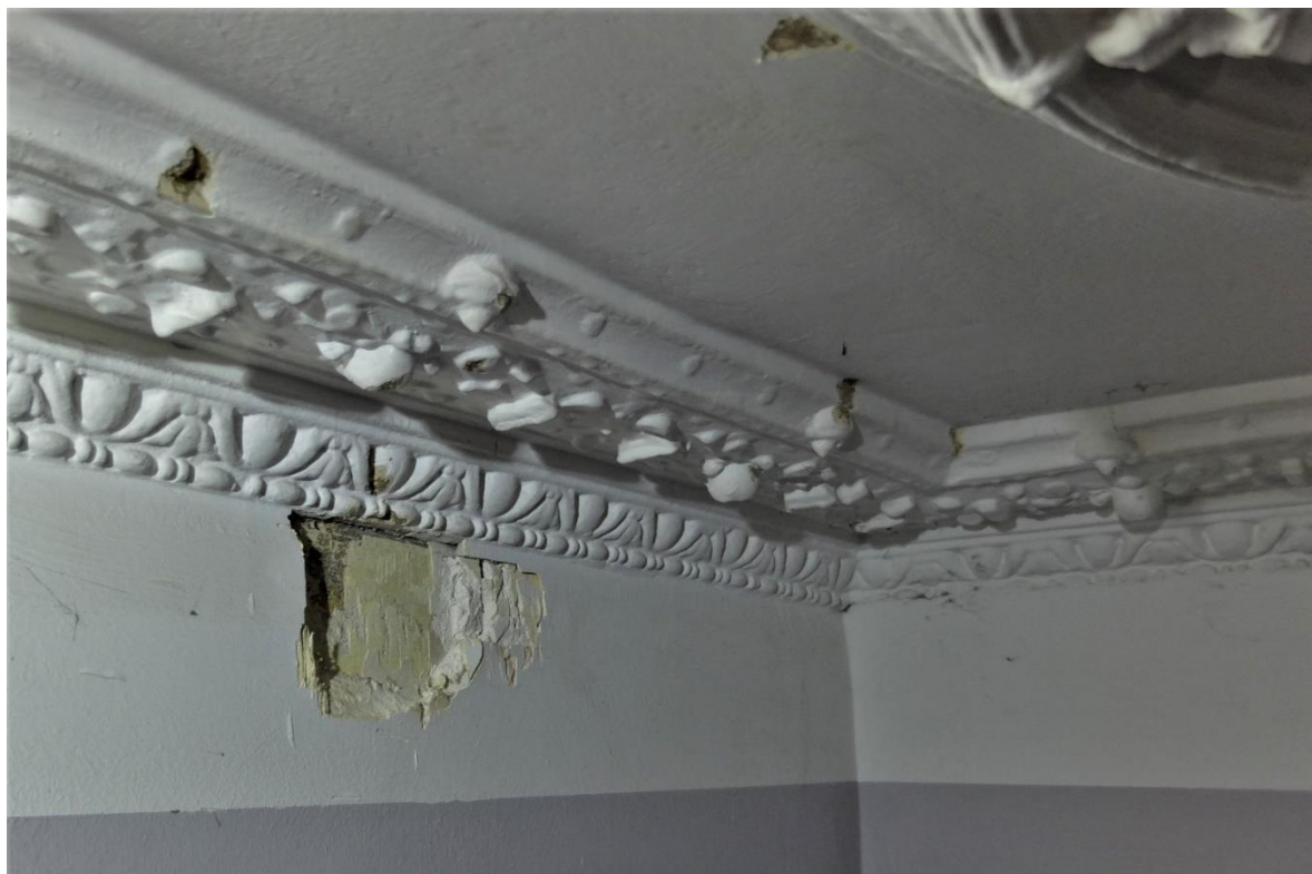
FOT. 27 - Klatka schodowa główna - parte. Ściana i strop w narożniku północno-zachodnim.
