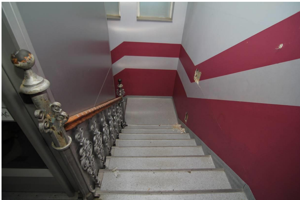
FOT. 35 - Klatka schodowa główna - podest półpiętra, widok ogólny z posadzki I piętra
