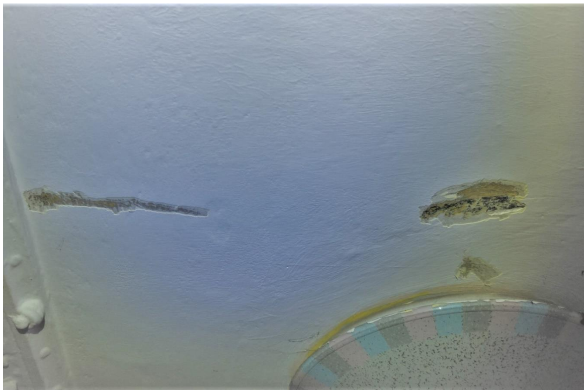
FOT. 31 - detal fot. 26 - odkrywki na powierzchni przęsta środkowego stropu, widok ogólny
