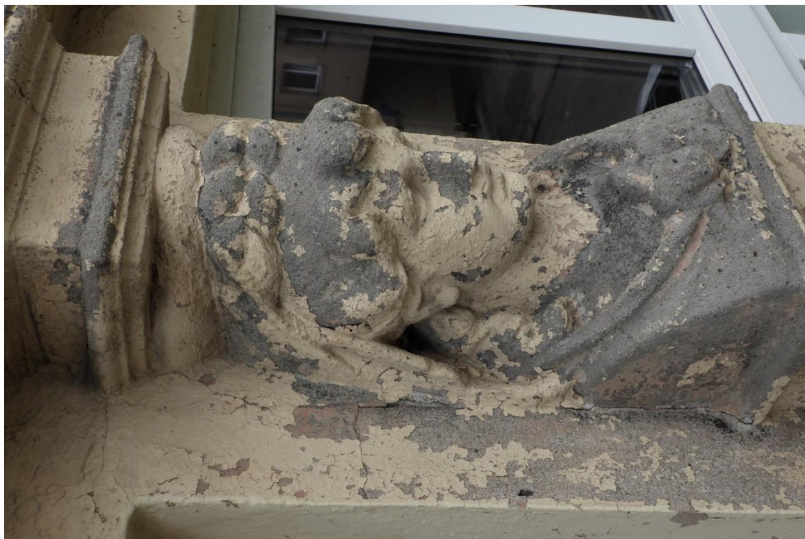
FOT. 15 - Kariatyda obramienia okna I kondygnacji - odlew w tynku cementowym.
