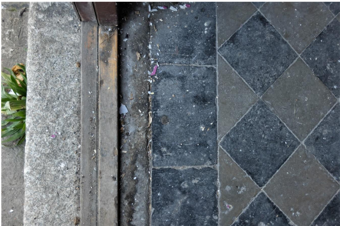
FOT. 50 - Klatka schodowa pomocnicza - próg granitowy i płytki lastriko posadzki przyziemia.
