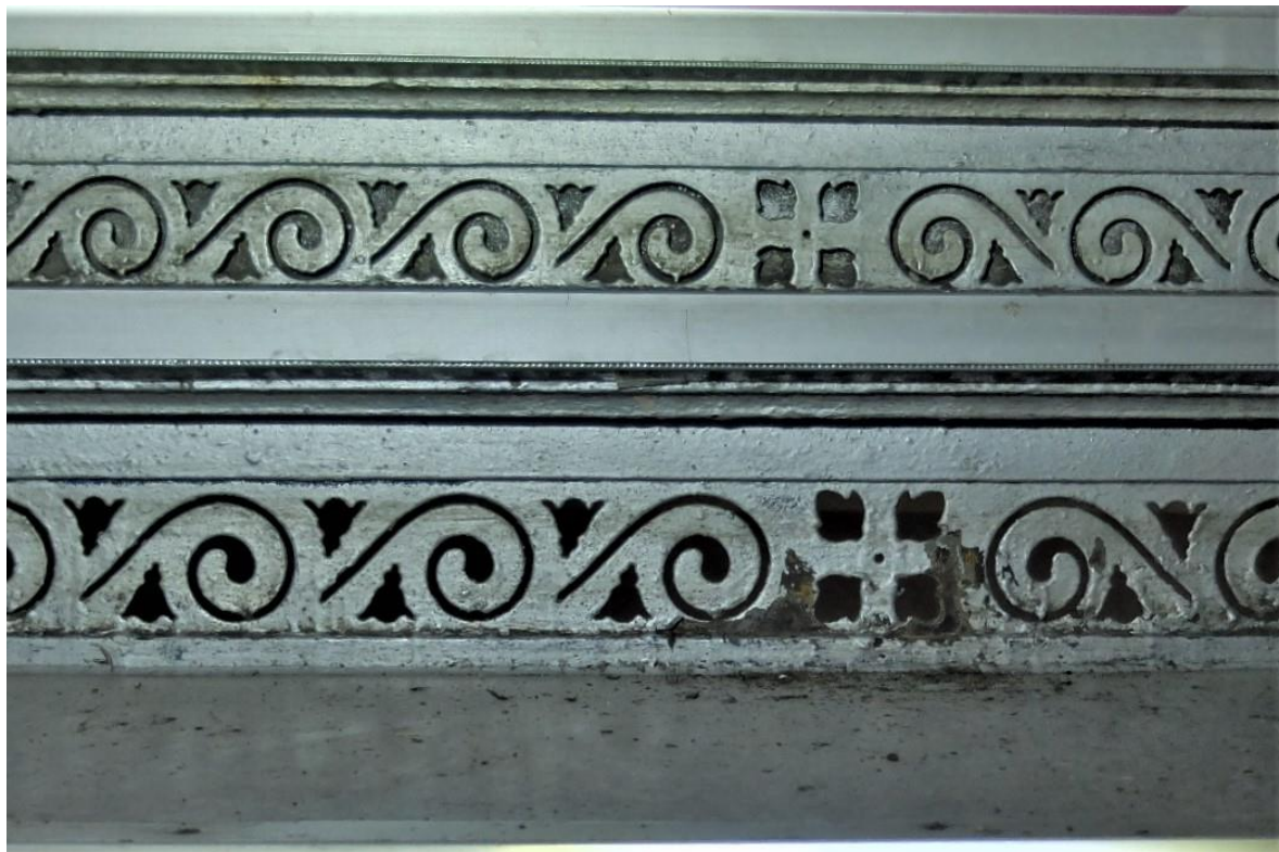
FOT. 41 - Klatka schodowa główna - podstopnice schodów, fragment.
