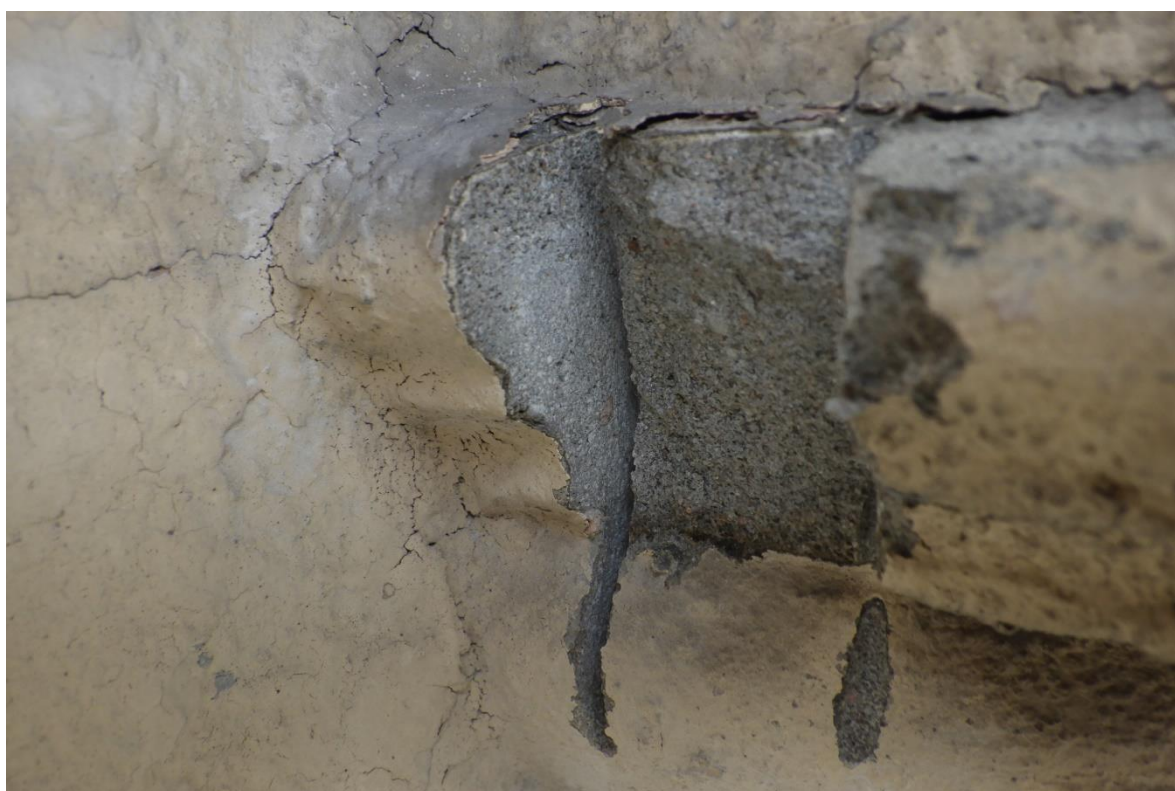
FOT. 16 - Obramienie okna I piętra, profil w miejscu pobrania próbki nr 16
