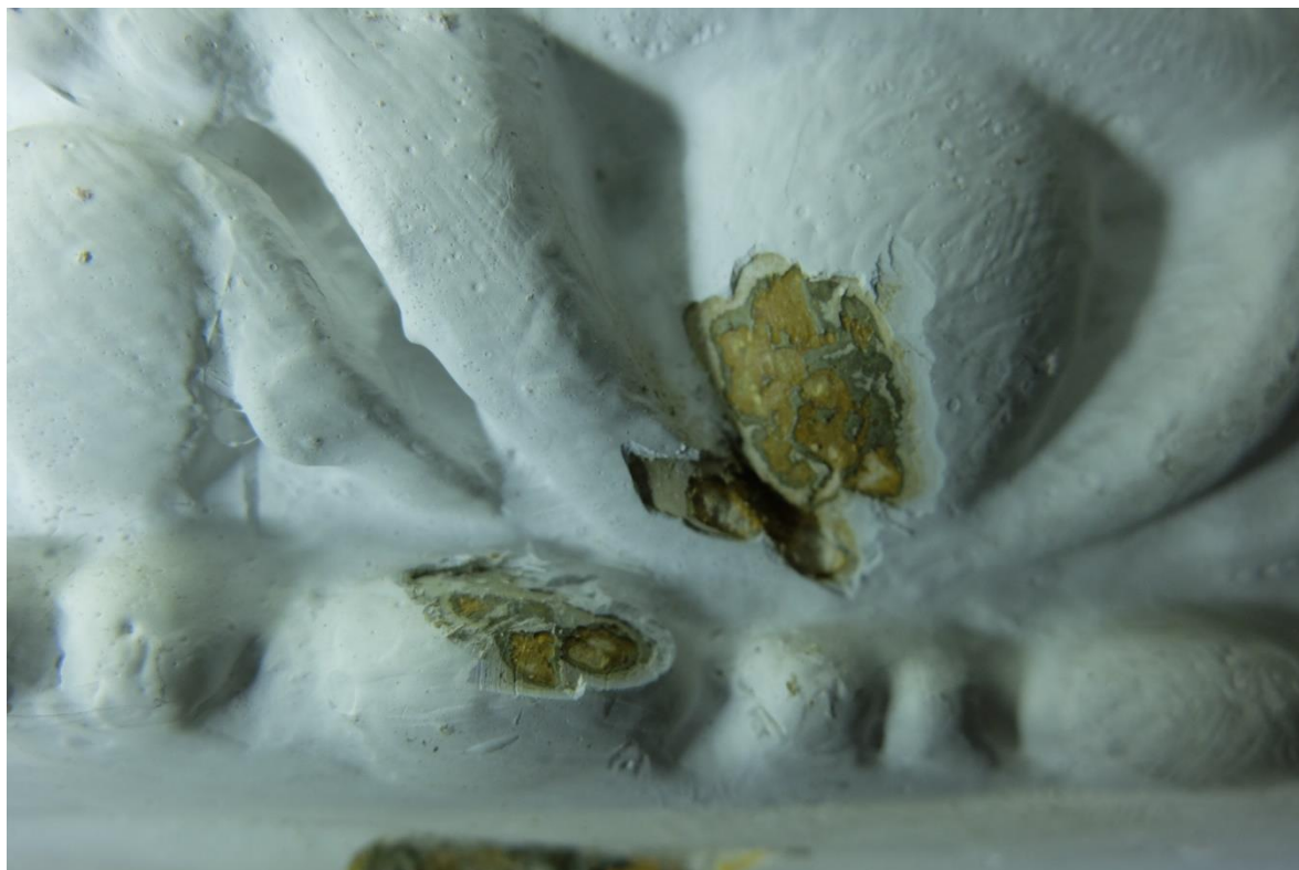
FOT. 33 - Gipsowa listwa dekoracyjna stropu, fragment.
