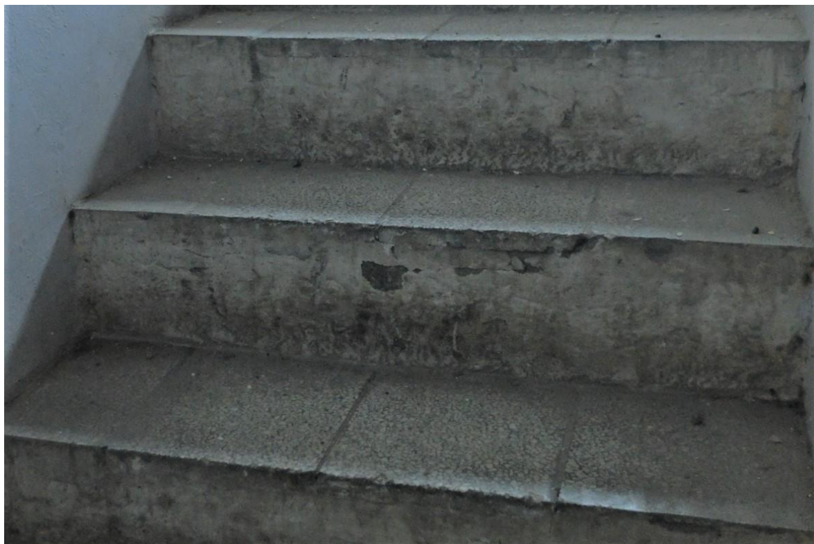
FOT. 51 - Klatka schodowa pomocnicza - schody do piwnicy, fragment - bloki granitu wyłożone płytkami lastriko.
