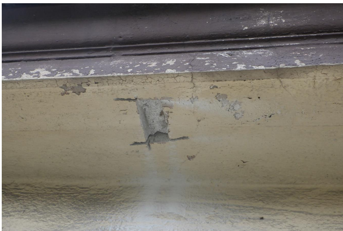
FOT. 14 - elewacja zachodnia, naczółek okna I piętra, fragment w miejscu pobrania próbki nr 14.
