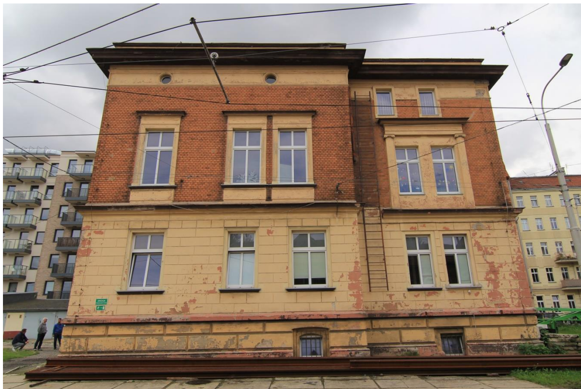
FOT. 11 - Elewacja północna, widok ogólny.
