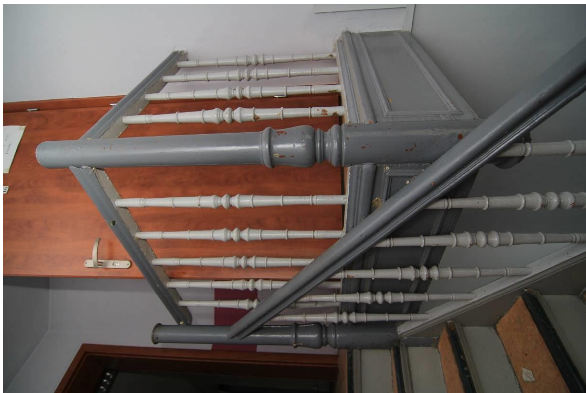
FOT. 70- Klatka schodowa pomocnicza - balustrada na poziomie poddasza.
