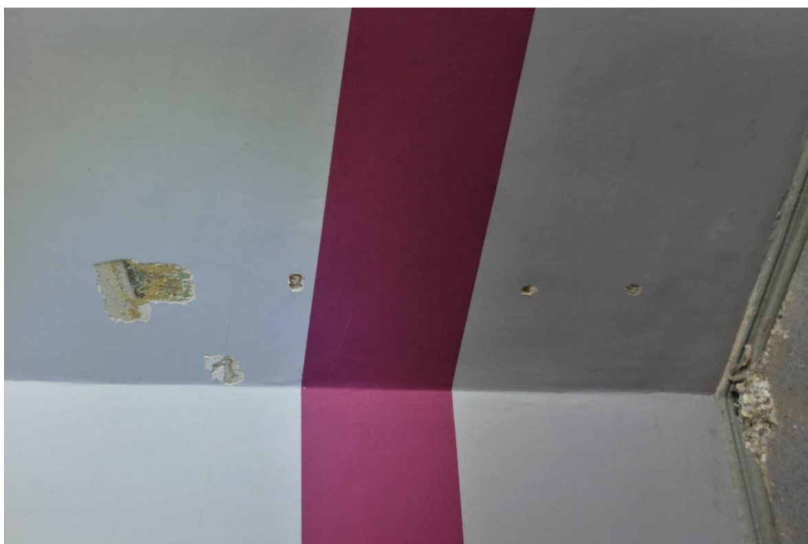
FOT. 58 - Klatka schodowa pomocnicza - podest piętra, ściana północna, odkrywki .
