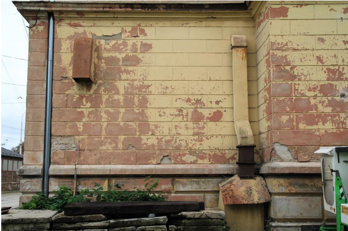
FOT. 17 - Elewacja zachodnia, fragment tynkowanej elewacji parteru.
