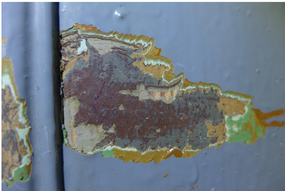
FOT. 63, 64 - Klatka schodowa pomocnicza - belka policzkowa, odkrywka - widok ogólny i fragment.
