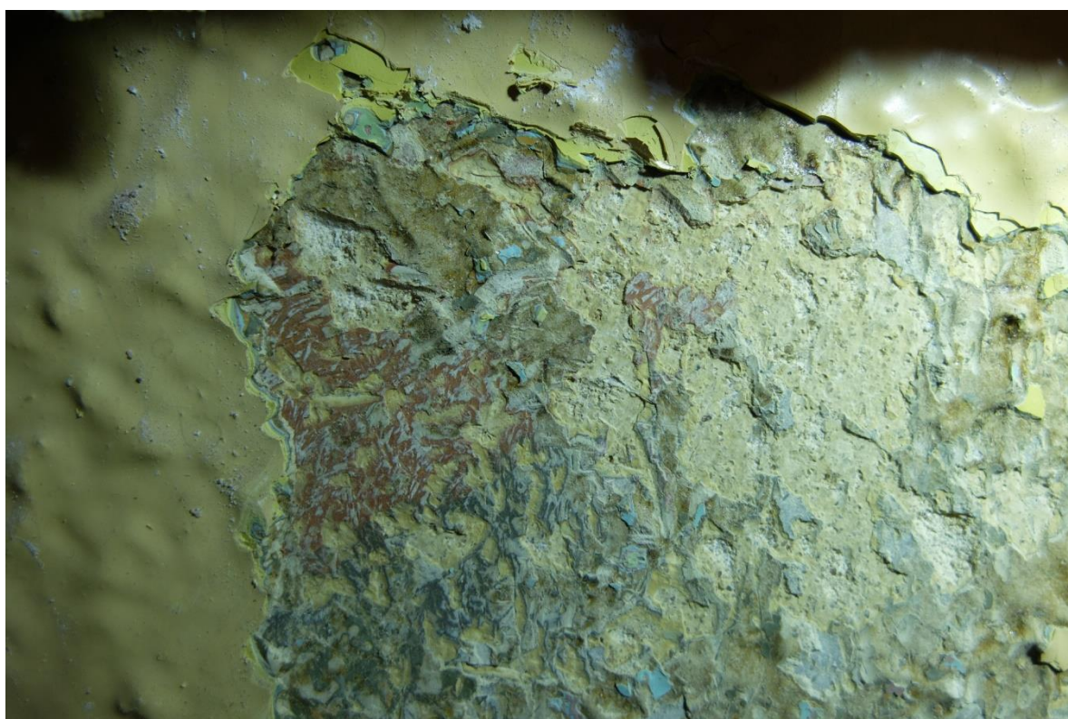
FOT. 38 - detal fot. 36 - odkrywka przy cokole ściany, fragment.
