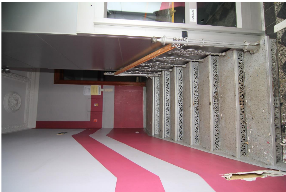
FOT. 23 - Klatka schodowa główna - wejście na poziom parteru, widok ogólny w kierunku zachodnim. ←
