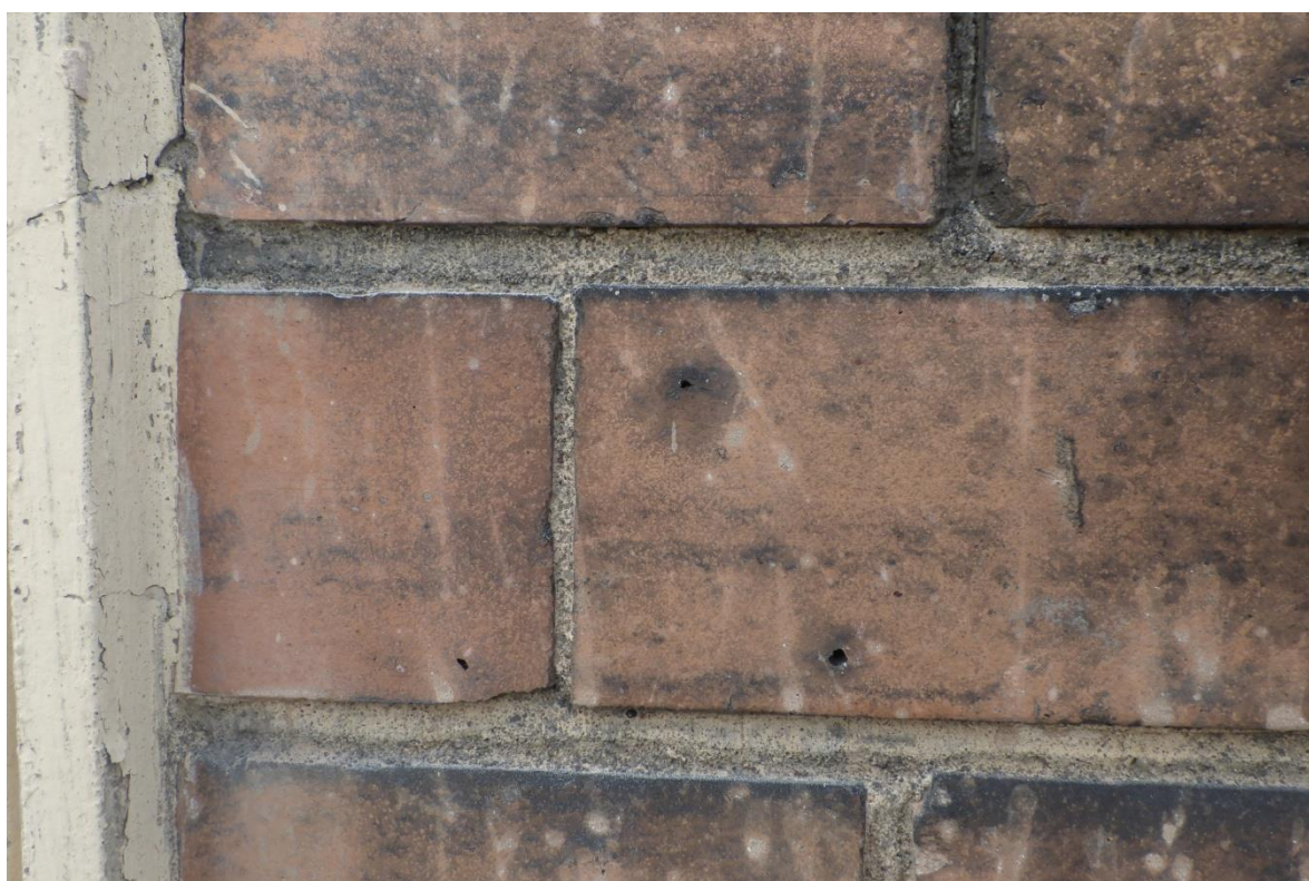
FOT. 8 - Elewacja wschodnia, lico ceglane i profilowana spoina muru.
