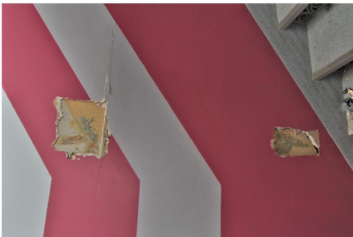
FOT. 36 - detal fot. 35 - odkrywki na powierzchni tynku I fazy chronologicznej.
