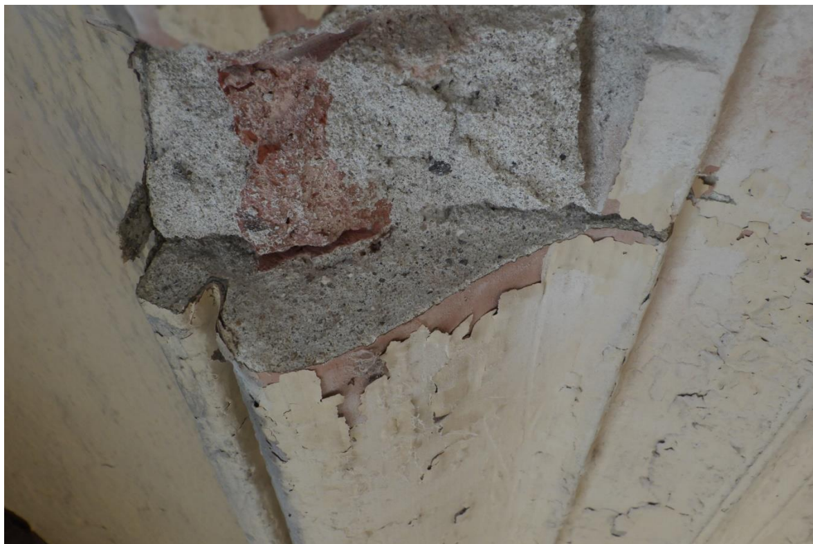
FOT. 5 - detal fot. 4 - profil ramy płytkiny w zwińczeniu w miejscu pobrania próbki nr 2.
