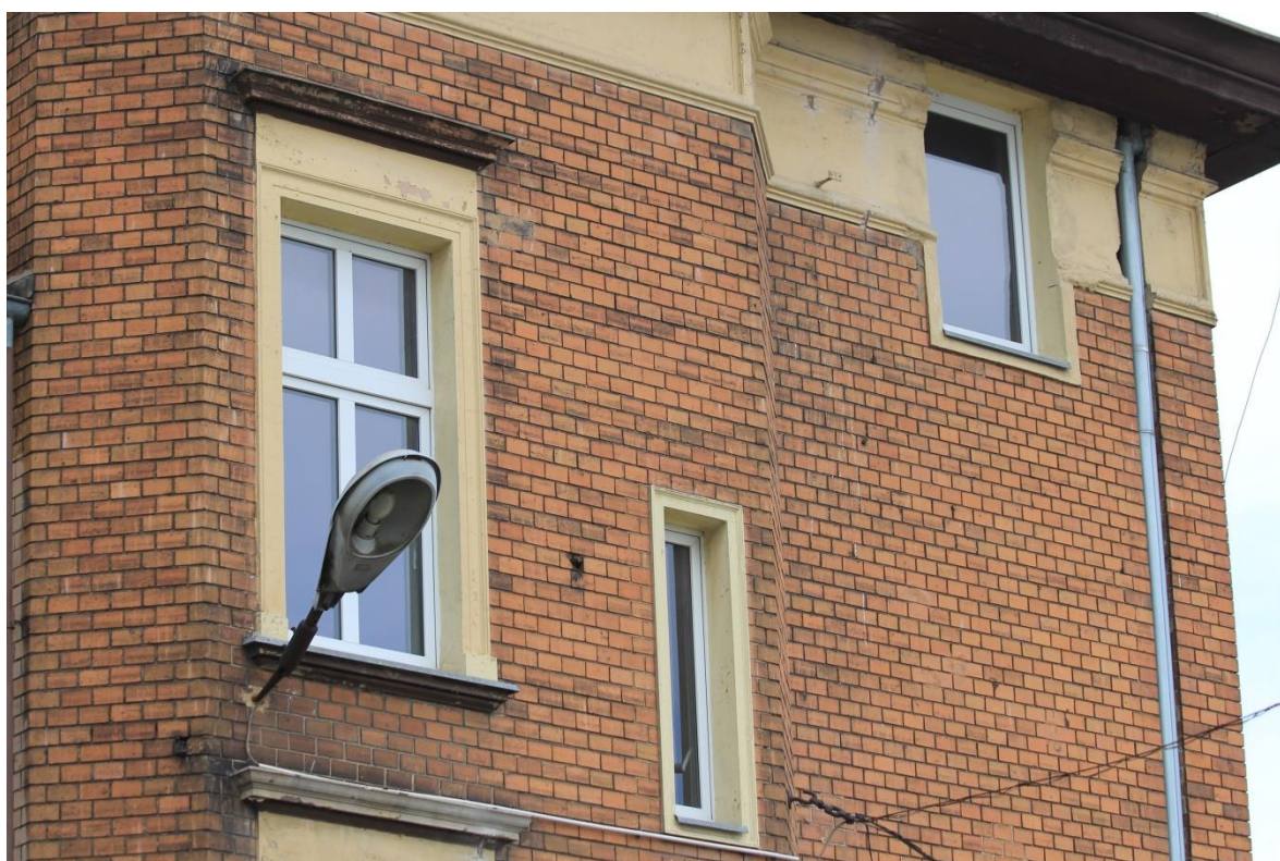
FOT. 4 - Elewacja wschodnia, fragment - ryzalit klatki schodowej pomocniczej. Stan po wykonaniu badań.
