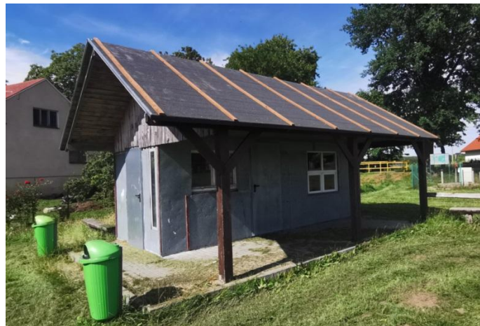
Budynek przeznaczony do rozbiórki
