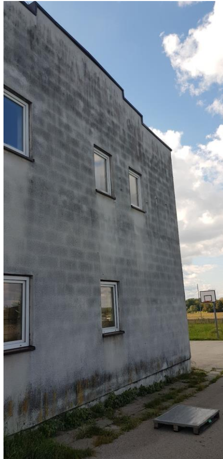
Fot. nr 4. Widok fragmentu elewacji północno-wschodniej
