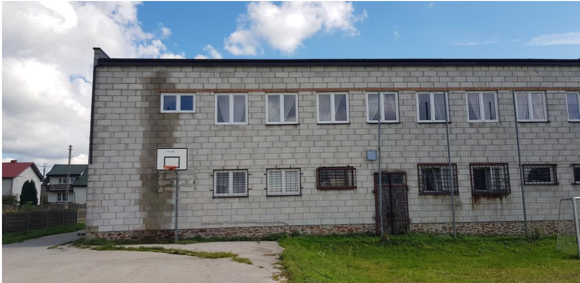
Fot. nr 2. Widok elewacji północno-zachodniej
