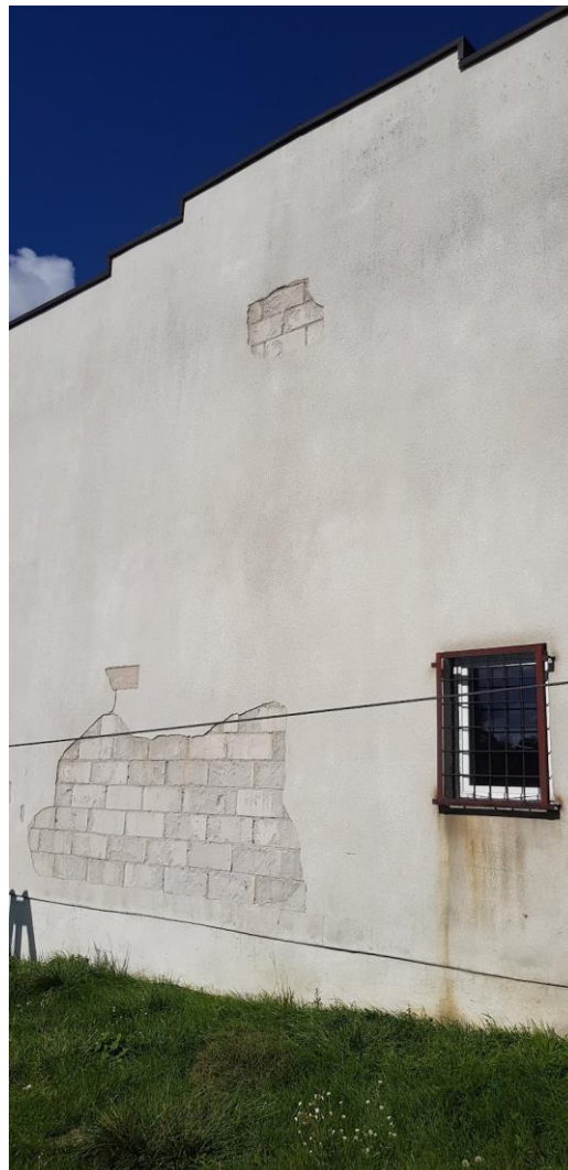
Fot. nr 3. Widok fragmentu elewacji południowo-zachodniej
