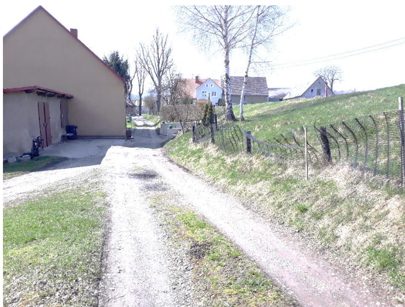
Fotografia 2. Odcinek drogi przed bud. nr 25. Widoczne koleiny i zawyżone pobocza.
