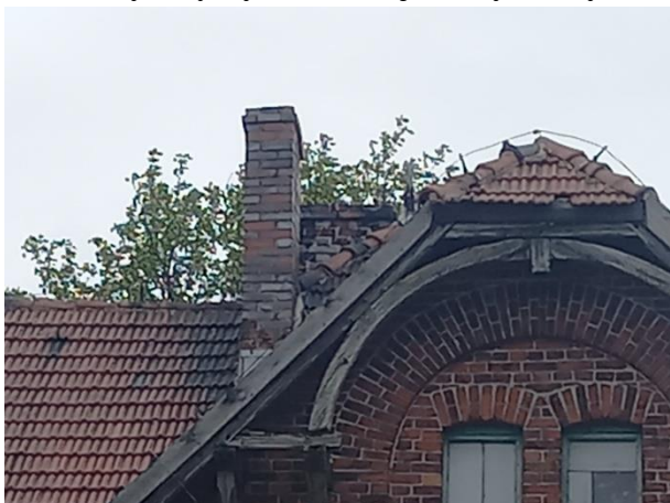
Elementy więźby dachowej do wymiany
