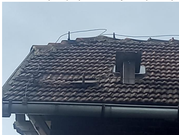
Pokrycie dachu do wymiany
