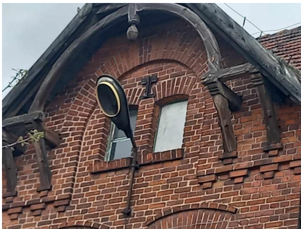
Elementy więźby dachowej do wymiany
