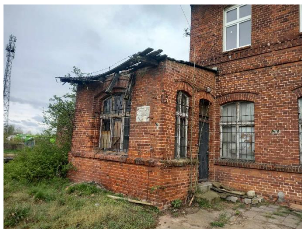
Niższa część budynku z dachem do całkowitej wymiany
