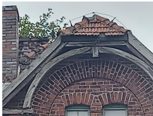
Elementy więźby dachowej do wymiany
