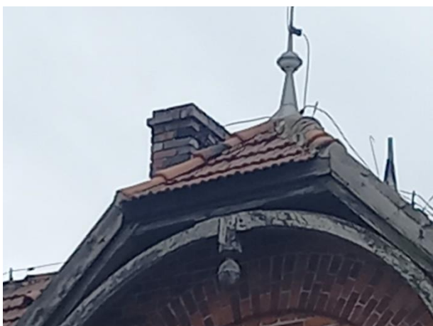
Elementy więźby dachowej do wymiany
