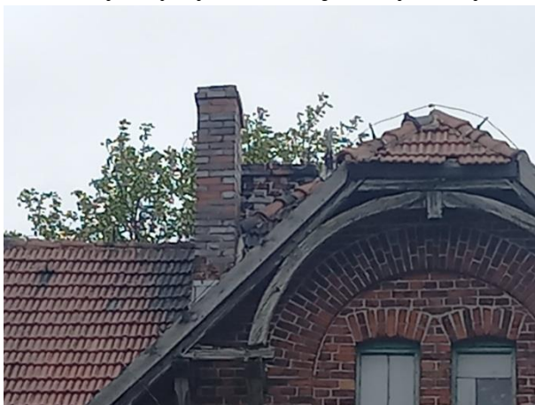
Elementy więźby dachowej do wymiany
