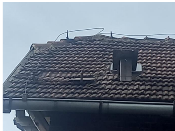
Pokrycie dachu do wymiany
