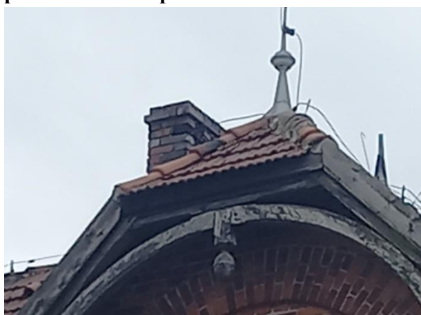
Elementy więźby dachowej do wymiany
