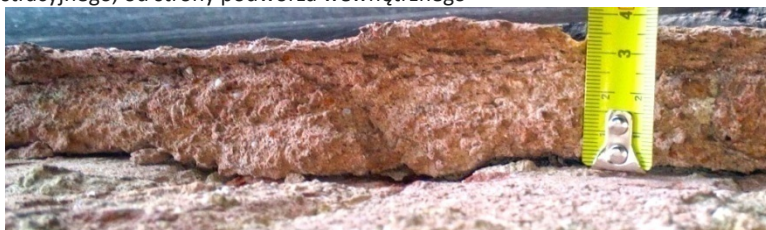
Widok przekroju warstwy tynku wapiennego barwionego w masie mączką ceglana, grubość około 3-5 cm, widoczny odspojonej elewacji budynku administracyjnego, od strony podwórza wewnętrznego
