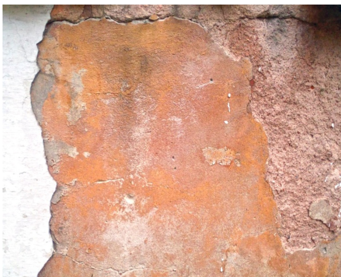
Widok warstwy tynku wapiennego barwionego w masie, mączką ceglana oraz późniejszych warstw naprawczych tynku.
