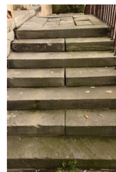
bieg lewy schodów
