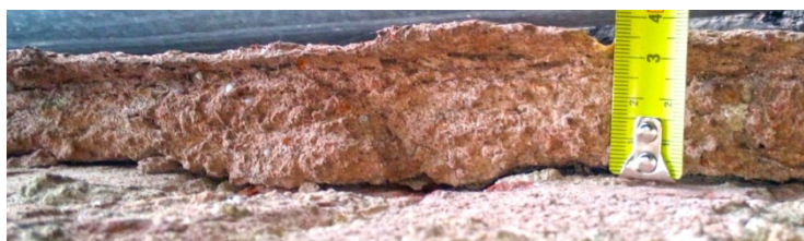
Widok warstwy tynku wapiennego barwionego w masie, mączką ceglana oraz późniejszych warstw naprawczych tynku.
