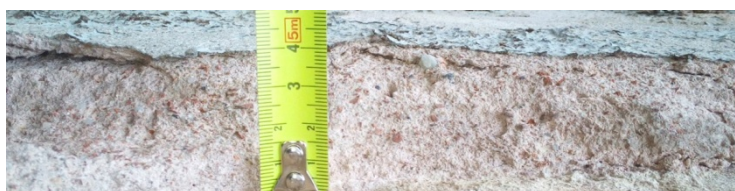
Przekrój warstwy tynku pierwotnego, grubość około 3-5 cm, ściana elewacji frontowej budynku biurowego, od strony podwórza wewnętrznego.
