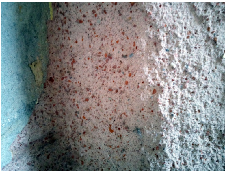
Widok przekroju warstwy tynku wapiennego barwionego w masie mączką ceglana, grubość około 3-5 cm, widoczny odspojonej elewacji budynku administracyjnego, od strony podwórza wewnętrznego
