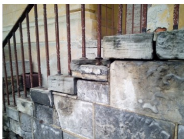
schody styk biegu z obudową ściany oporowej
