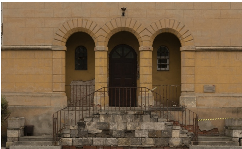
Widok biegu schodowego i spocznika schodów wejścia do budynku administracyjnego więzienia - stan obecny
