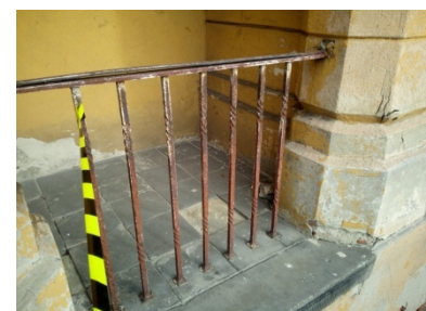
schody poręcz podestu wejścia głównego
