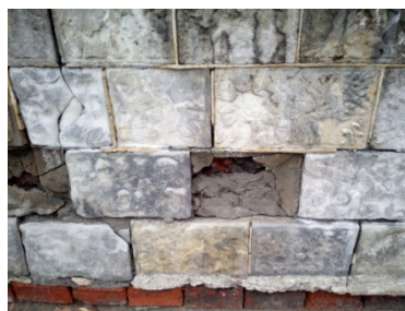
kamienna obudowa ściany oporowej schodów
