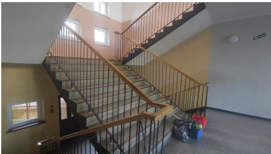
Fot. 5 Klatka schodowa 2 - widok z parteru
