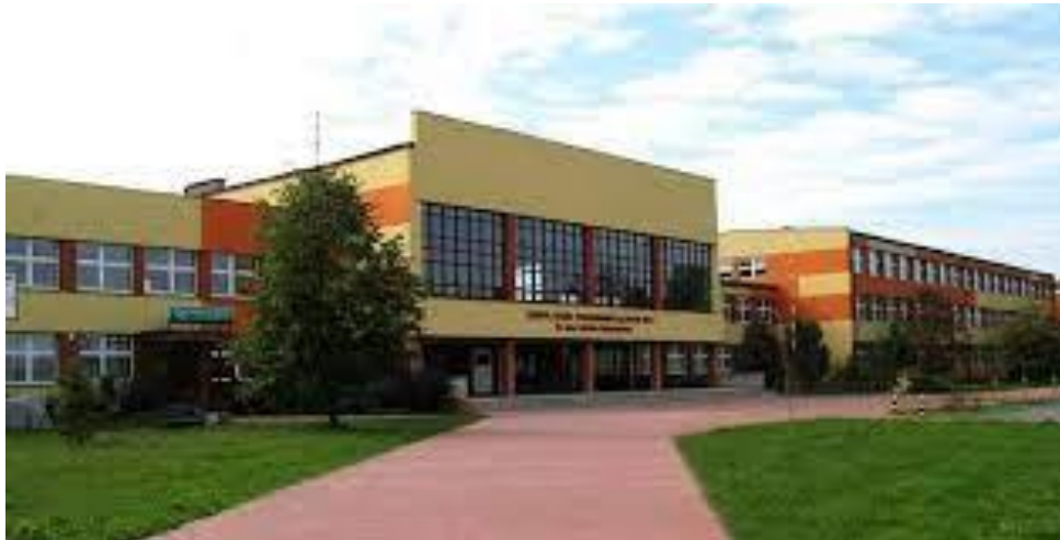
Fot.2. Widok od frontu na budynek szkoły
