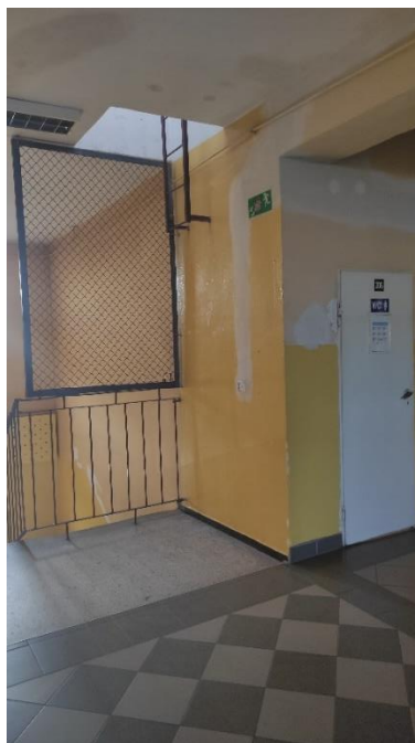
Fot. 7 Klatka schodowa 3 - widok z piętra 2
