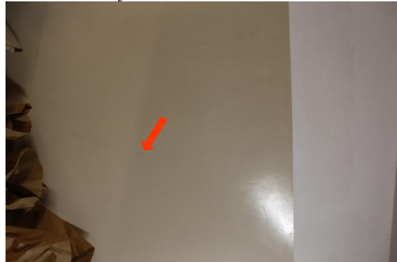
Pomieszczenie 2 – piwnica, zarysowanie ścian
