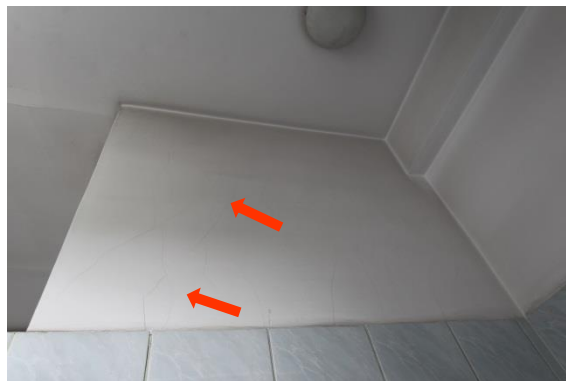
Pomieszczenie 15 – I piętro, zarysowania ściany i komina
