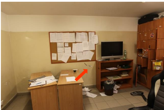
Pomieszczenie 3 – piwnica, zarysowanie ścian
