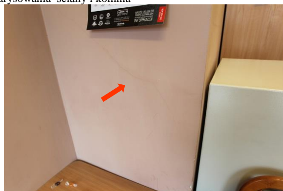
Pomieszczenie 5 – I piętro, zarysowania ściany i komina
