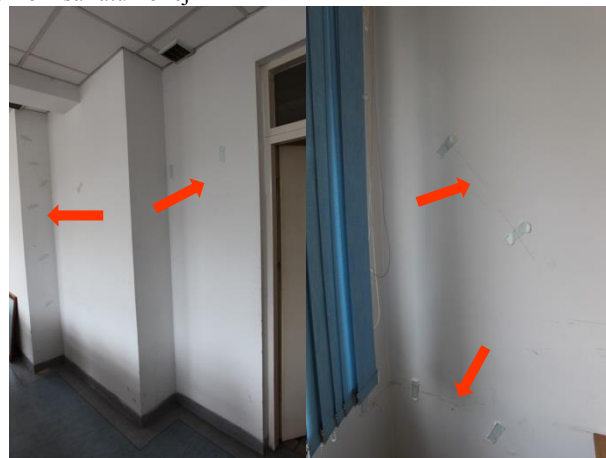
Pomieszczenie 1 – I piętro zarysowania ścian i komina
