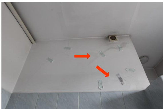
Pomieszczenie 15 – I piętro, zarysowania ściany i komina
