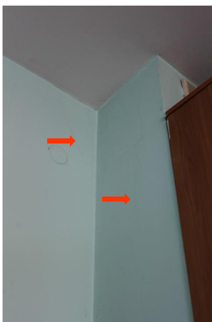
Pomieszczenie 4 – parter, zarysowanie ściany i komina
