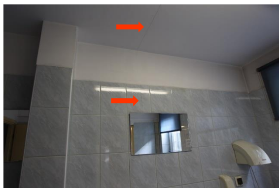
Pomieszczenie 7 – piwnica, zarysowanie ściany
