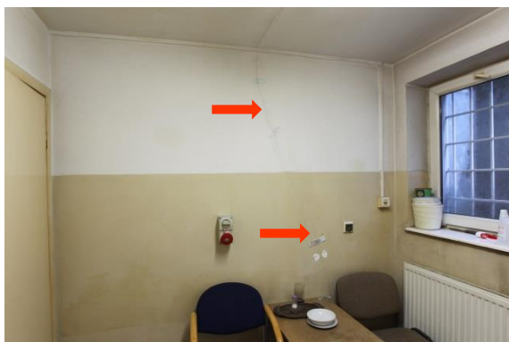
Pomieszczenie 11 – piwnica, zarysowanie ścian
