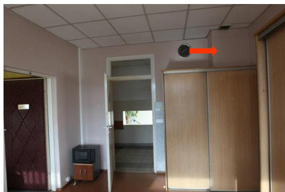
Pomieszczenie 3 – I piętro zarysowania ścian i komina
