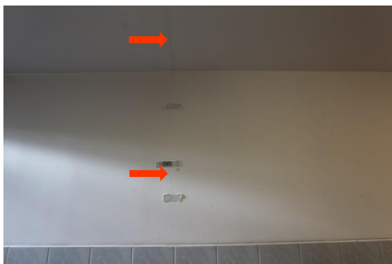
Pomieszczenie 6 – piwnica, zarysowanie ściany i stropu
