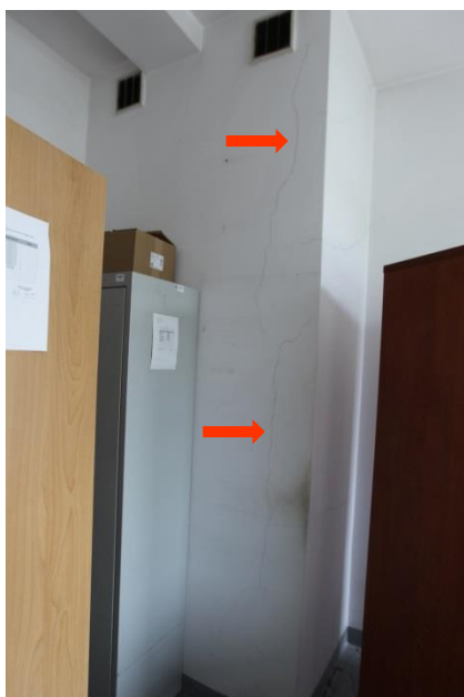
Pomieszczenie 5 – I piętro, zarysowania ściany i komina
