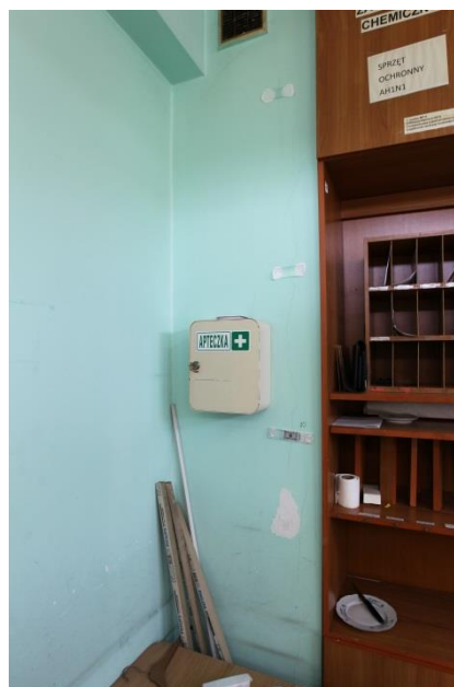
Pomieszczenie 5 – parter, zarysowanie ściany
