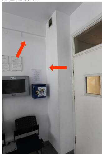
Pomieszczenie 2 – parter, zarysowanie ściany i komina
