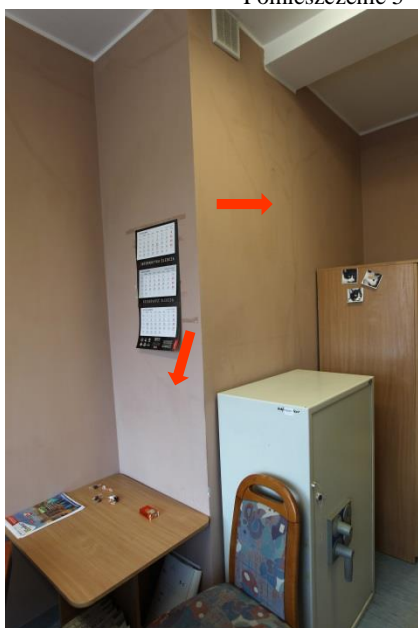
Pomieszczenie 5 – I piętro, zarysowania ściany i komina
