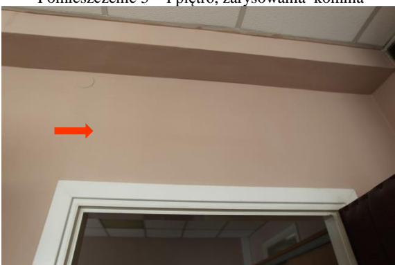
Pomieszczenie 3 – I piętro, zarysowania komina
