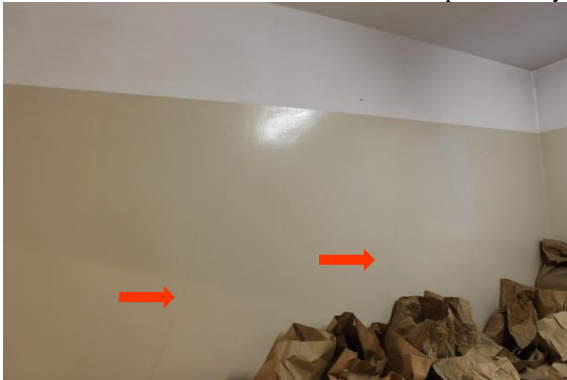
Pomieszczenie 2 – piwnica, zarysowanie ścian
