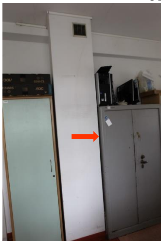
Pomieszczenie 1 – parter, zarysowanie komina
