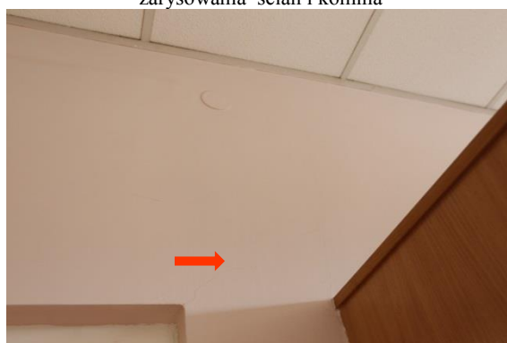
Pomieszczenie 3 – I piętro, zarysowania ściany
