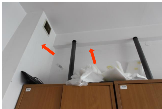
Pomieszczenie 16 – parter, zarysowanie ściany i komina
