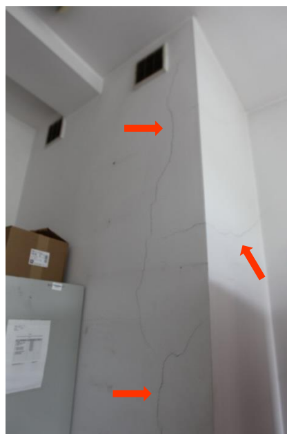
Pomieszczenie 5 – I piętro, zarysowania ściany i komina
