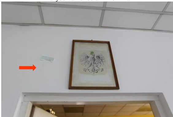
Pomieszczenie 1 – I piętro, zarysowania ściany nad drzwiami wew. między pomieszczeniami 1 i 2
