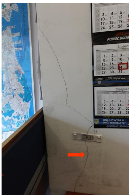
Pomieszczenie 13 – parter, zarysowanie ścian i komina
