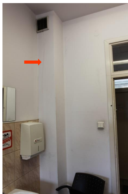
Pomieszczenie 13 – parter, zarysowanie ścian i komina
