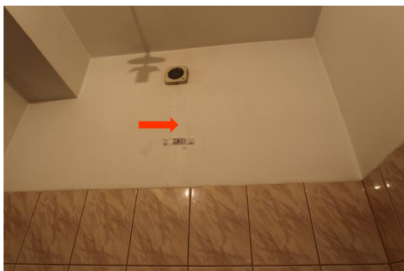
Pomieszczenie 12 – parter, zarysowanie ściany
