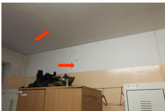
Pomieszczenie 10 – piwnica, zarysowanie ściany i stropu
