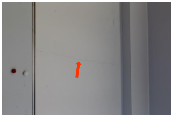
Pomieszczenie 17 – I piętro, zarysowania ściany i komina
