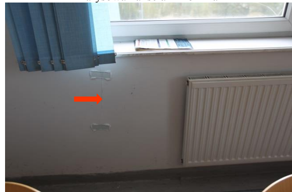
Pomieszczenie 1 – I piętro zarysowania ściany pod oknem
