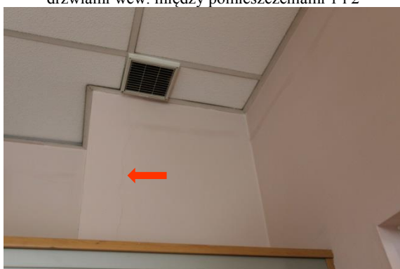
Pomieszczenie 3 – I piętro, zarysowania komina
