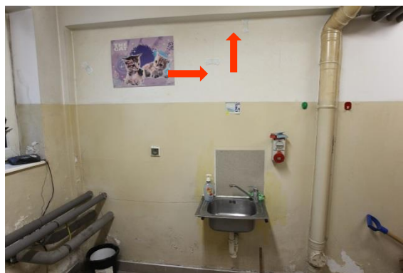
Pomieszczenie 11 – piwnica, zarysowanie ścian
