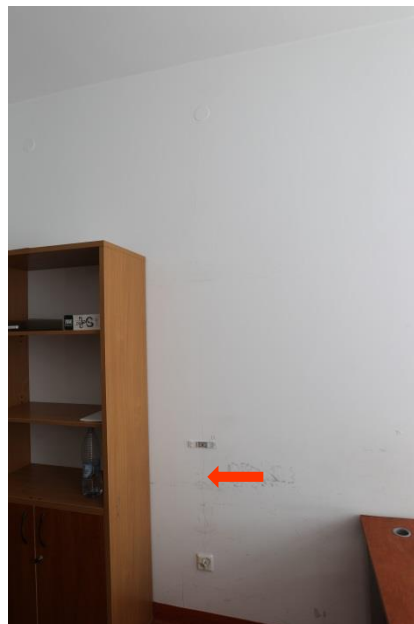
Pomieszczenie 9 – parter, zarysowanie ściany
