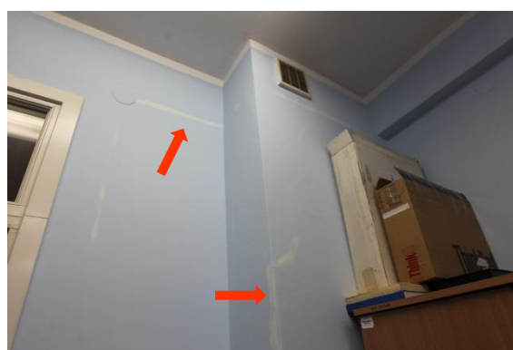
Pomieszczenie 9 – I piętro, zarysowania ściany i komina
