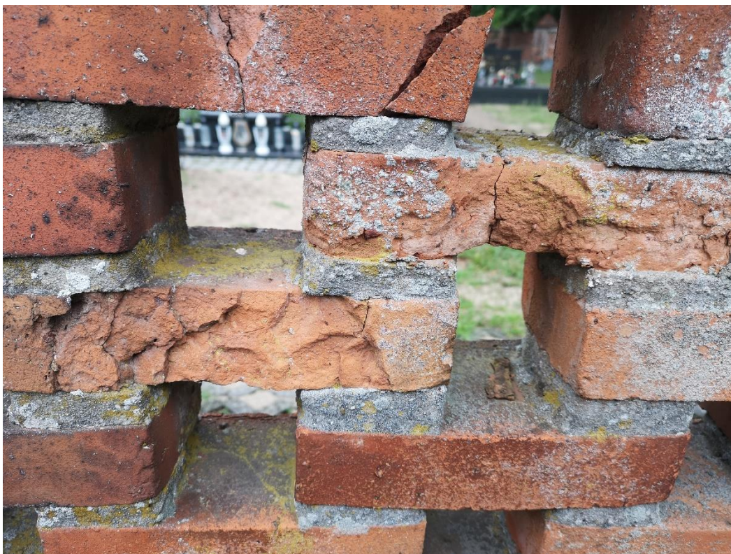
Zła jakość zastosowanej cegły
