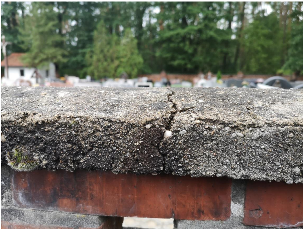
Betonowe pokrywy przęseł z licznymi spękaniem i przemieszczeniem
