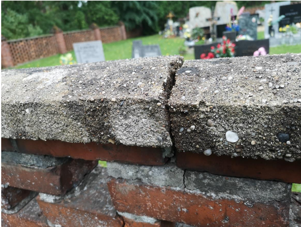
Betonowe pokrywy przęseł z licznymi spękaniem i przemieszczeniem
