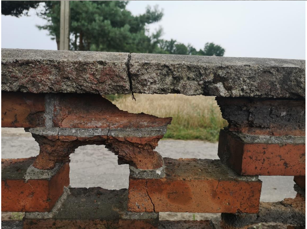
Stan techniczny przęseł
