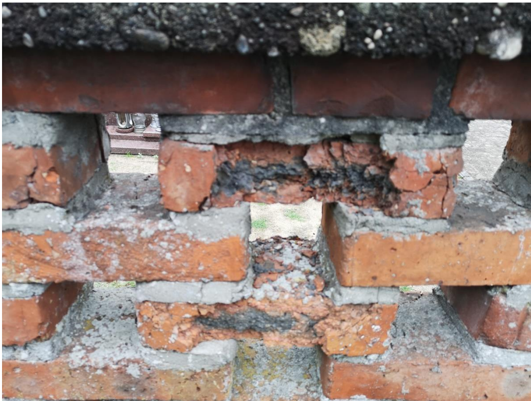
Zła jakość zastosowanej cegły
