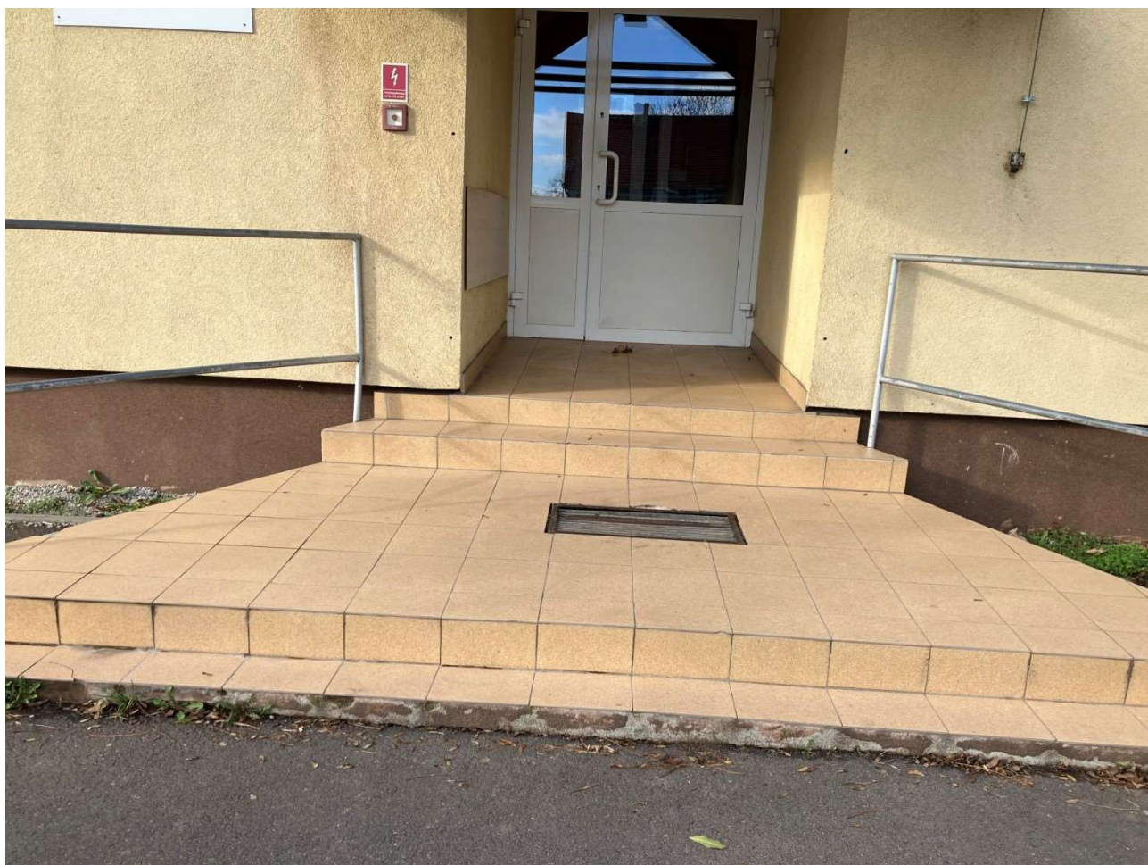
WEJŚCIE GŁÓWNE DO BUDYNKU – ELEWACJA WSCHODNIA SCODY OD STRONY PODJAZDU DLA NIEPEŁNOSPRAWNYCH – ELEWACJA WSCHODNIA
