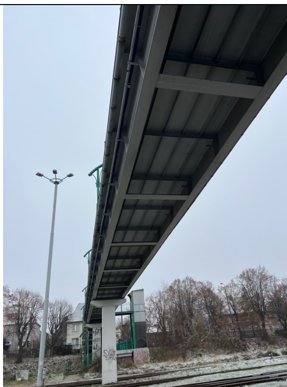
Fot. 4. Widok na ustrój nośny
