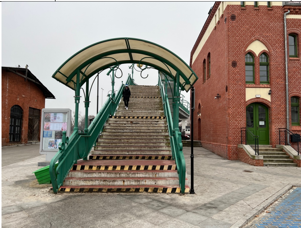
Fot. 1. Widok ogólny od strony zachodniej.
