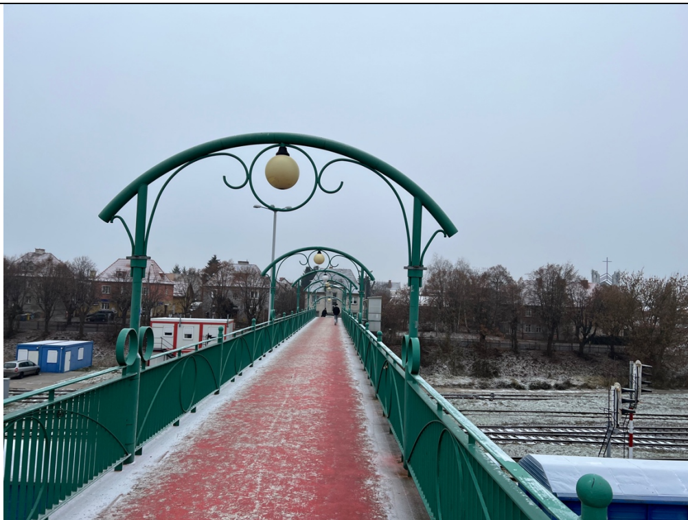
Fot. 2. Widok ogólny od strony zachodniej.
