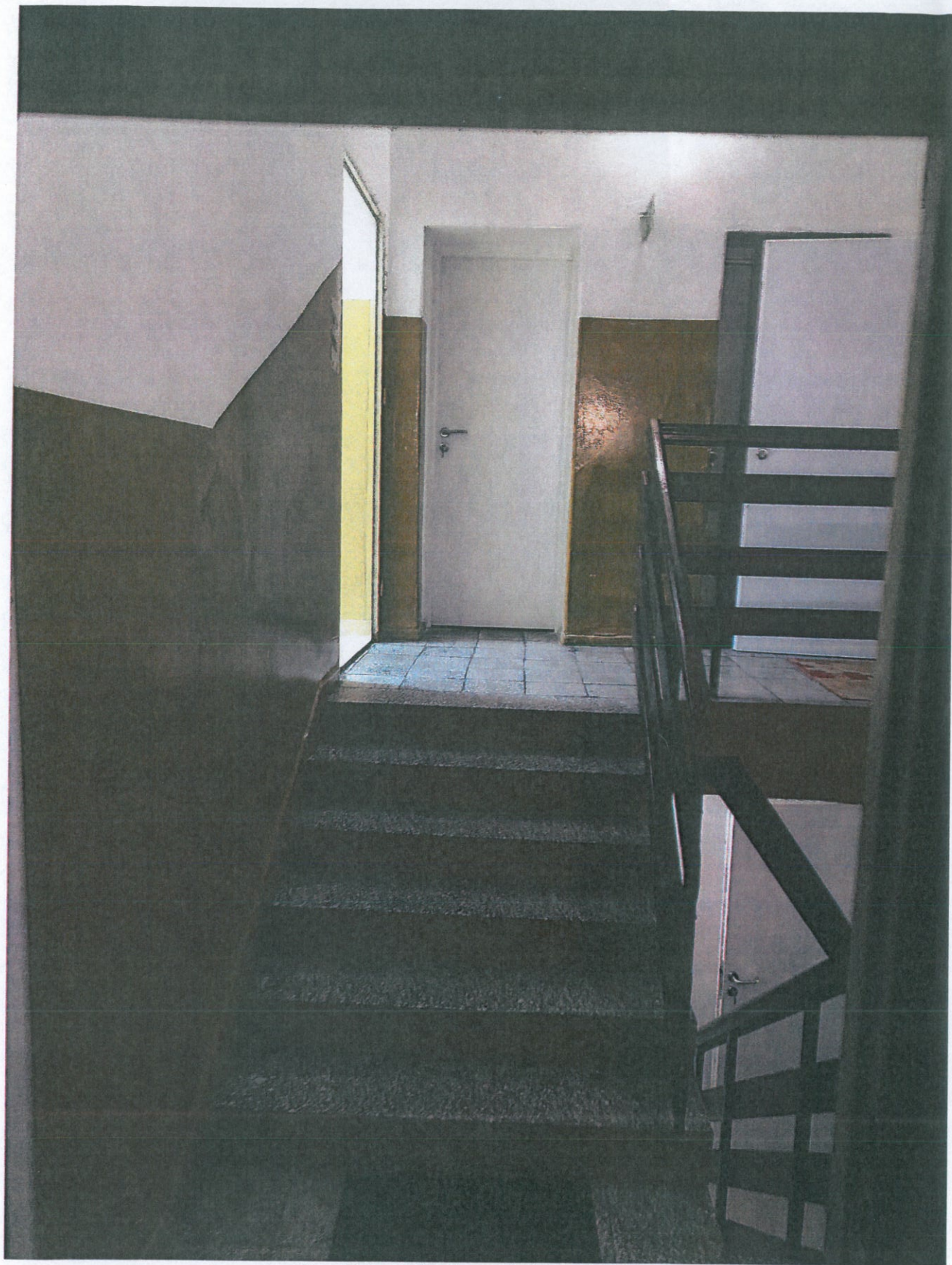
Fot. P-5 – Widok na klatkę schodową
