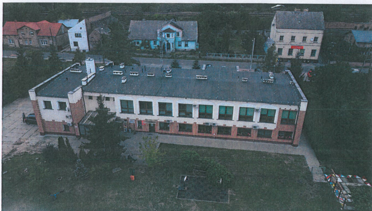
Fot. P-2 – Elewacja północna budynku
