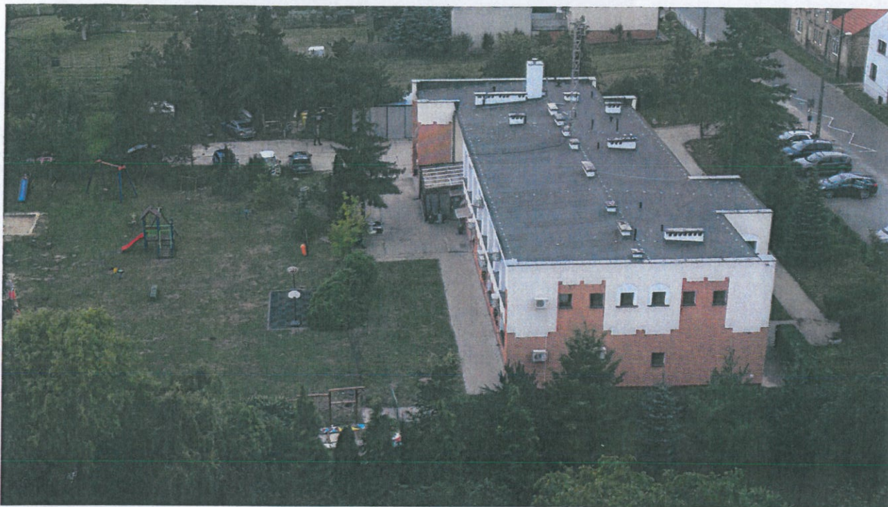
Fot. P-1 – Elewacja zachodnia budynku
