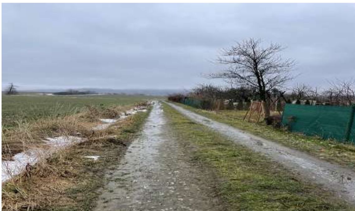
Zdj. nr 3 Początkowa część drogi
