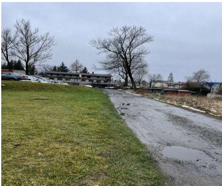
Zdj. nr 2 Początkowa część drogi
