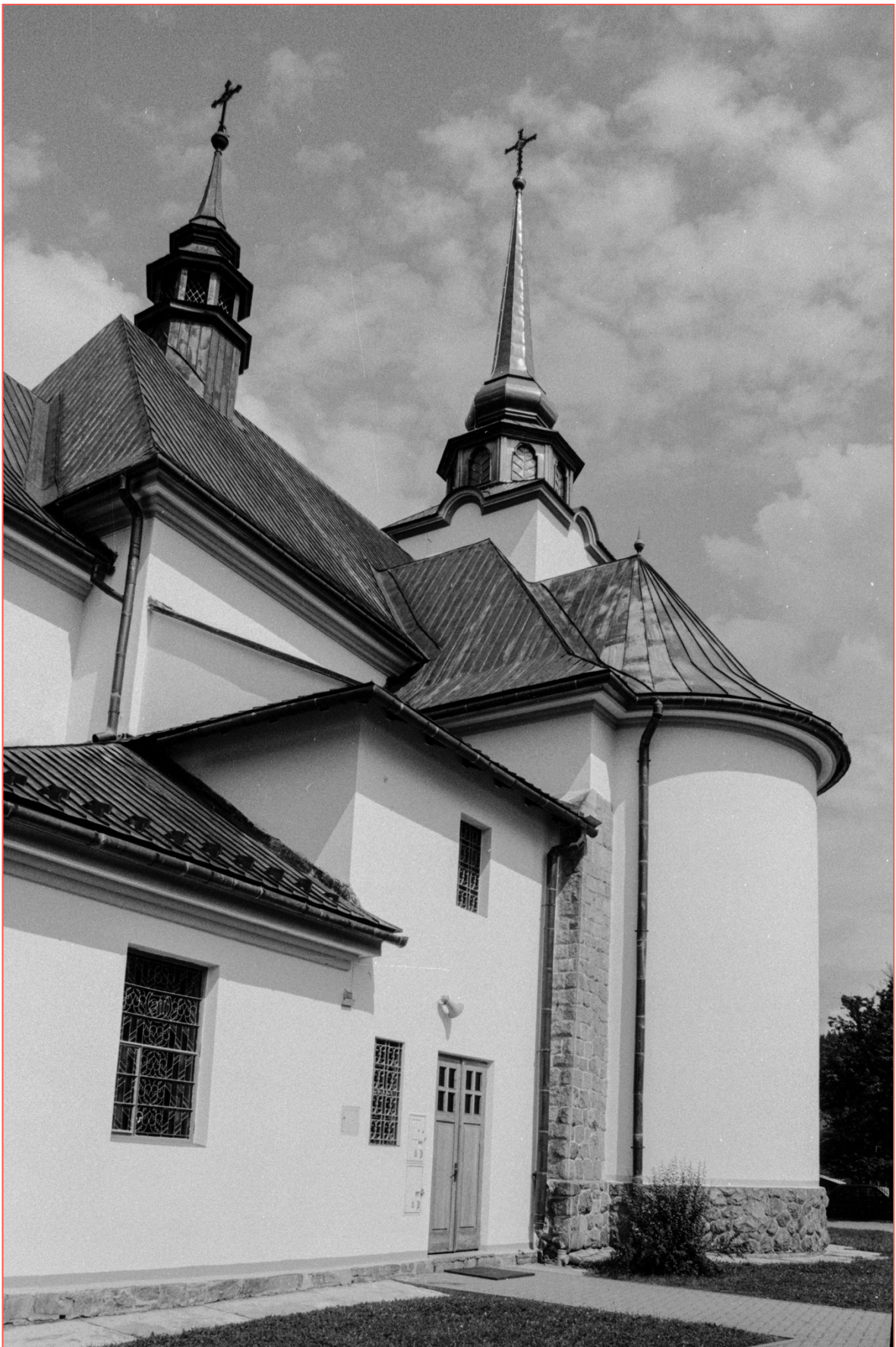
13. Widok fragmentu elewacji południowej. Fot. D. Moździerz, 15 VII 2000
