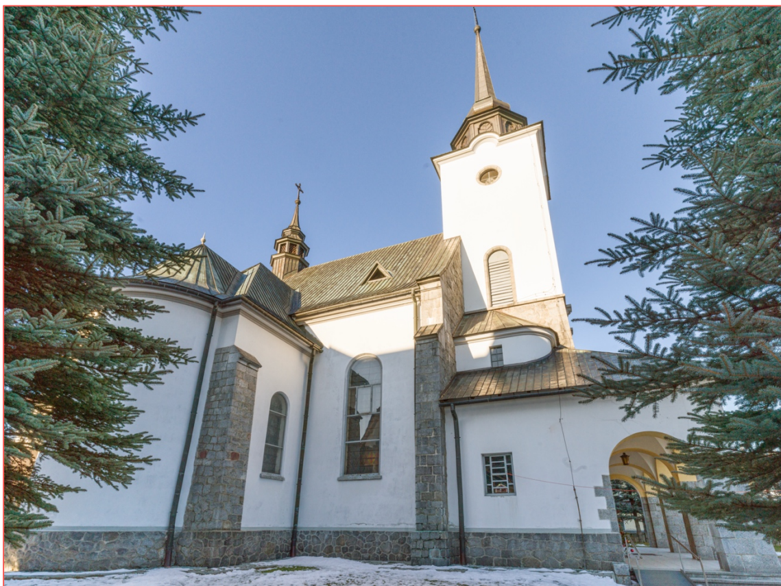
27. Fragment elewacji południowej. Fot. Z. Moździerz, 14 I 2023
