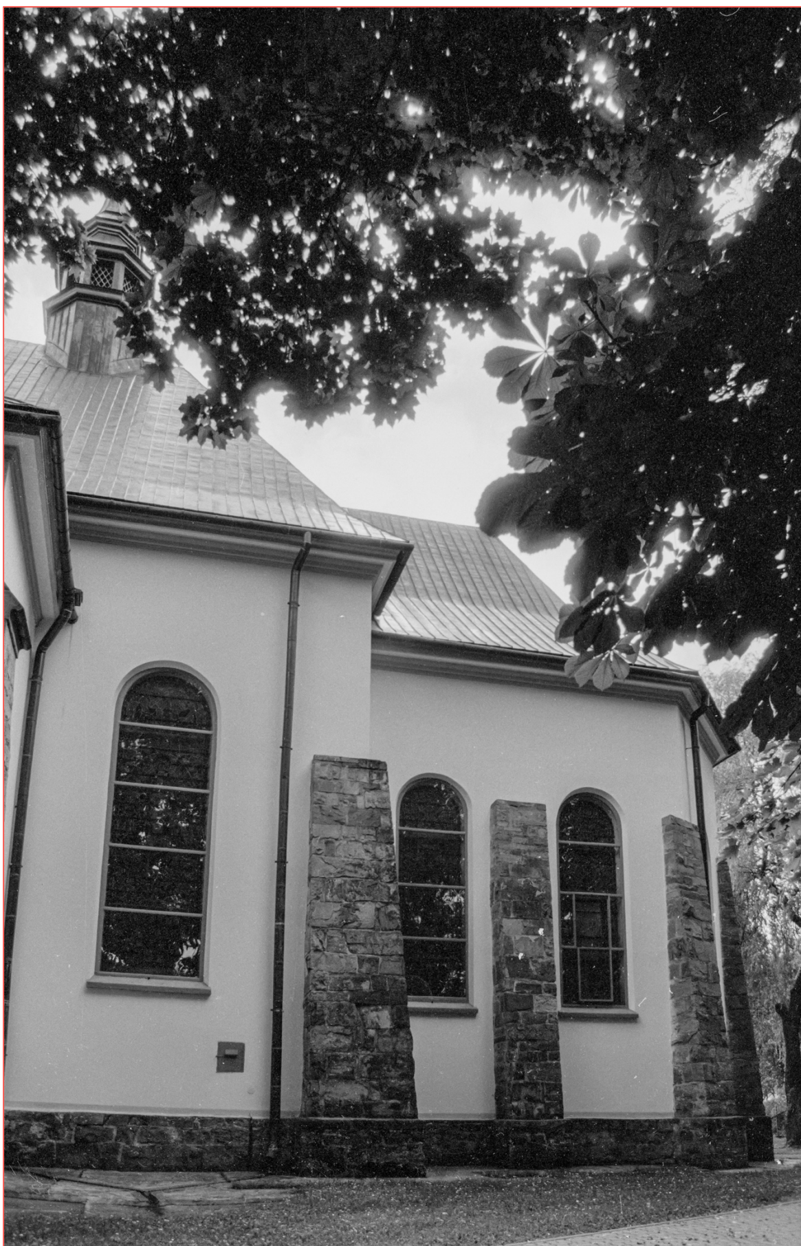
16. Widok fragmentu elewacji północnej. Fot. D. Moździerz, 15 VII 2000
