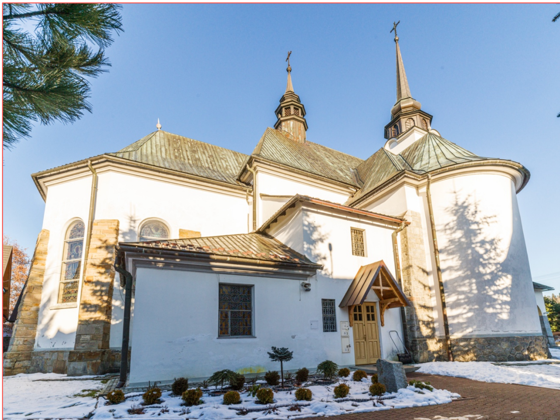
26. Fragment elewacji południowej. Fot. Z. Moździerz, 14 I 2023
