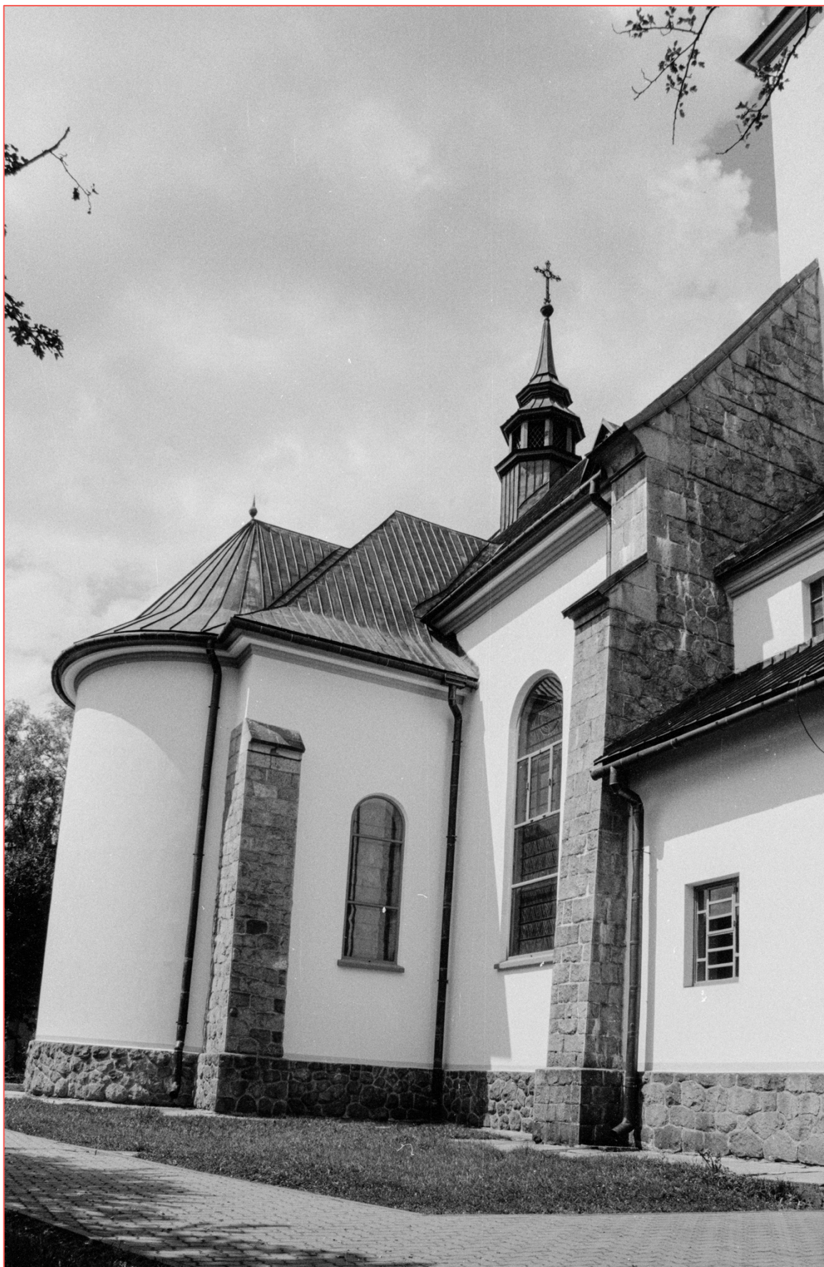
14. Widok fragmentu elewacji południowej. Fot. D. Moździerz, 15 VII 2000
