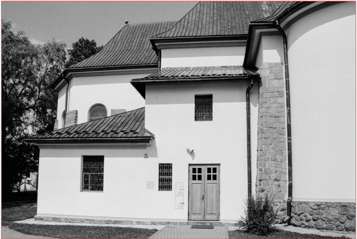
17. Widok fragmentu elewacji południowej. Fot. D. Moździerz, 15 VII 2000
