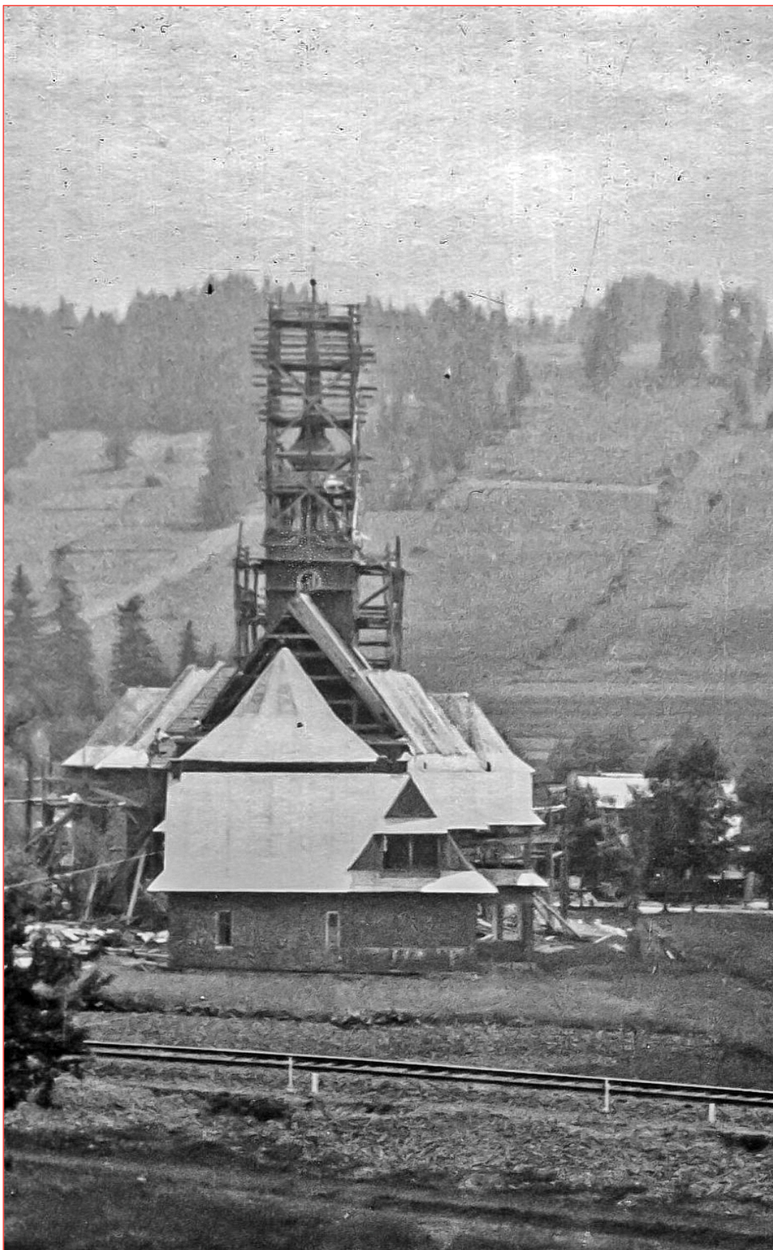
4. Budowa wieży – widok od strony zachodniej. Fot. 1936
