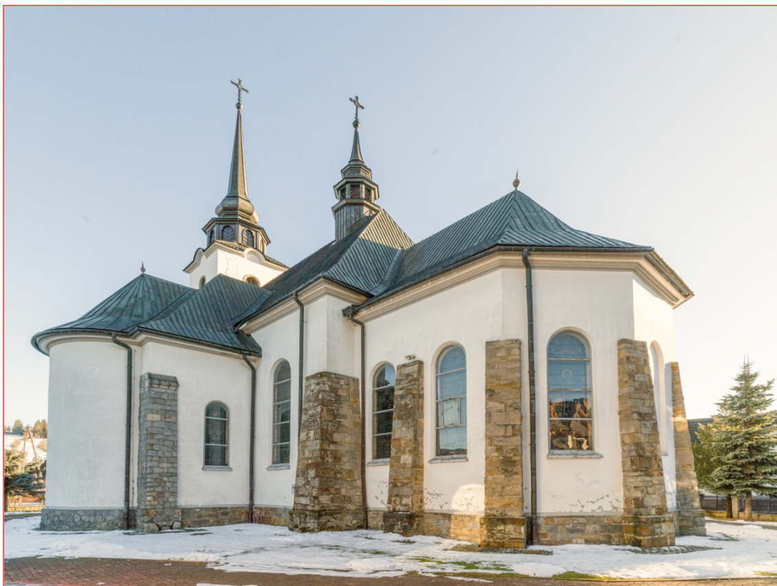
24. Widok od strony północno-zachodniej. Fot. Z. Moździerz, 14 I 2023
