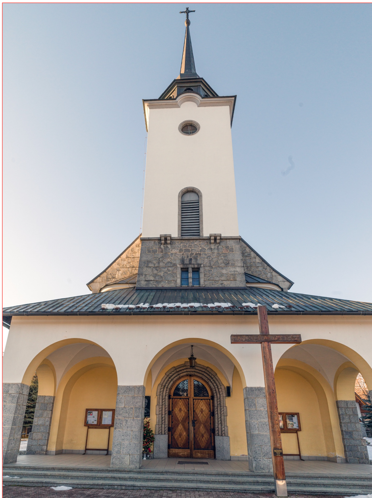
21. Widok elewacji frontowej (wschodniej). Fot. Z. Moździerz, 14 I 2023
