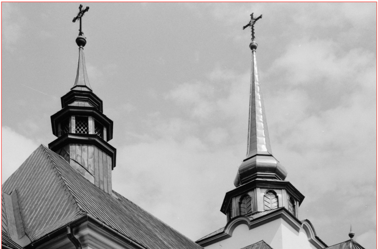
18. Widok na sygnaturkę i hełm wieży. Fot. D. Moździerz, 15 VII 2000
